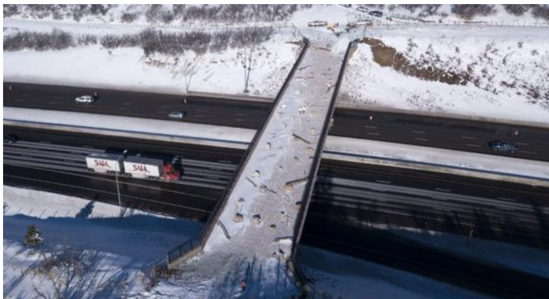
Obrázek 7: Ekodukt s mostovou konstrukcí (Murphy 2022).
