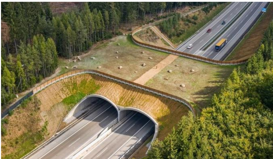
Obrázek 8: Ekodukt s tunelovou konstrukcí (Skanska 2021).
