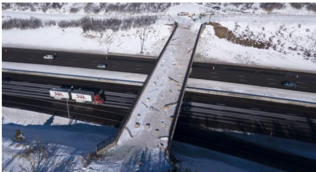
Obrázek 7: Ekodukt s mostovou konstrukcí (Murphy 2022).
