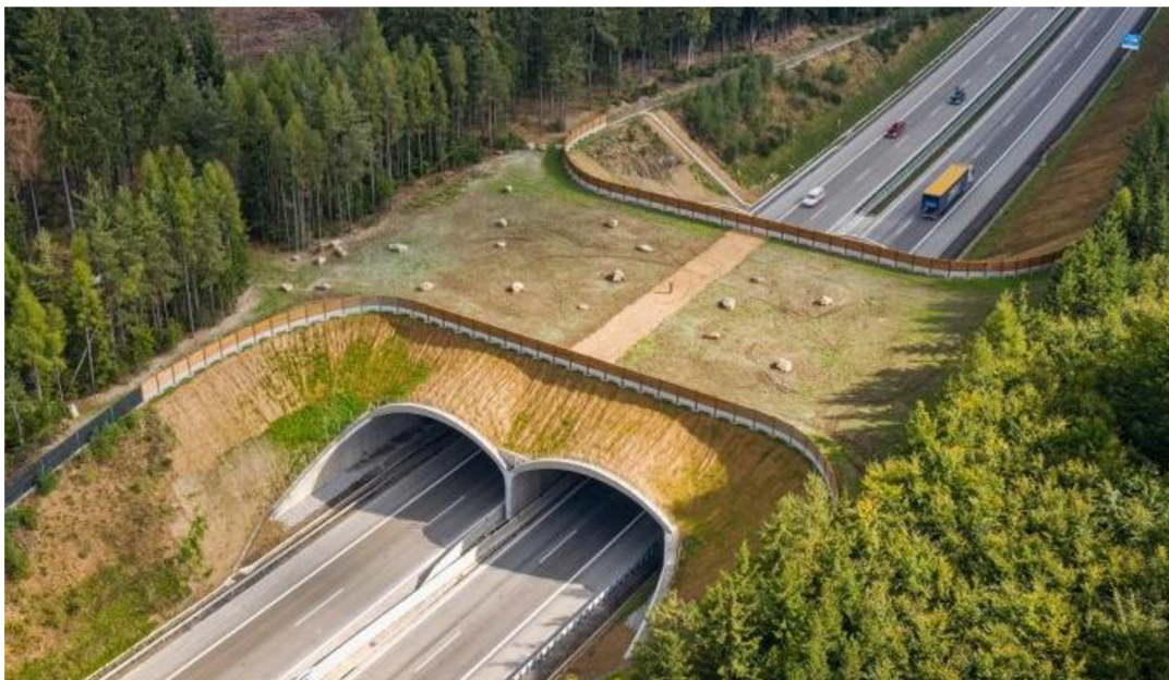
Obrázek 8: Ekodukt s tunelovou konstrukcí (Skanska 2021).
