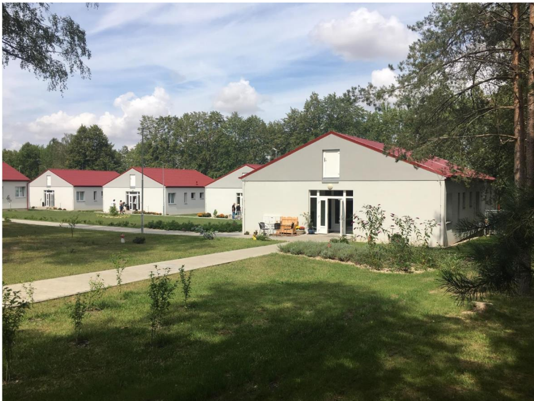
Obr. 3: Ubytovací prostory odsouzených v otevřené věznici dle stránek www.irozhlas.cz . 51
