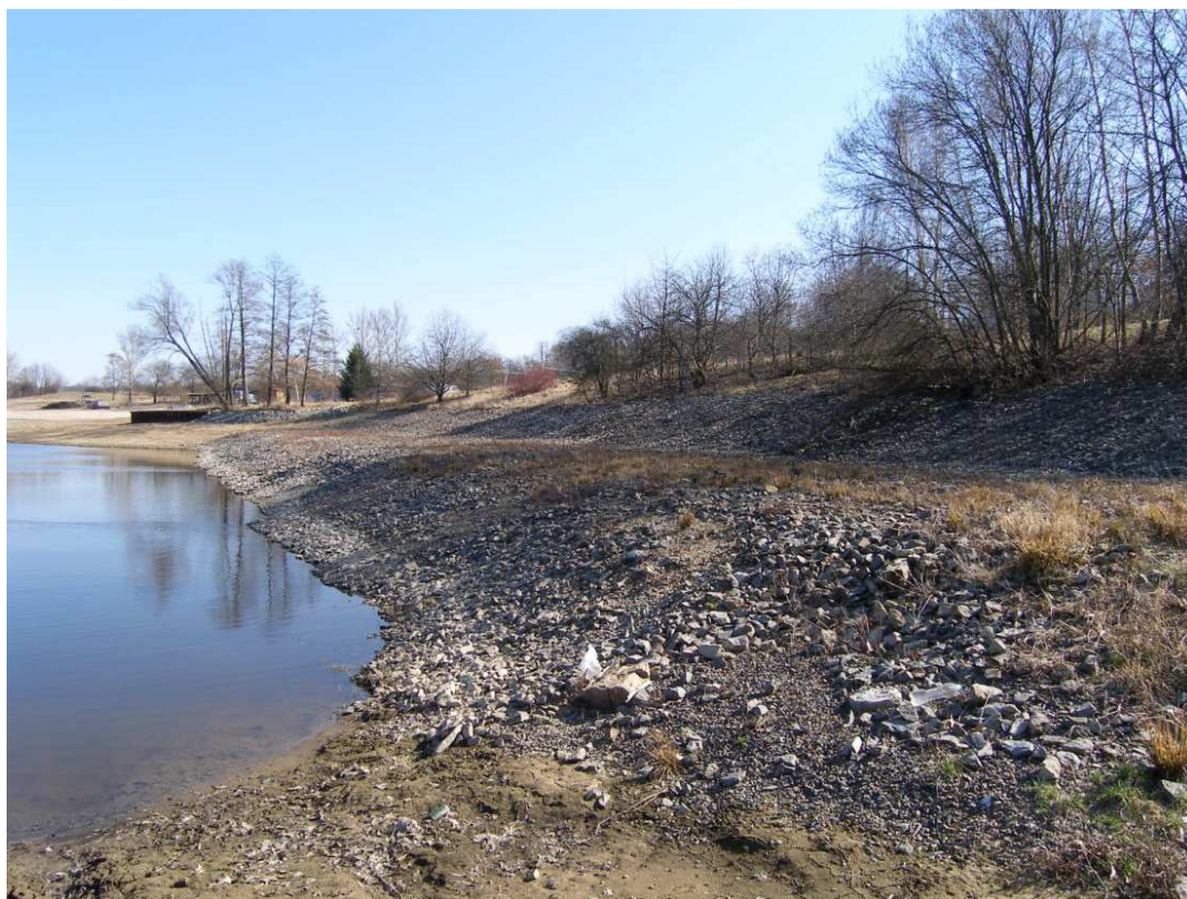
Obr. č. 34 - Kamenný zához mírně se svažujících břehů (autor práce, 20.03.2012).
