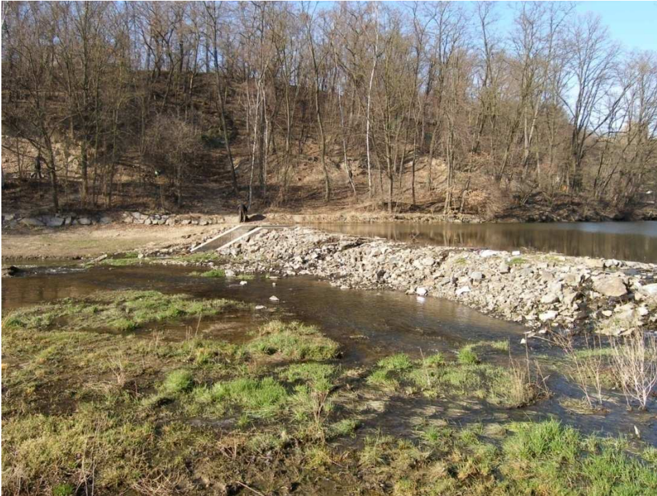
Obr. č. 22 - Dělicí přeronová hráz sloužící k zachycení sedimentu (autor práce, 20.03.2012).
