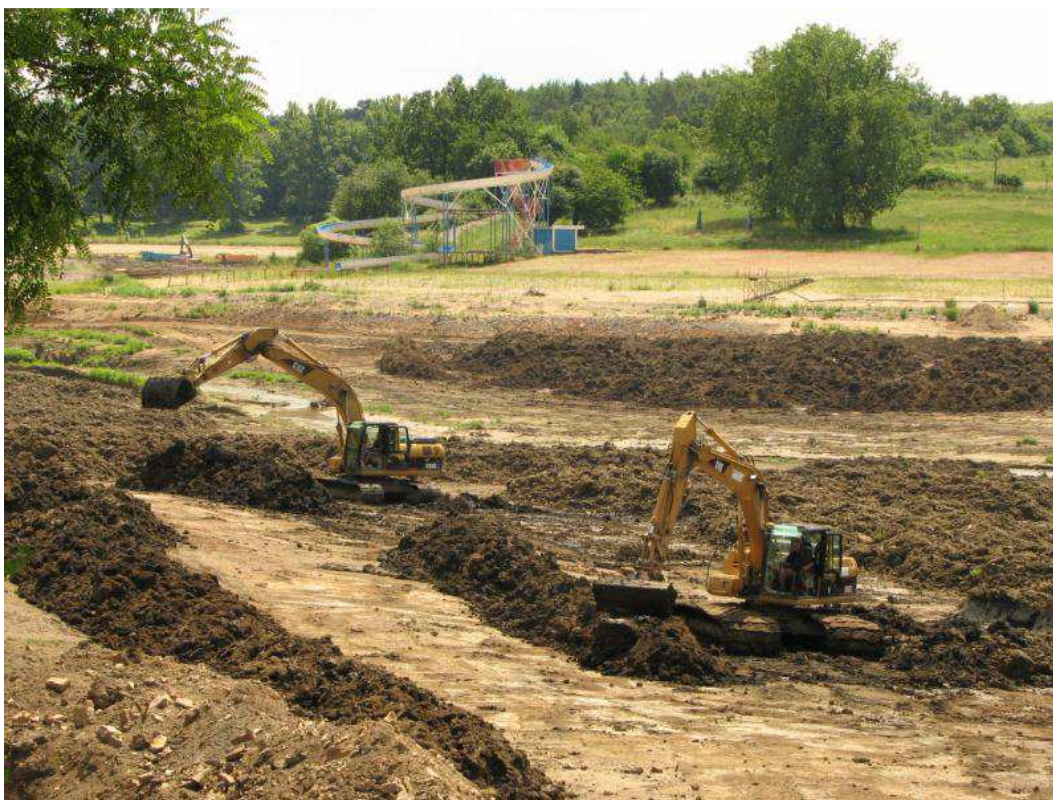
Obr. č. 08 - Těžba sedimentu suchou cestou – dolní část vodní nádrže Hostivař ( http://www.praha.eu , léto 2011).
