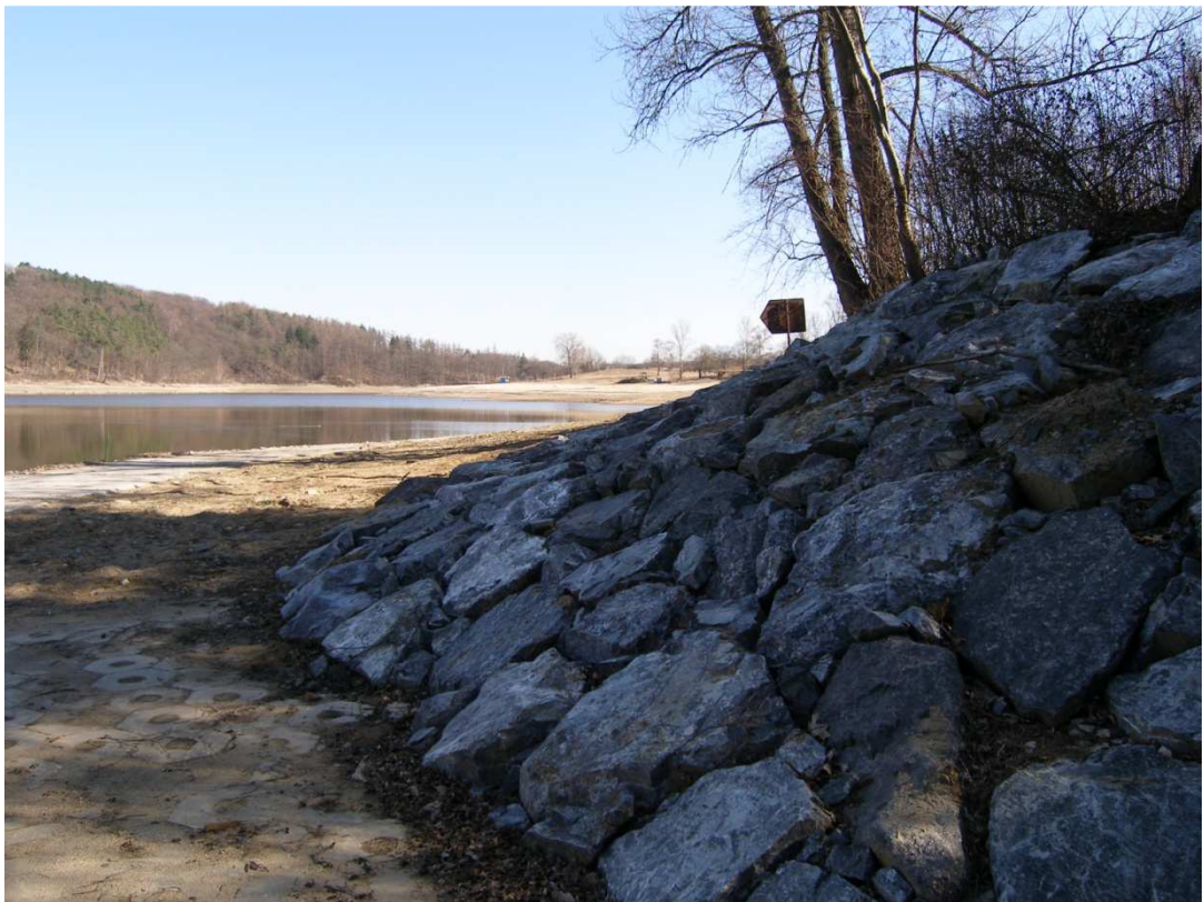
Obr. č. 33 - Sanace strmých břehů nádrže těžkými balvany (autor práce, 20.03.2012).
