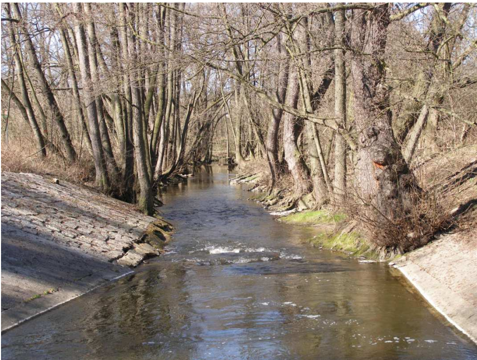
Obr. č. 21 - Odpadní koryto hned za vývarem, pokračuje meandry Botiče (autor práce, 25.03.2012).
