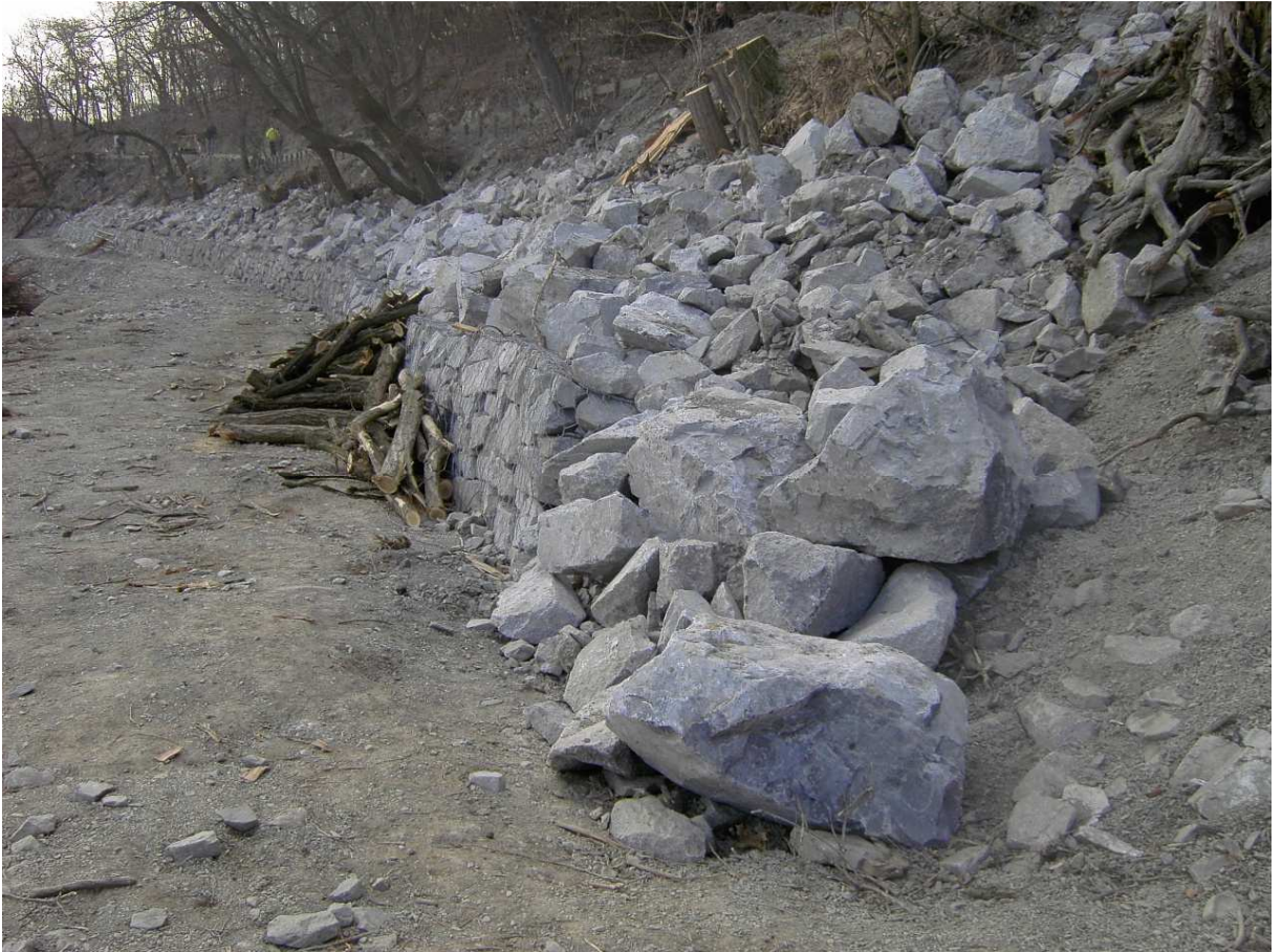
Příloha č. 3 - VD Hostivař – Zpevnění břehu (autor práce, 06.03.2011).
