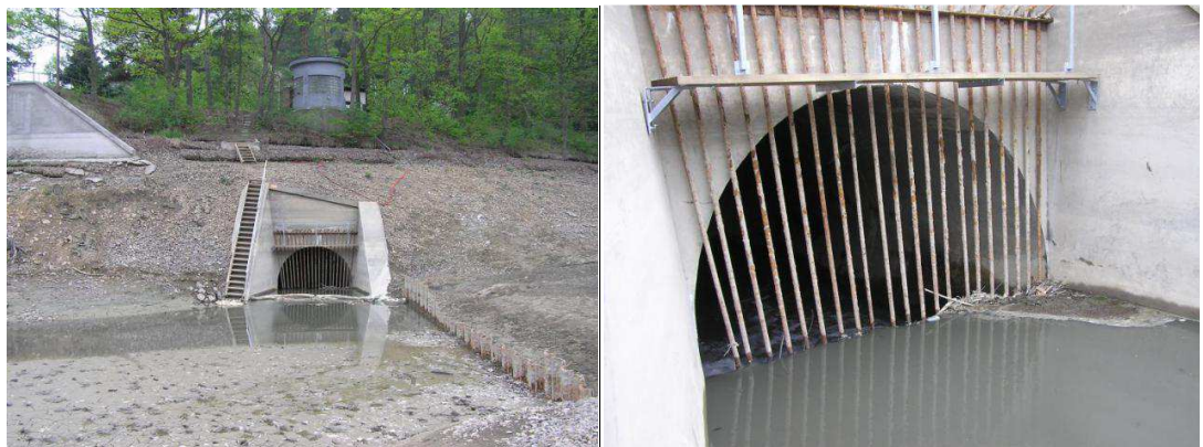
Obr. č. 15 a Obr. č. 16 - Spodní výpusti (Kefurt, 27.04.2011).
