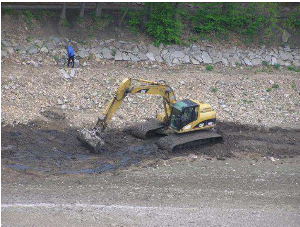
Obr. č. 09 - Těžba sedimentu suchou cestou – pravý břeh u hráze vodní nádrže Hostivař (Kefurt, 27.04.2011).
