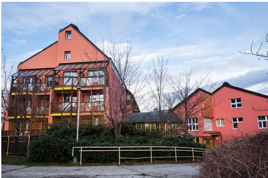
Obrázek 3: Domov pro seniory Háje exteriér budov
