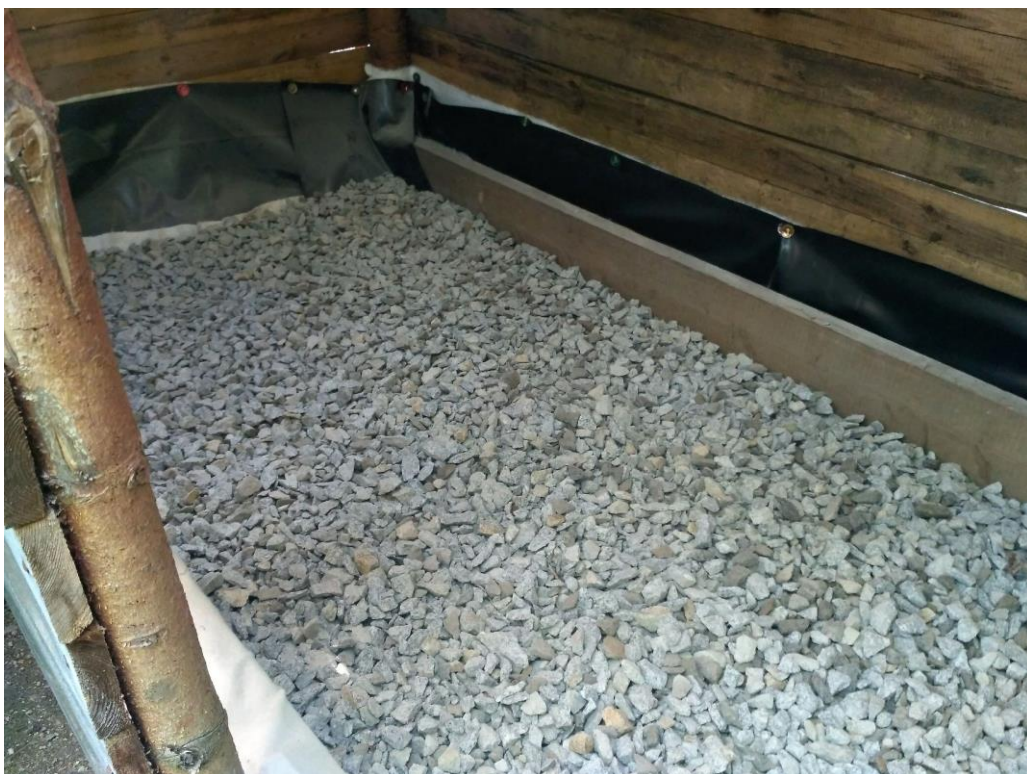
Obrázek 58: Zarovnání vrstvy šterku.
