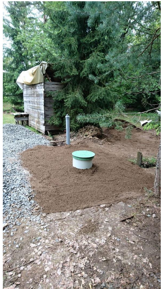
Obrázek 49: Instalace odvodušňovacího potrubí, finální vrstva geotextílie (vlevo), úprava okolního teréno (vpravo).
