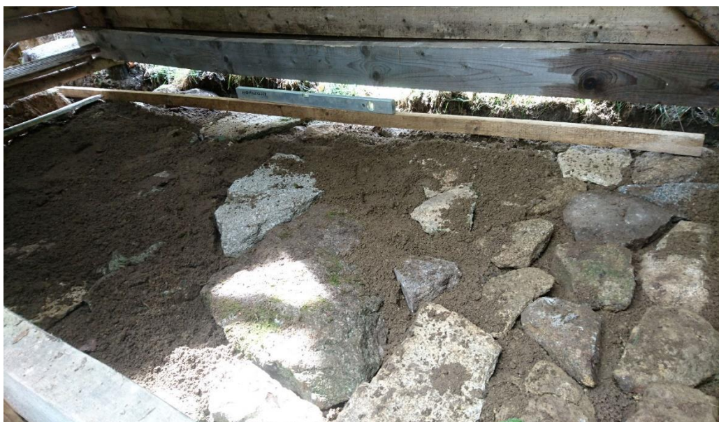
Obrázek 54: Příprava podkladu odvodnění táborové sprchy.
