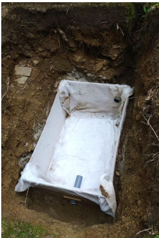
Obrázek 60: Zakrytí konstrukce geotextilií a usazení odtokového potrubí.
