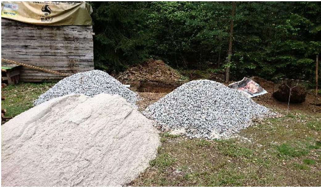
Obrázek 45: Prosévání zeminy, navážka náplně filtru.
