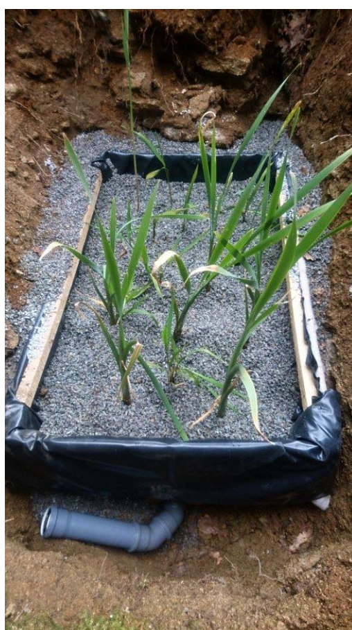
Obrázek 62: Instalace finální drobné štěrkové vrstvy přes vysazením rostlin (vlevo) a vysazení orobince do připraveného štěrkového lože. V popředí stavitelný odtok, na regulaci výše hladiny vody v KČOV.
