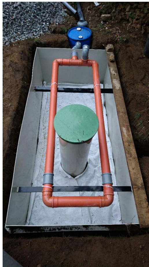
Obrázek 46: Usazení filtru, první vrstva šěrku (vlevo), geotextilní kryt před pískovou náplní (vpravo).
