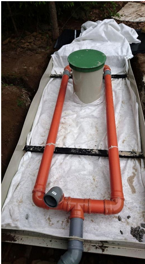
Obrázek 48: Geotextilní kryt před finální vrstvou štěrku (vlevo) a poslední vrstva štěrku (vpravo). Průběžně probíhající obsyp zeminou.
