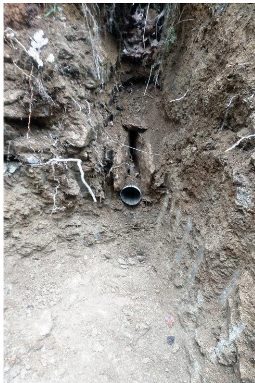
Obrázek 59: Terénní úpravy kamenitého podloží pro zbudování KČOV.
