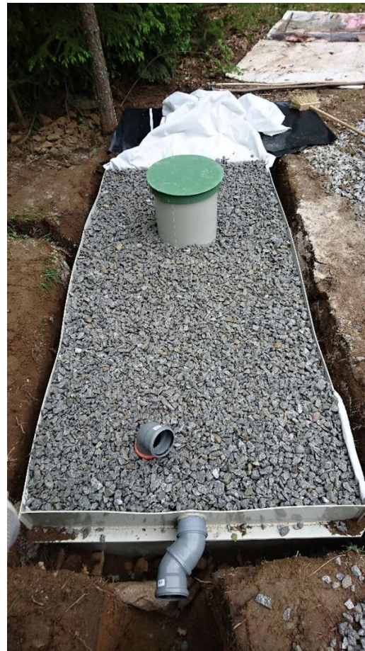
Obrázek 48: Geotextilní kryt před finální vrstvou štěrku (vlevo) a poslední vrstva štěrku (vpravo). Průběžně probíhající obsyp zeminou.
