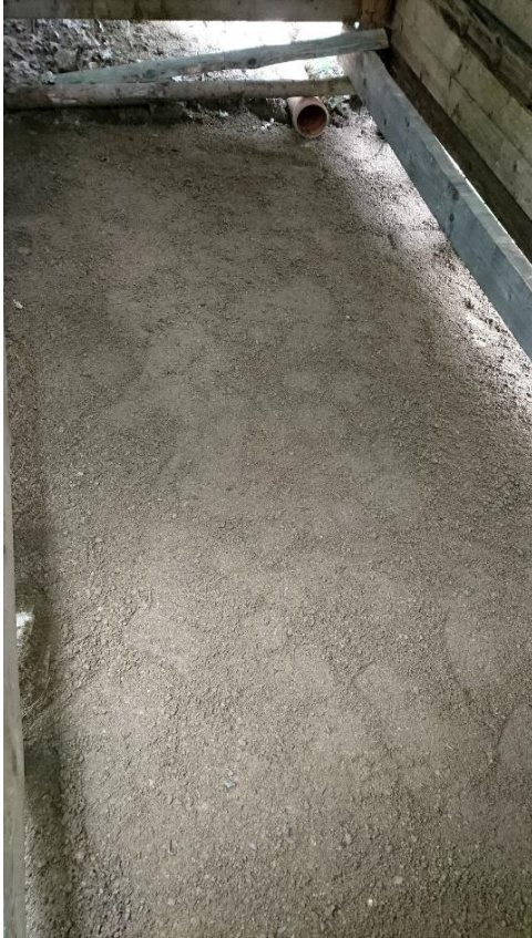
Obrázek 56: Vyspádování podkladu a instalace geotextílie proti poškození fólie.
