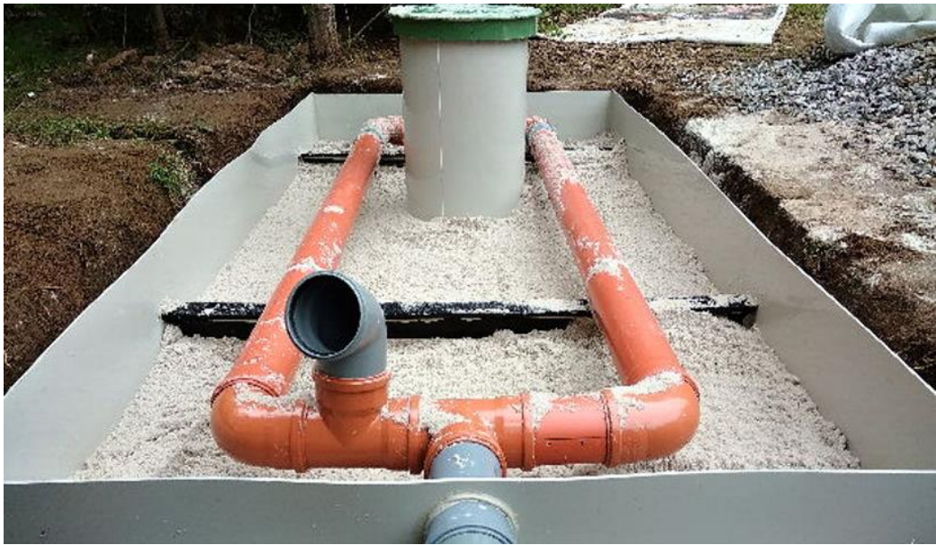
Obrázek 47: Kompletace pískové náplně.
