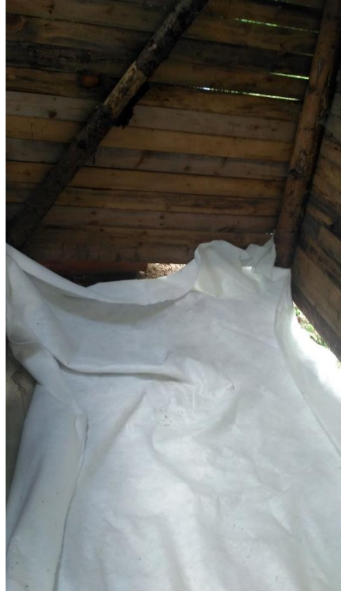
Obrázek 56: Vyspádování podkladu a instalace geotextílie proti poškození fólie.
