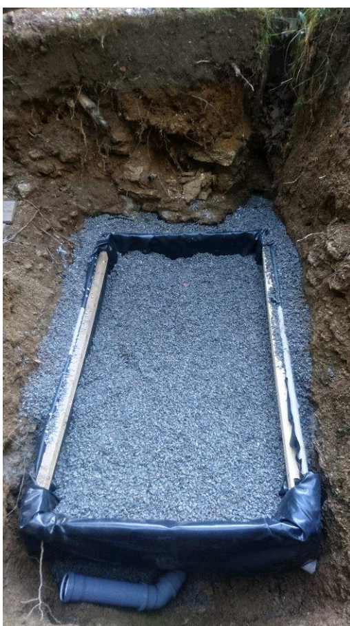
Obrázek 62: Instalace finální drobné štěrkové vrstvy přes vysazením rostlin (vlevo) a vysazení orobince do připraveného štěrkového lože. V popředí stavitelný odtok, na regulaci výše hladiny vody v KČOV.
