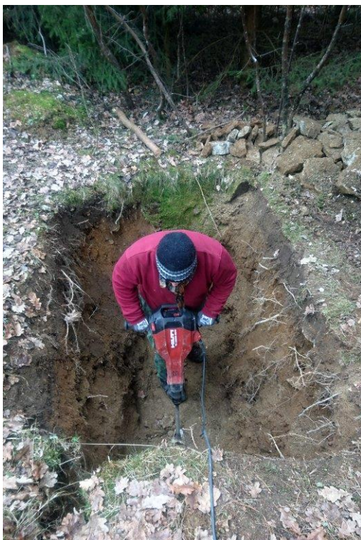
Obrázek 59: Terénní úpravy kamenitého podloží pro zbudování KČOV.
