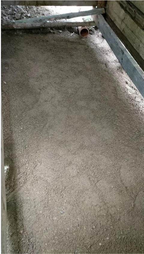
Obrázek 56: Vypádování podkladu a instalace geotextílie proti poškození fólie.
