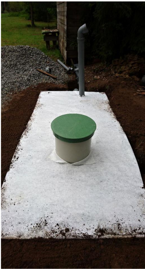
Obrázek 49: Instalace odvodušňovacího potrubí, finální vrstva geotextílie (vlevo), úprava okolního terénu (vpravo).
