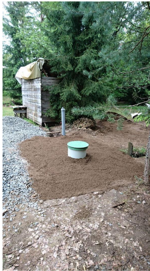
Obrázek 49: Instalace odvodušňovacího potrubí, finální vrstva geotextílie (vlevo), úprava okolního terénu (vpravo).
