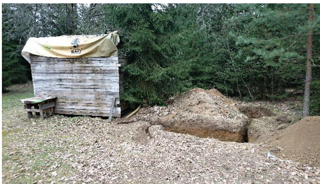
Obrázek 44: Výkopové práce, v pozadí odtoková jáma, vlevo táborová sprcha.
