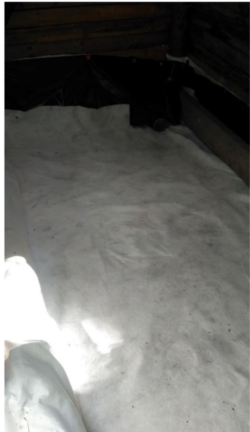
Obrázek 55: Instalace jezírkové fólie a její následné překrytí ochrannou geotextílií.
