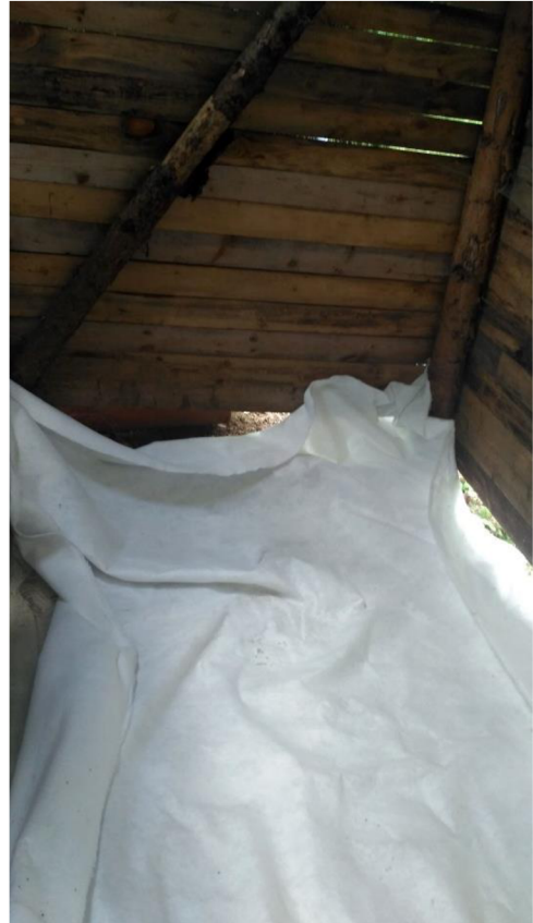
Obrázek 56: Vypádování podkladu a instalace geotextílie proti poškození fólie.
