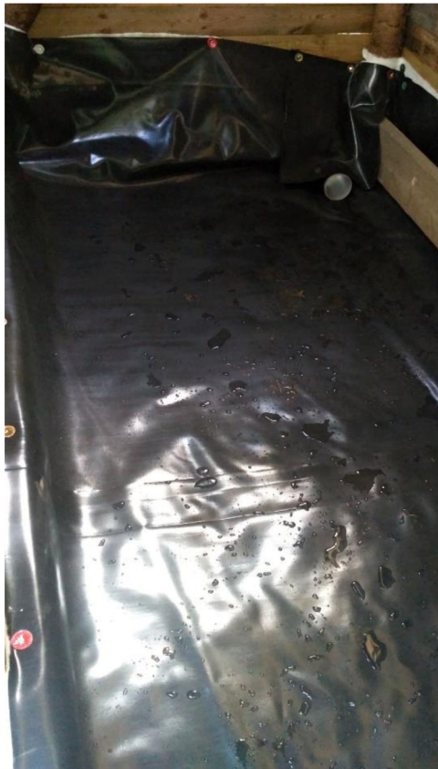
Obrázek 55: Instalace jezírkové fólie a její následné překrytí ochrannou geotextílií.
