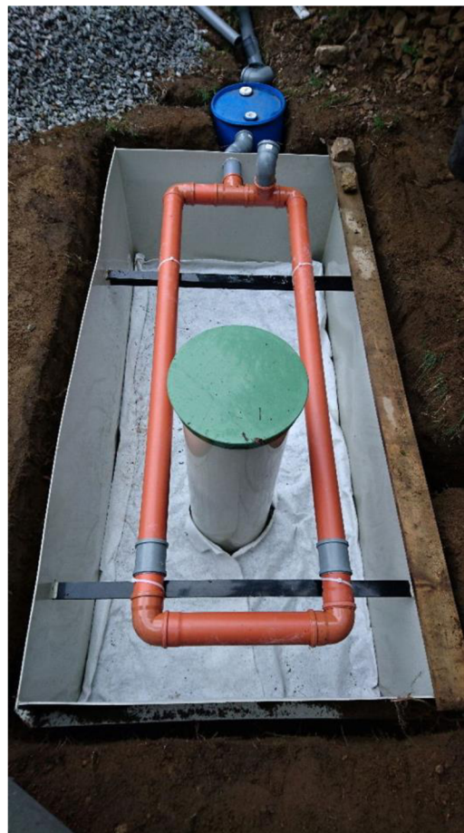
Obrázek 46: Usazení filtru, první vrstva štěrku (vlevo), geotextilní kryt před pískovou náplní (vpravo).
