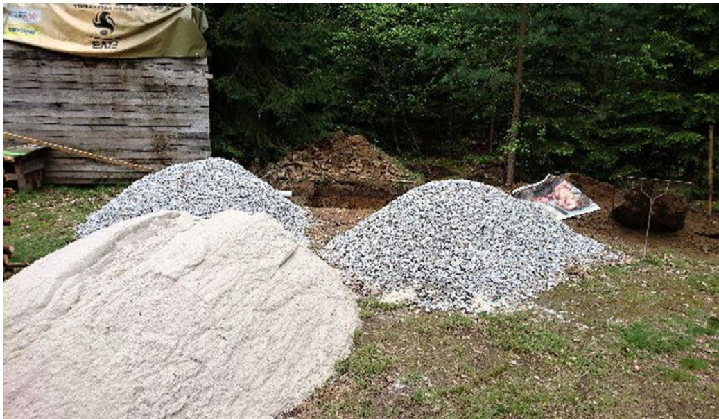
Obrázek 45: Prosévání zeminy, navážka náplně filtru.
