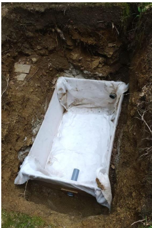
Obrázek 60: Zakrytí konstrukce geotextilií a usazení odtokového potrubí.
