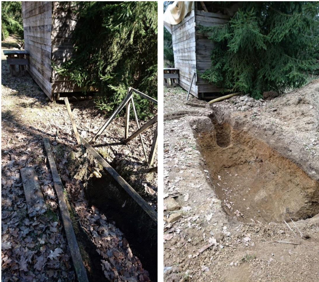
Obrázek 43: Vsakovací jáma - původní stav (vlevo) a výkopové práce (vpravo).
