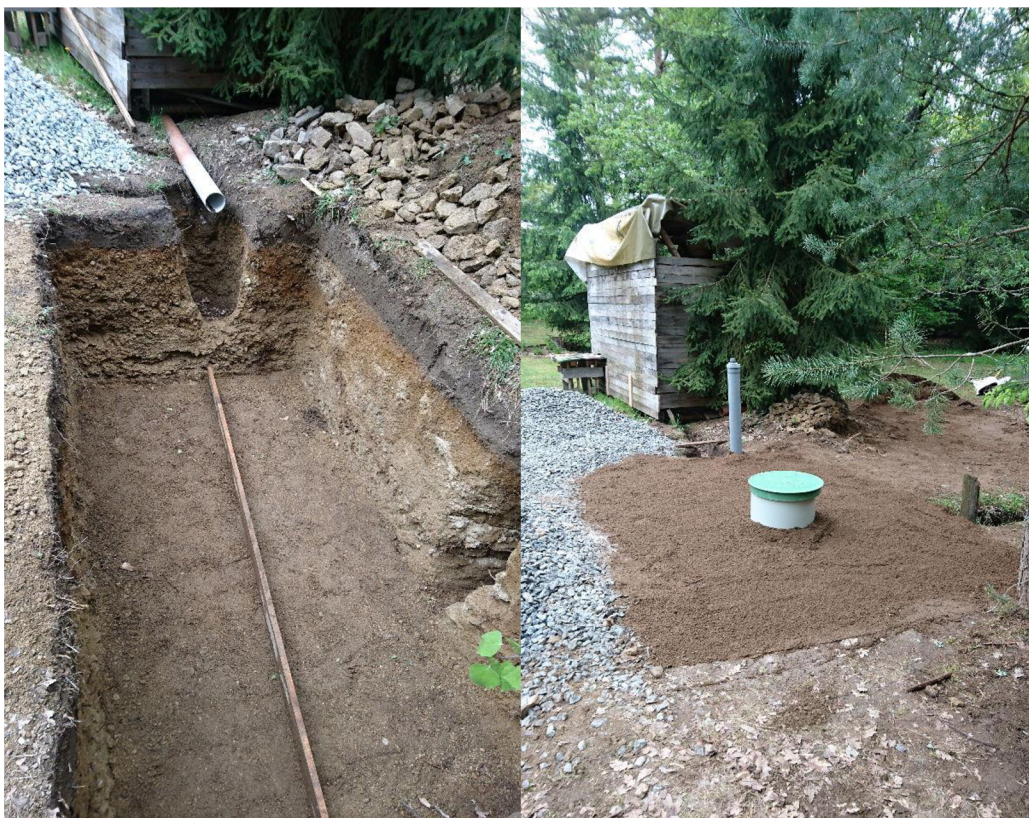
Obrázek 18: Realizace experimentálního zemního pískového filtru, vlevo výkopové práce před usazením filtru, vpravo finální úprava po usazení.
