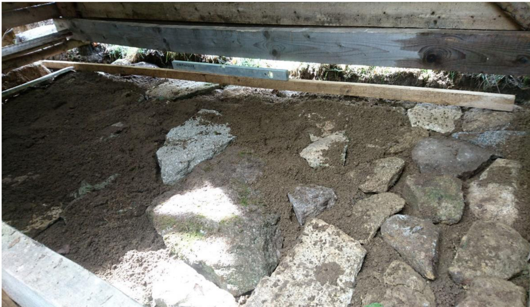
Obrázek 54: Příprava podkladu odvodnění táborové sprchy.
