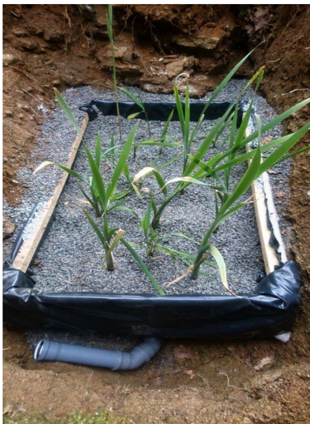
Obrázek 20: Vysazení orobince do připraveného štěrkového lože. V popředí stavitelný odtok, na regulaci výše hladiny vody v KČOV.
