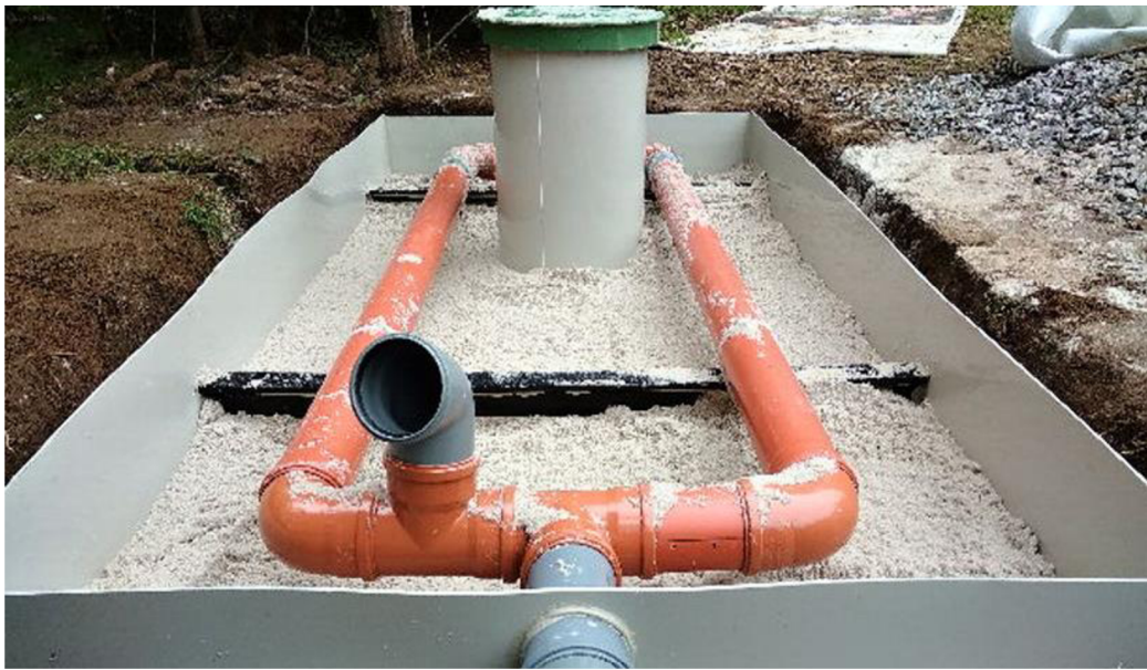
Obrázek 47: Kompletace pískové náplně.
