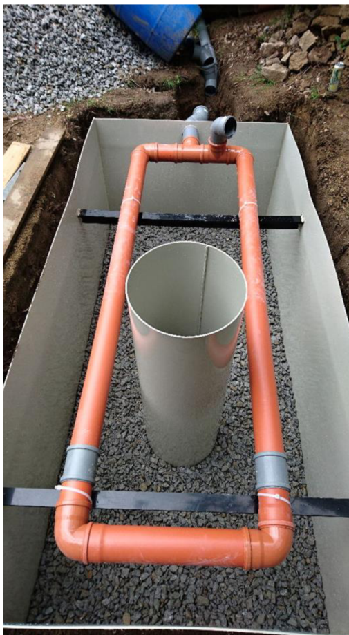
Obrázek 46: Usazení filtru, první vrstva štěrku (vlevo), geotextilní kryt před pískovou náplní (vpravo).
