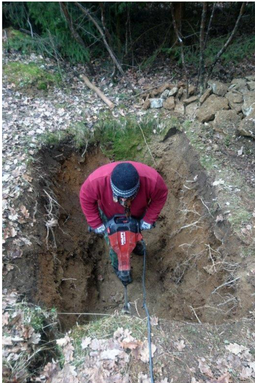
Obrázek 59: Terénní úpravy kamenitého podloží pro zbudování KČOV.
