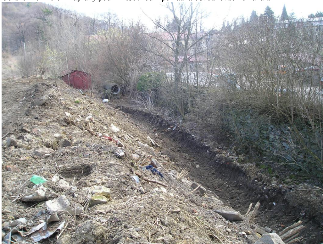
Obrázek 29 Terénní úpravy pod Milešovkou – pokládka odvodňovacího kanálu
