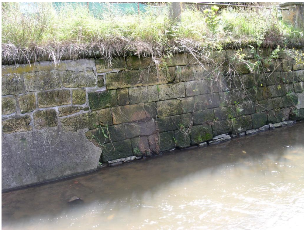
Obrázek 24 Nábřežní opěrná zed' Úštěk – původní stav
