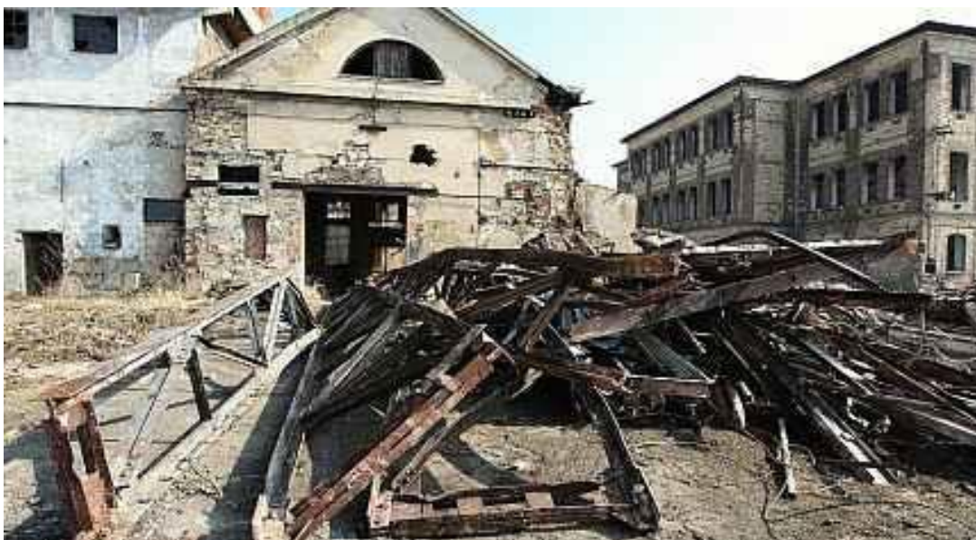
Obr. 2: Bývalá koželužna v Žalhosticích (Pech, 2011).
