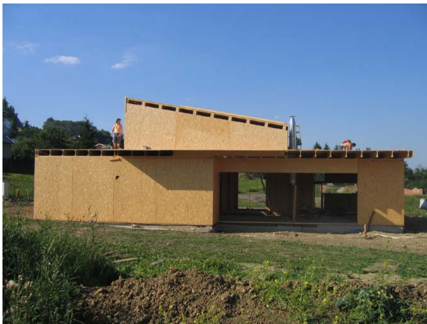
obr. 26 Rodinný dům v Kopřivnici, hrubá stavba, autor Kamil Mrva, 2006.
