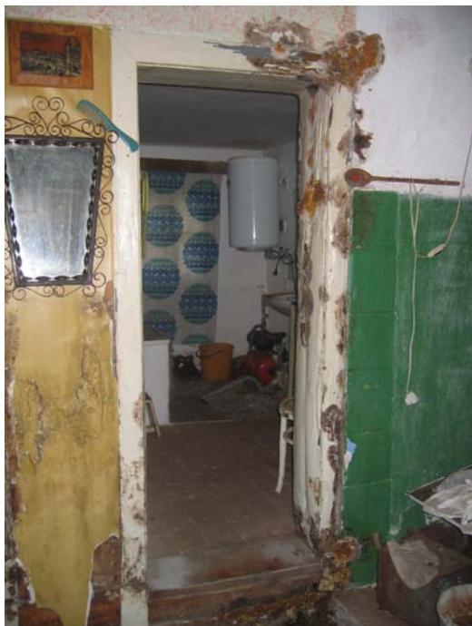
obr. 54 Rozšíření dřevokazné houby z podlahy do konstrukcí.
