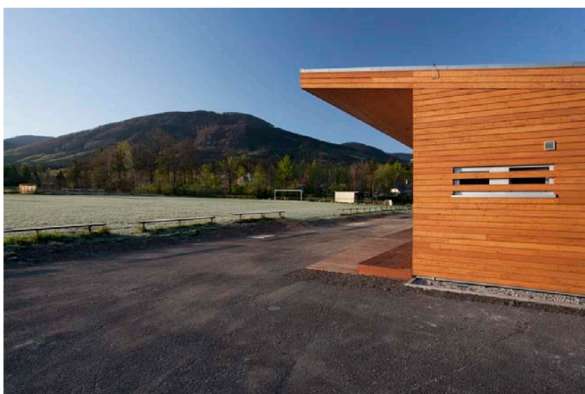
obr. 47 Fotbalové zázemí TJ Bystré, autor Kamil Mrva, 2010.
