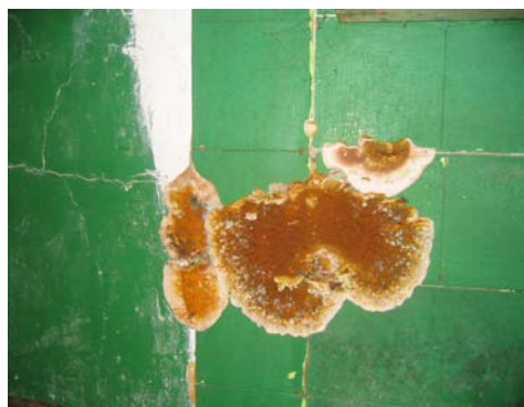
obr. 55 Rozšíření dřevokazné houby z podlahy do konstrukcí.
