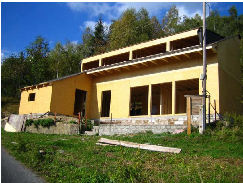
obr. 52 Hrubá stavba nově navrženého nízko-energetického domu, 2006.
