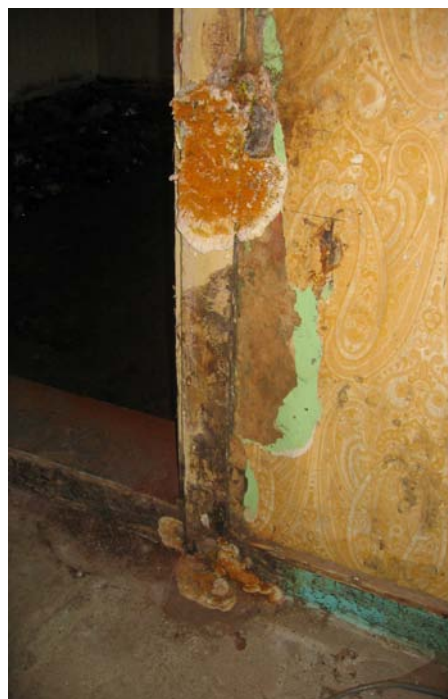
obr. 54 Rozšíření dřevokazné houby z podlahy do konstrukcí.
