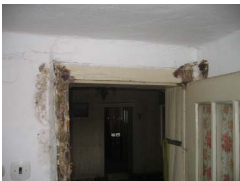
obr. 55 Rozšíření dřevokazné houby z podlahy do konstrukcí.
