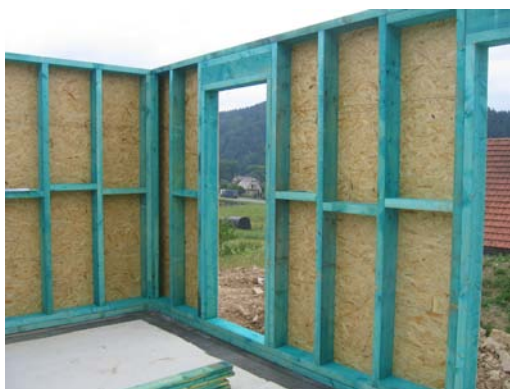
obr.21 Rodinný dům na Dolní Bečvě, fošinková konstrukce, autor Kamil Mrva, 2006.
