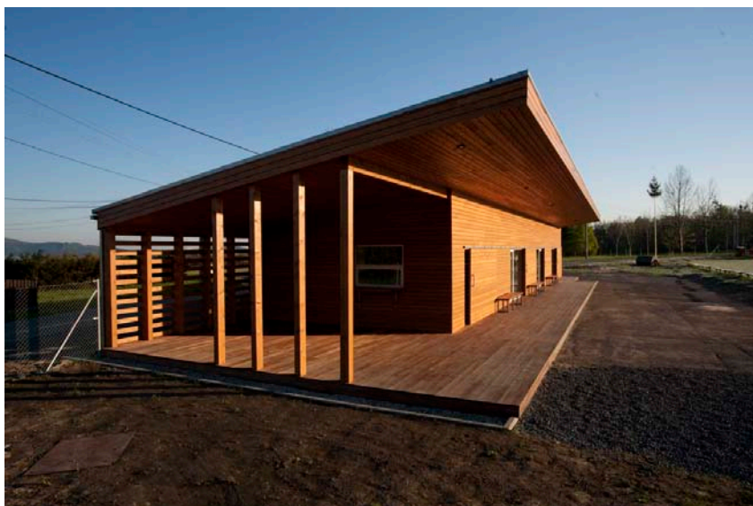
obr. 46 Fotbalové zázemí TJ Bystré, autor Kamil Mrva, 2010.
