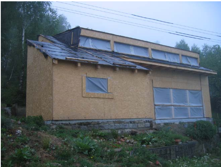
obr. 51 Nově navržená dřevěná fošinková konstrukce domu, 2006.
