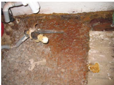
obr. 56 Dřevokazná houba na podlaze v koupelně po oddělení podlahy.
