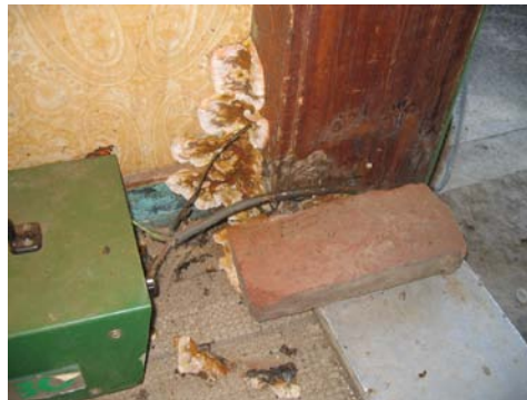
obr. 56 Dřevokazná houba na podlaze v koupelně po oddělení podlahy.
