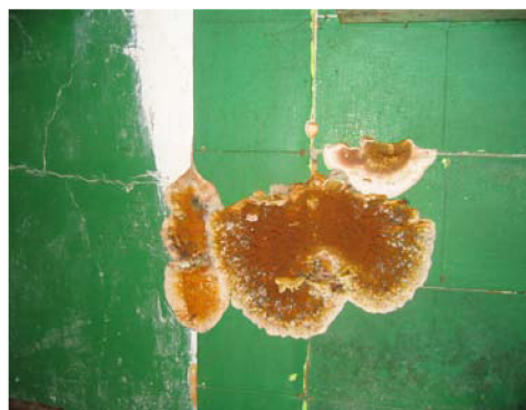
obr. 55 Rozšíření dřevokazné houby z podlahy do konstrukcí.
