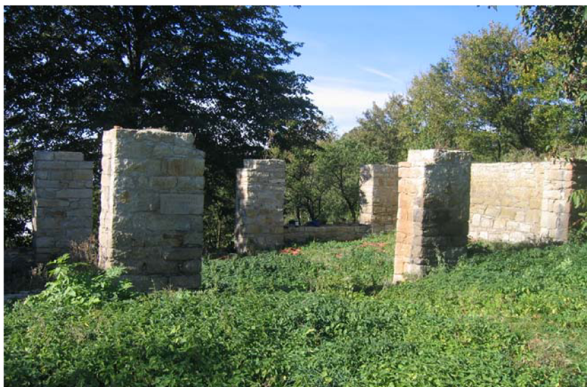
obr. 27 Rodinný dům v Kojetíně, původní stav, 2006.
