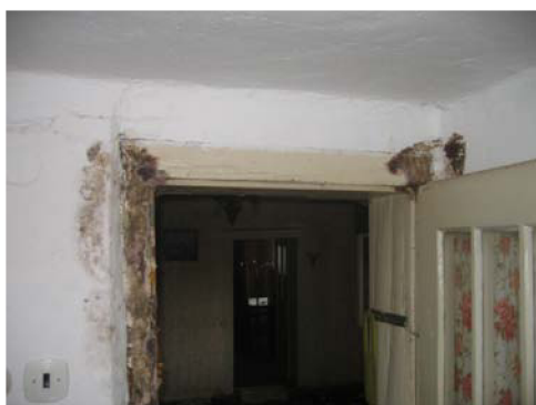
obr. 55 Rozšíření dřevokazné houby z podlahy do konstrukcí.
