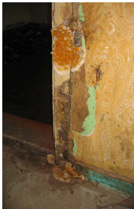
obr. 54 Rozšíření dřevokazné houby z podlahy do konstrukcí.
