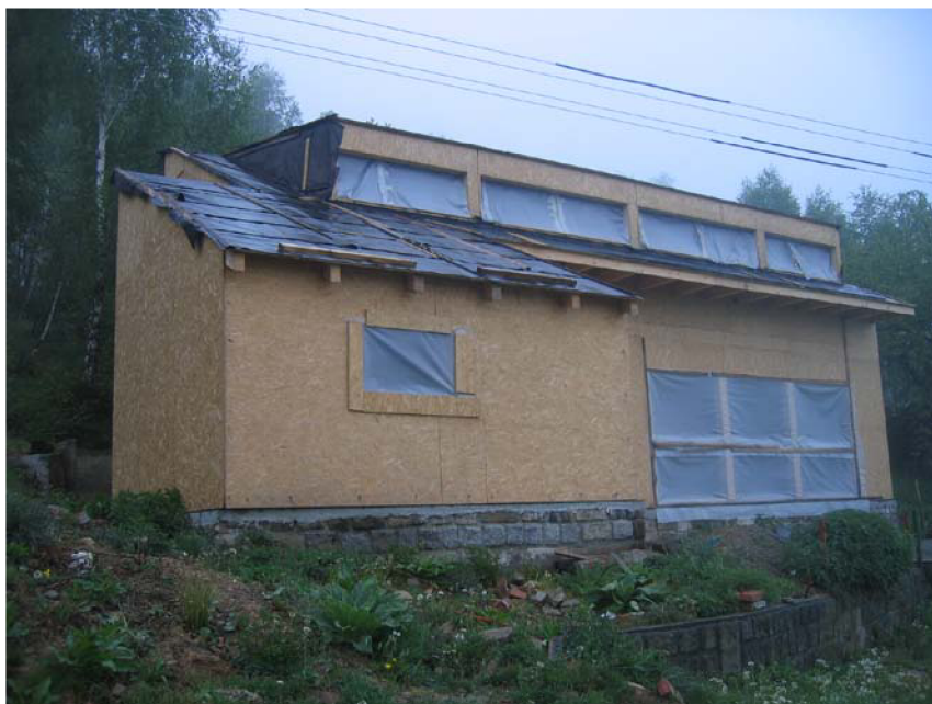
obr. 51 Nově navržená dřevěná fošinková konstrukce domu, 2006.
