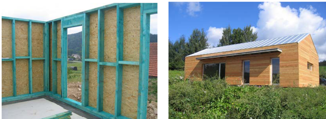
obr.21 Rodinný dům na Dolní Bečvě, fošinková konstrukce, autor Kamil Mrva, 2006.
