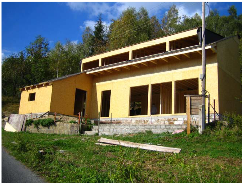
obr. 52 Hrubá stavba nově navrženého nízko-energetického domu, 2006.
