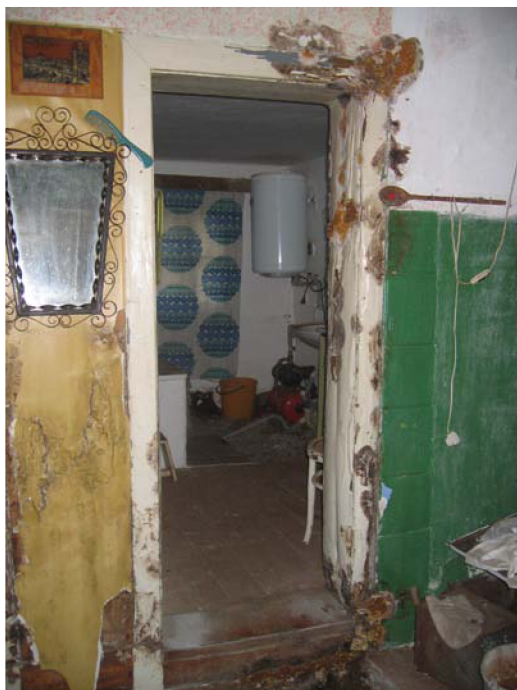
obr. 54 Rozšíření dřevokazné houby z podlahy do konstrukcí.
