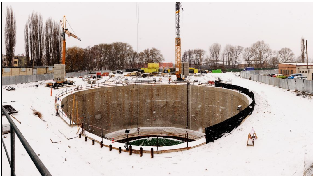
Obr. 6 Výstavba podzemní kruhové dešťové zdrže a retenční nádrže v Brně – Komárov (Brněnské vodárny a kanalizace, a. s., 2012)
