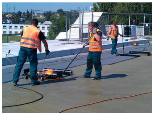
Obr.9.4: natavování pásů PARAPLAST
