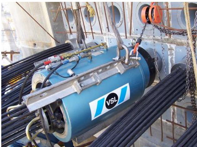
Obr.6.37: předpínací lis K500
