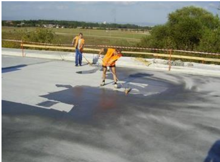
Obr 9.2: nanášení nátěru Mastertop P 605
