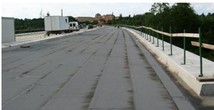
Obr. 9.3: mostovka opatřená pásy PARAPLAST
