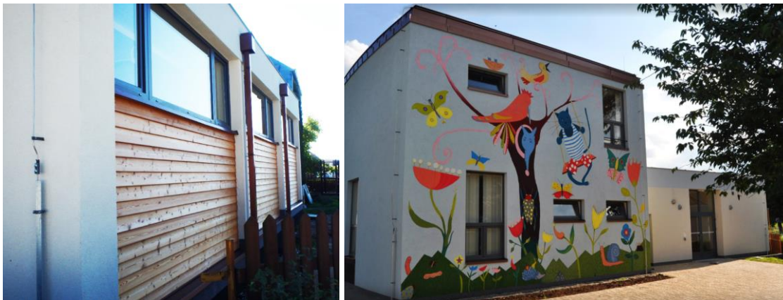
Obr. 9 Pohledy na budovu mateřské školy v obci Dříteč [autor]
