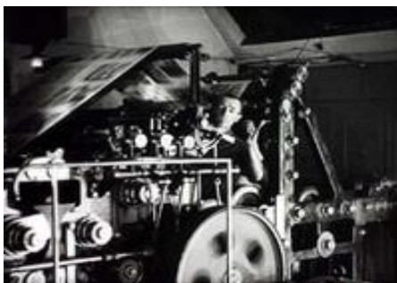
Obrázek 9: Sázecí stroj „Linotype“
