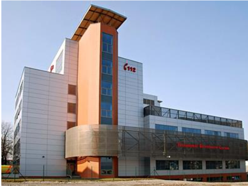
Obr. č. 5 – Integrované bezpečnostní centrum v Ostravě. 78
