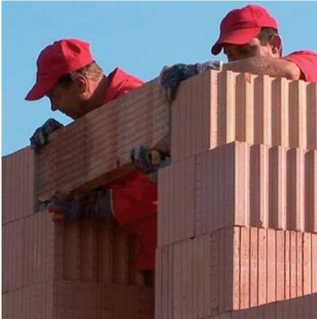
Obrázek 5- Osazení překlada (Zdroj: [27])
