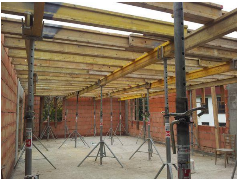
Obrázek 6- Vybudování bednění (Zdroj: [29])
