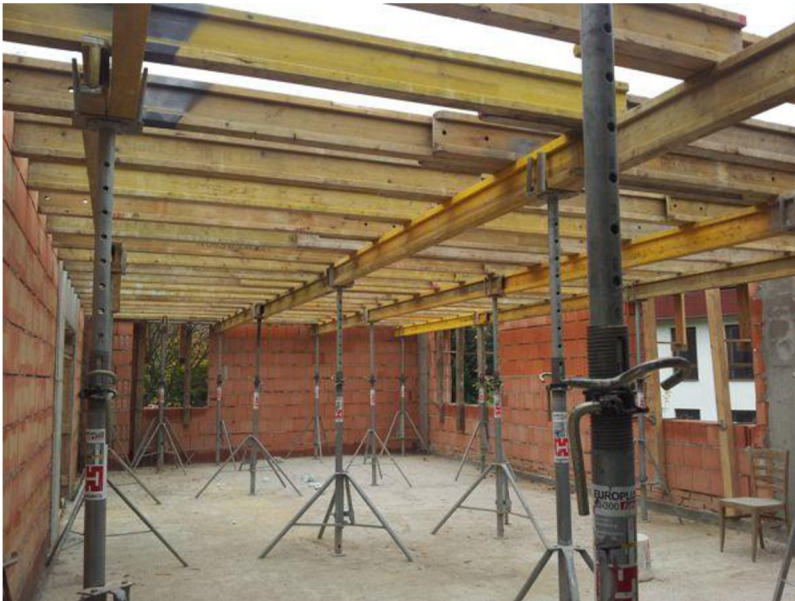
Obrázek 6- Vybudování bednění (Zdroj: [29])
