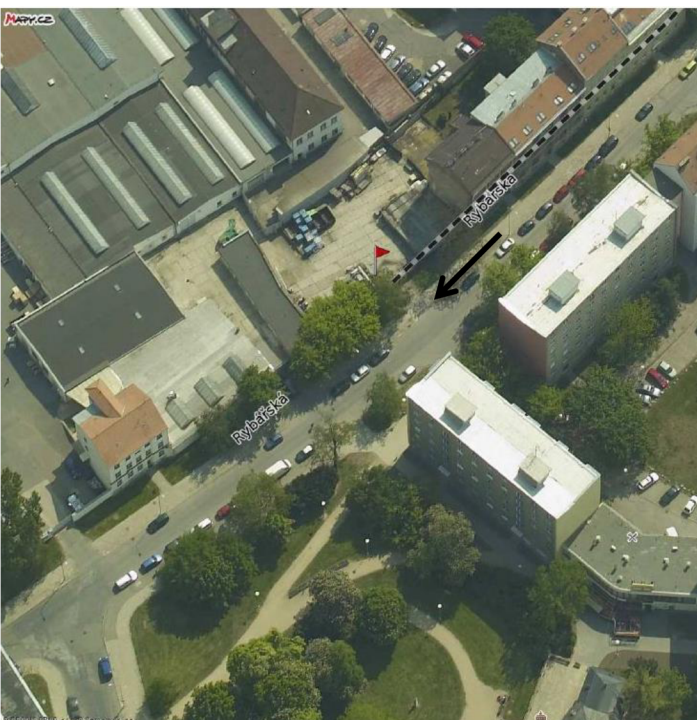
Obrázek 8- B – 6, příjezd na staveniště z ulice Rybářská (Zdroj: [26])
