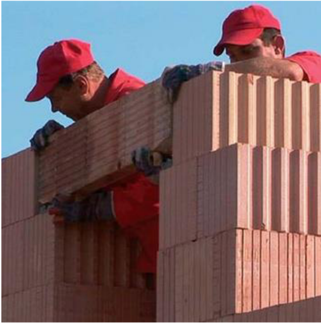
Obrázek 5-Osazení překlada (Zdroj: [27])
