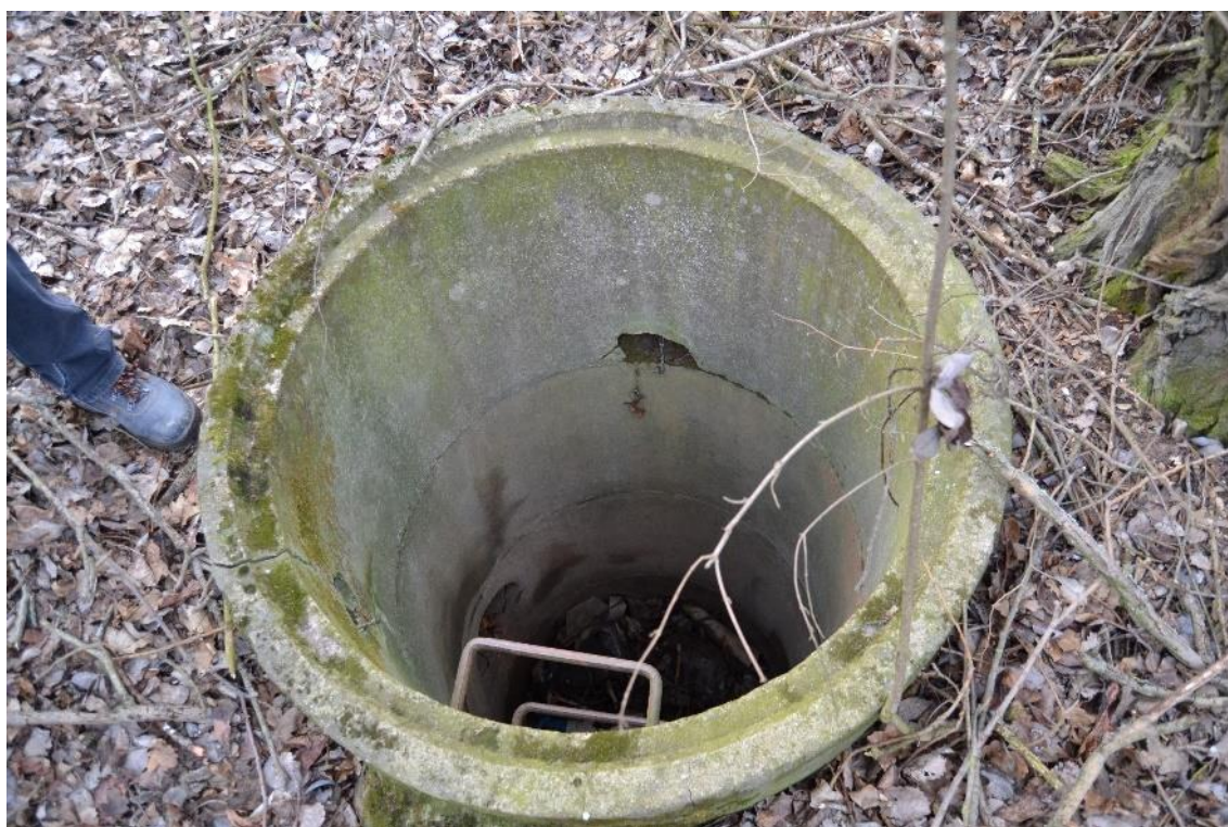
Obr. 8 Jímka středové kanalizace u obce Sudice (M. Sedlák, březen 2019)
