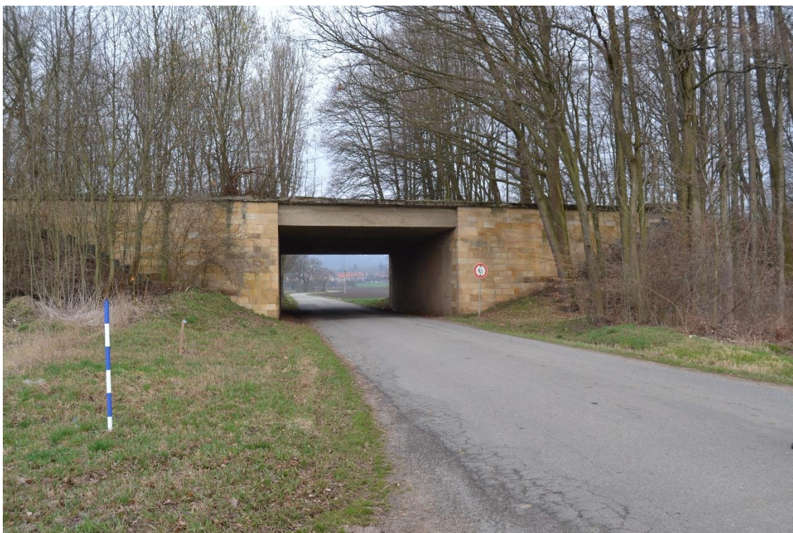
Obr. 2 Deskový most (M. Sedlák, březen 2019)
