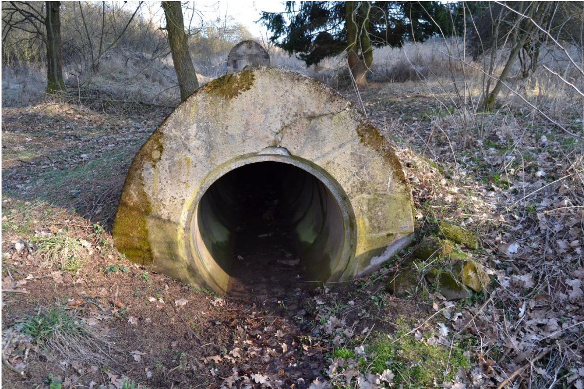
Obr. 1 Trubní propustek (M. Sedlák, březen 2019)
