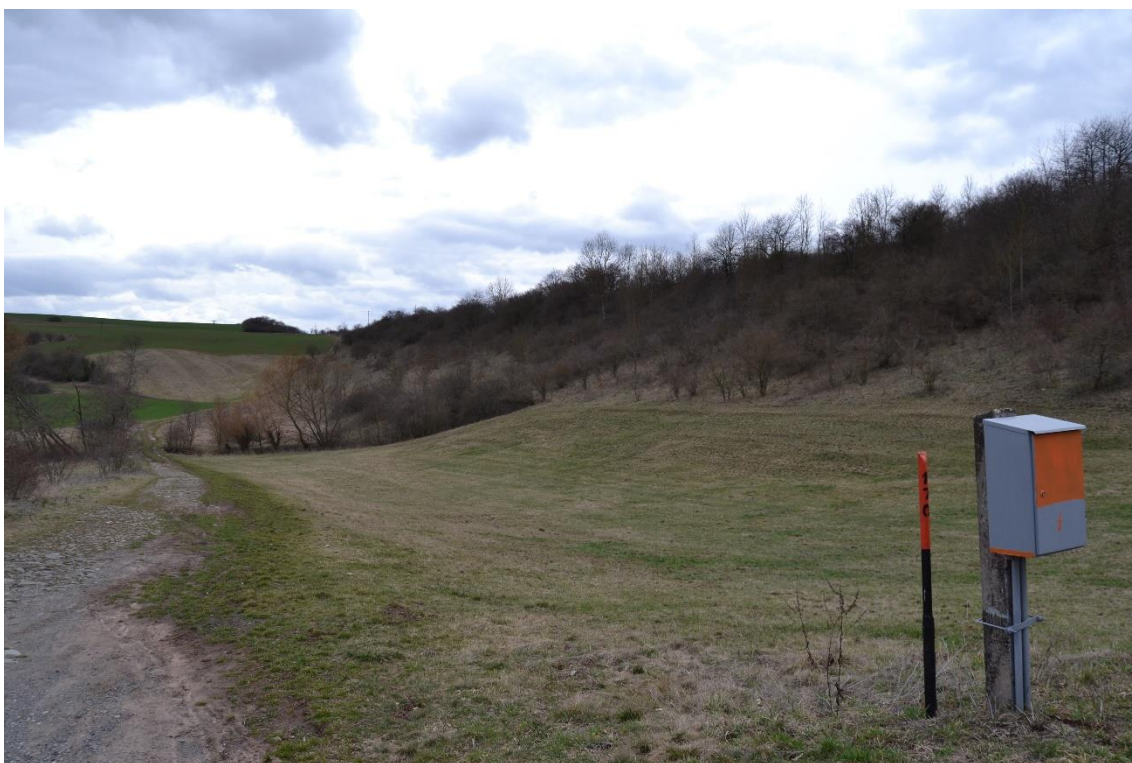
Obr. 7 Nejvyšší násep na nedokončené dálnici. Dosahuje výšky 28 metrů nad okolní terén (M. Sedlák, březen 2019)
