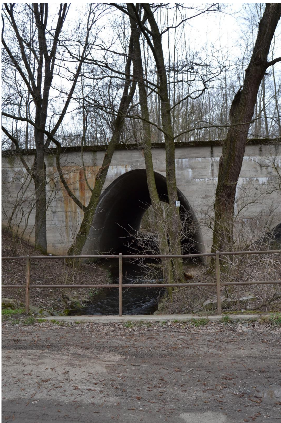
Obr. 52 Most (M. Sedlák, březen 2019)
