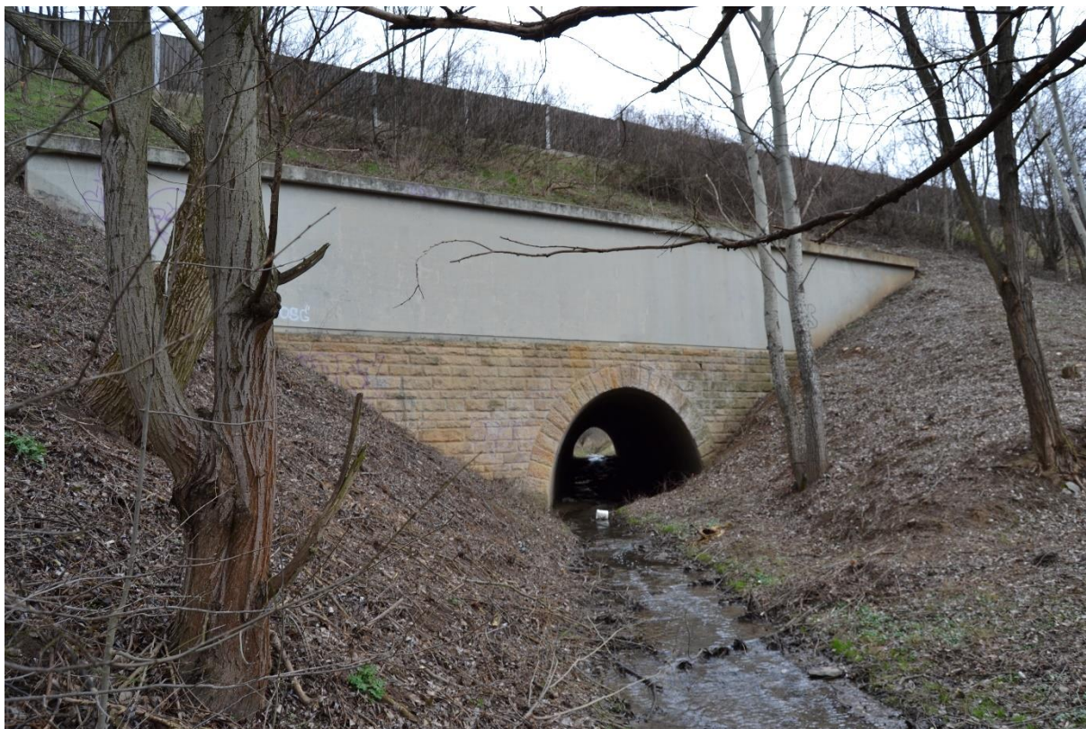
Obr. 114 Most (M. Sedlák, březen 2019)
