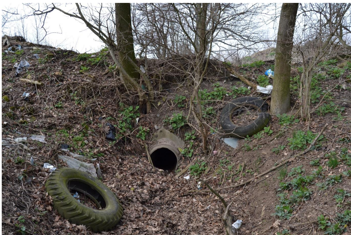
Obr. 23 Trubní propustek (M. Sedlák, březen 2019)
