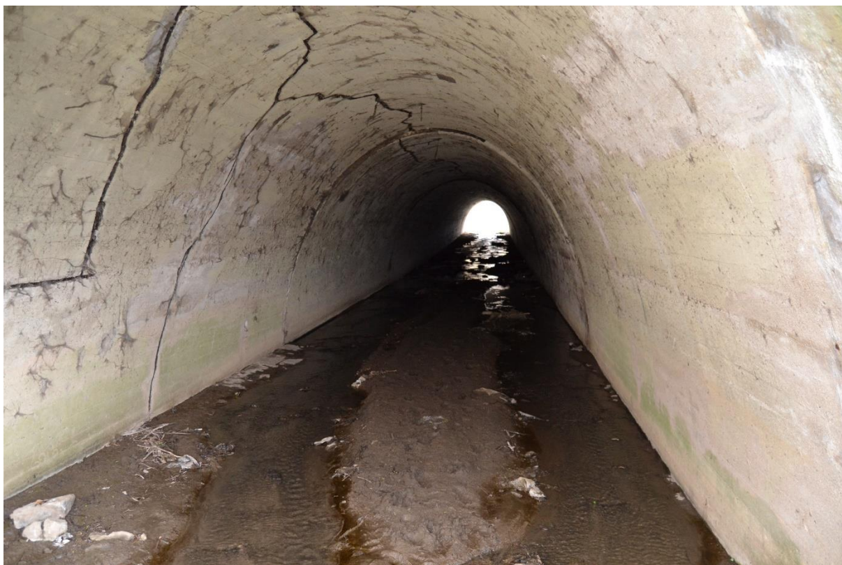
Obr. 115 Most (M. Sedlák, březen 2019)
