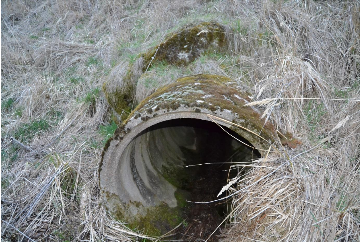
Obr. 3 Trubní propustek (M. Sedlák, březen 2019)
