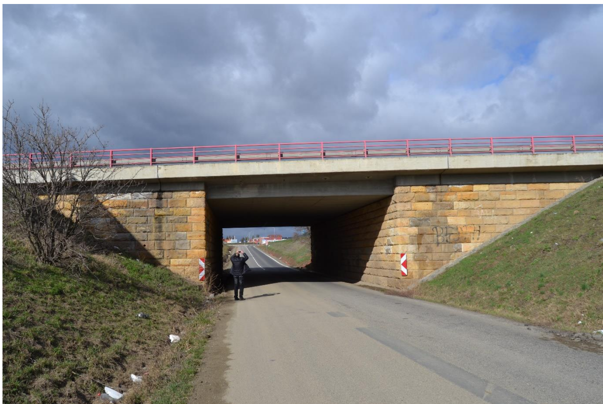
Obr. 112 Most (M. Sedlák, březen 2019)
