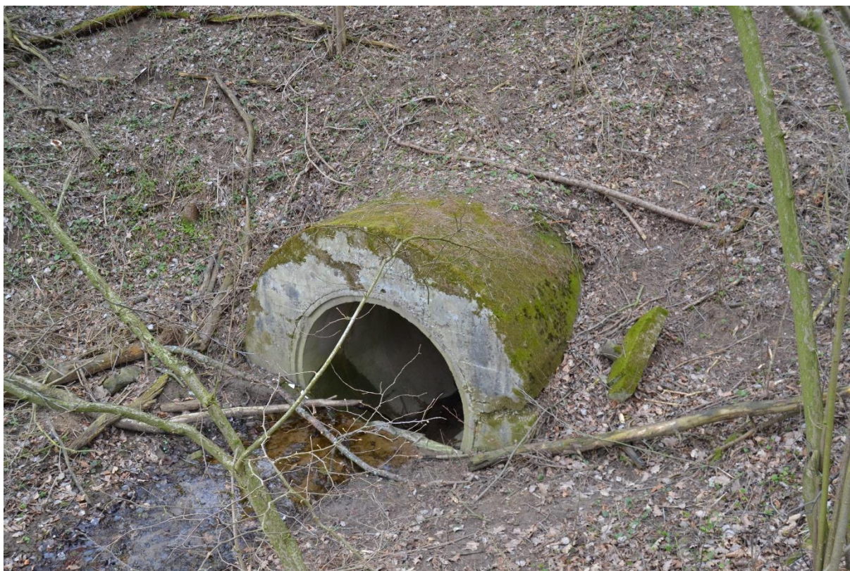
Obr. 60 Propustek (M. Sedlák, březen 2019)
