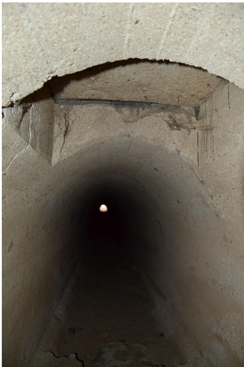
Obr. 96 Propustek (M. Sedlák, březen 2019)
