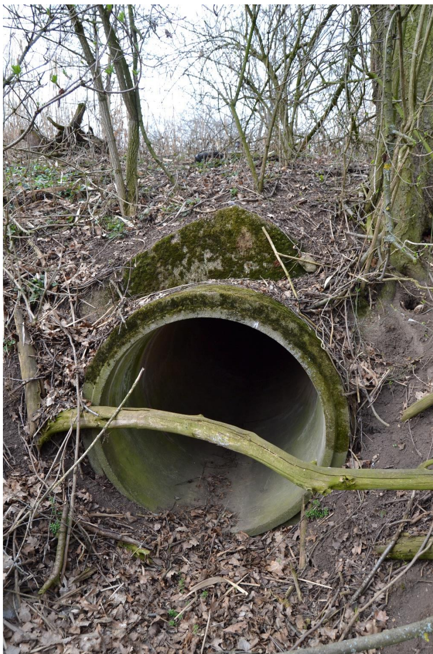
Obr. 24 Trubní propustek (M. Sedlák, březen 2019)
