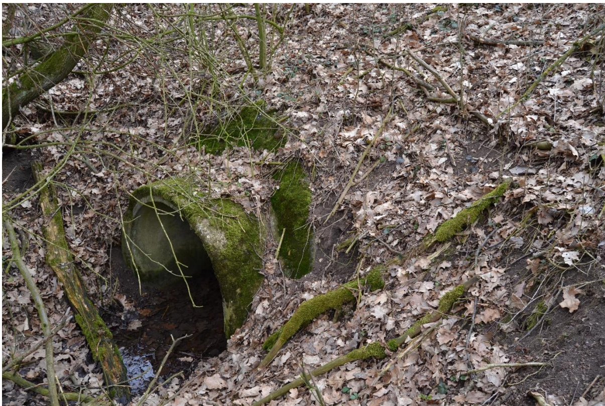
Obr. 32 Propustek (M. Sedlák, březen 2019)
