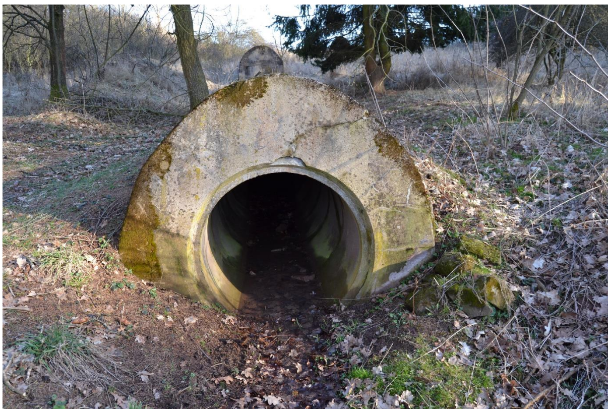
Obr. 68 2x lomený propustek (M. Sedlák, březen 2019)
