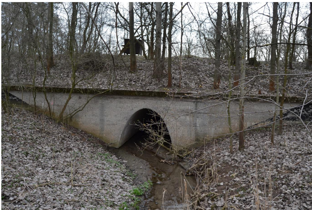
Obr. 35 Most (M. Sedlák, březen 2019)
