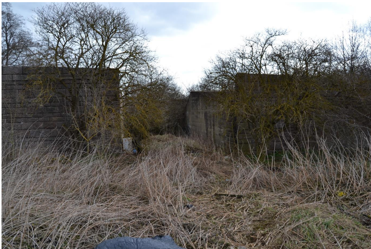
Obr. 103 Most (M. Sedlák, březen 2019)
