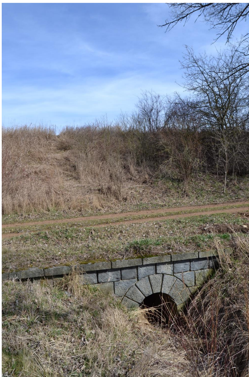
Obr. 76 Propustek (M. Sedlák, březen 2019)
