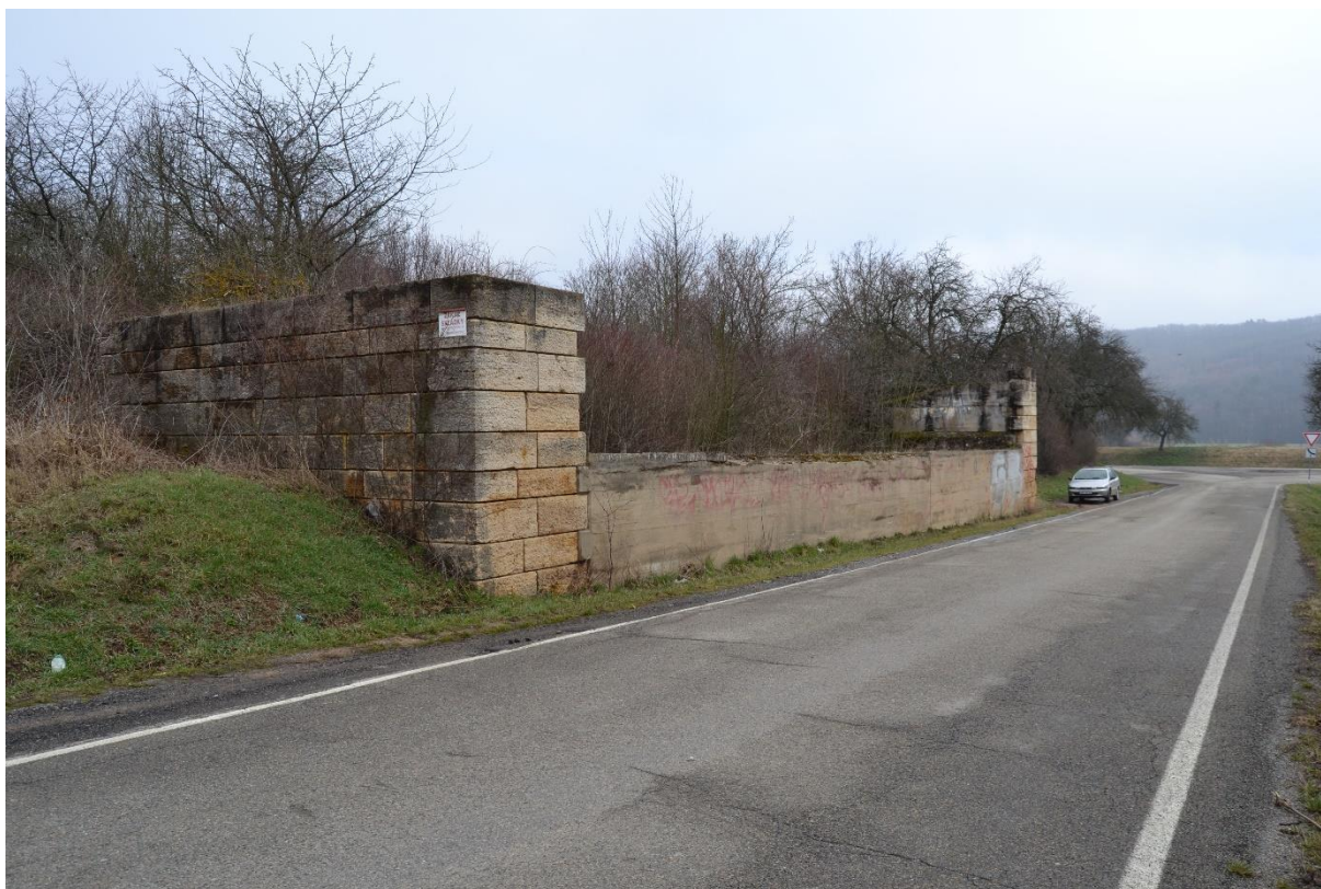
Obr. 85 Most (M. Sedlák, březen 2019)
