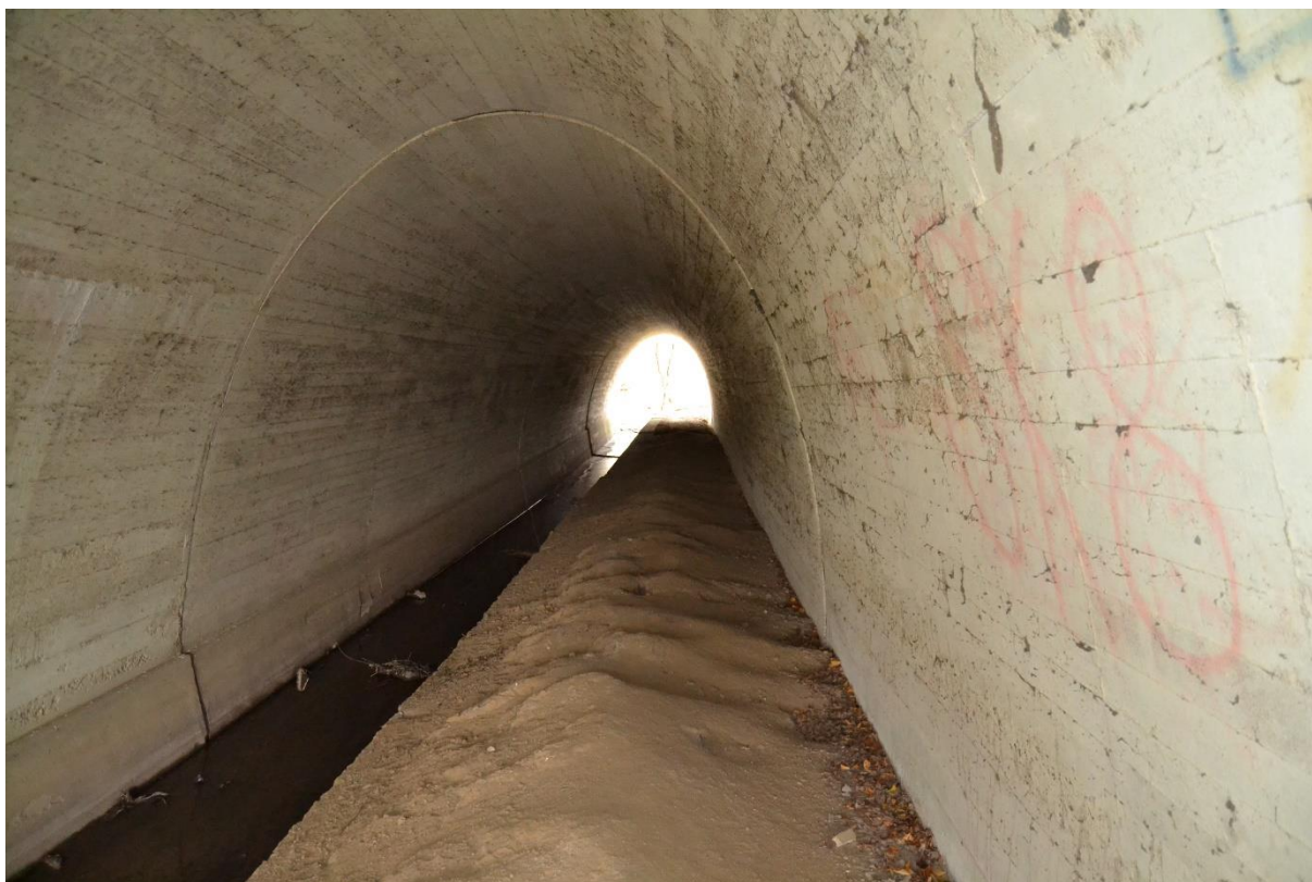
Obr. 50 Most (M. Sedlák, březen 2019)
