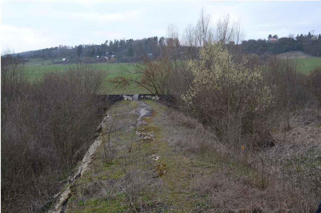
Obr. 11 Most (M. Sedlák, březen 2019)
