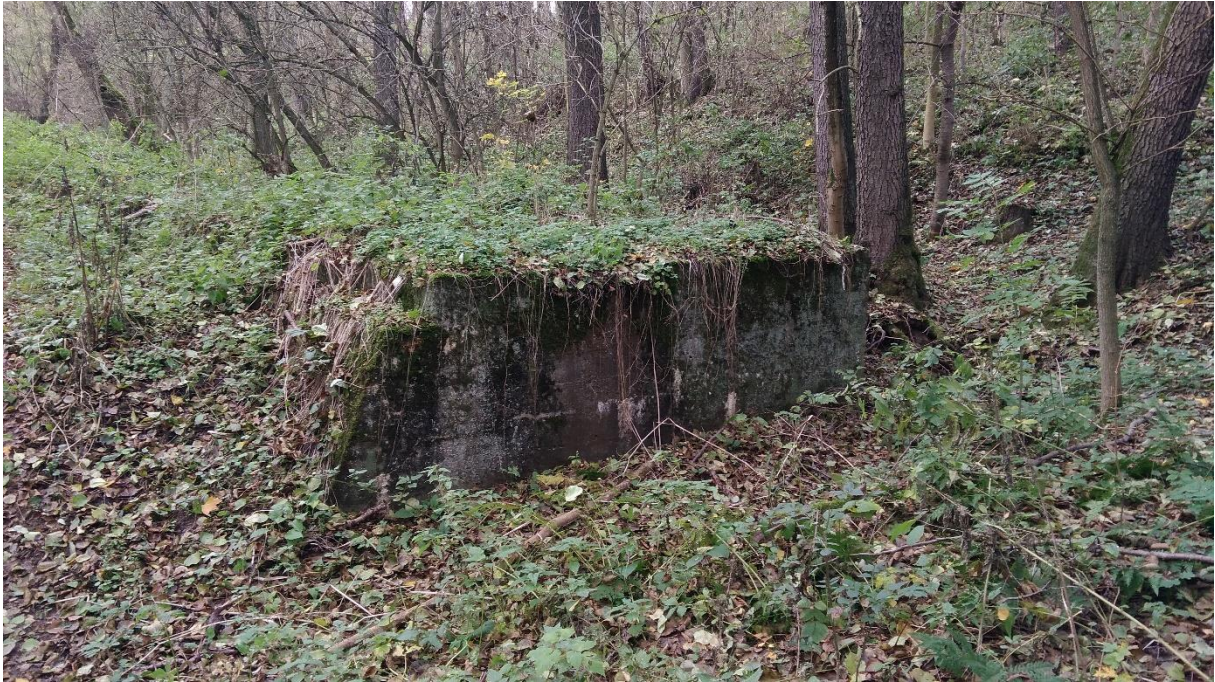
Obr. 4 Základy mostu (M. Sedlák, září 2019)
