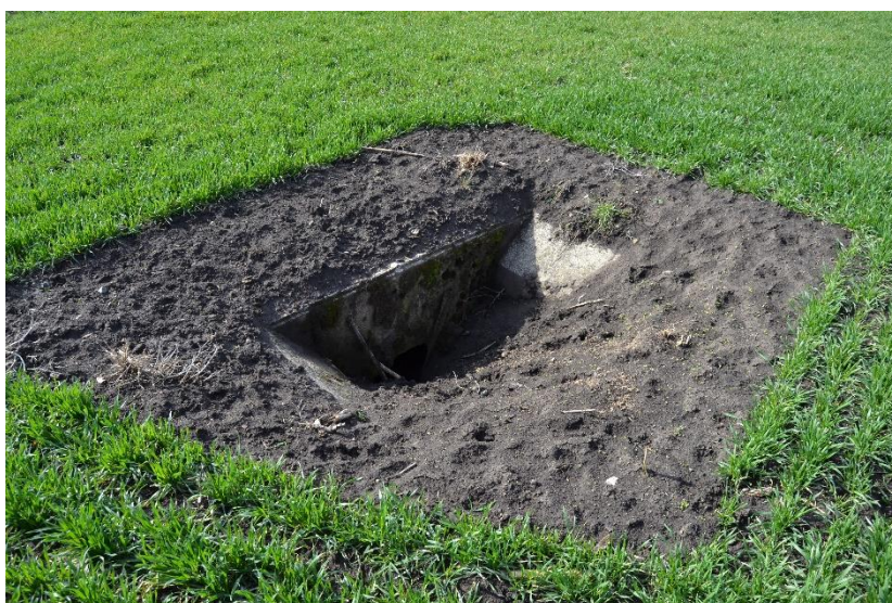
Obr. 72 Pohled na druhý konec propustku (M. Sedlák, březen 2019)
