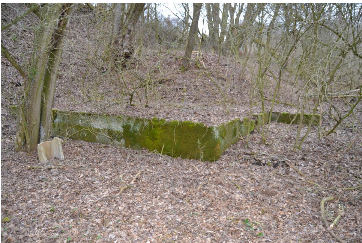
Obr. 6 Základy mostu (M. Sedlák, březen 2019)
