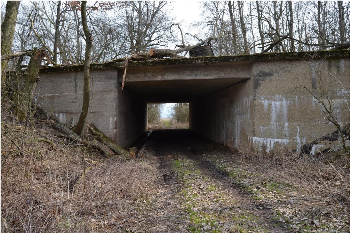
Obr. 30 Most (M. Sedlák, březen 2019)
