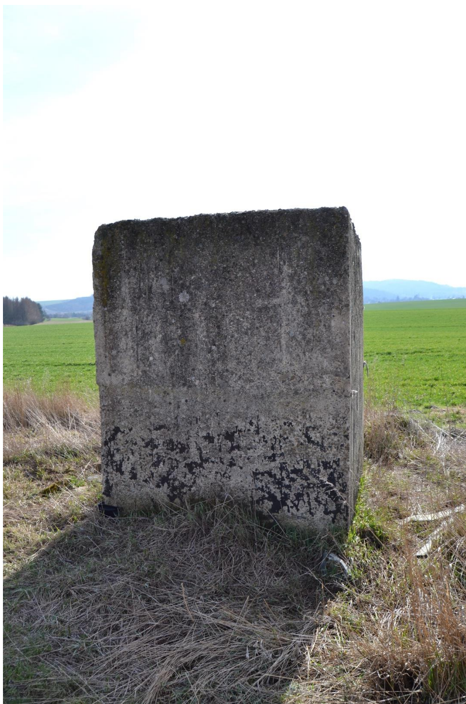
Obr. 73 Propustek (M. Sedlák, březen 2019)
