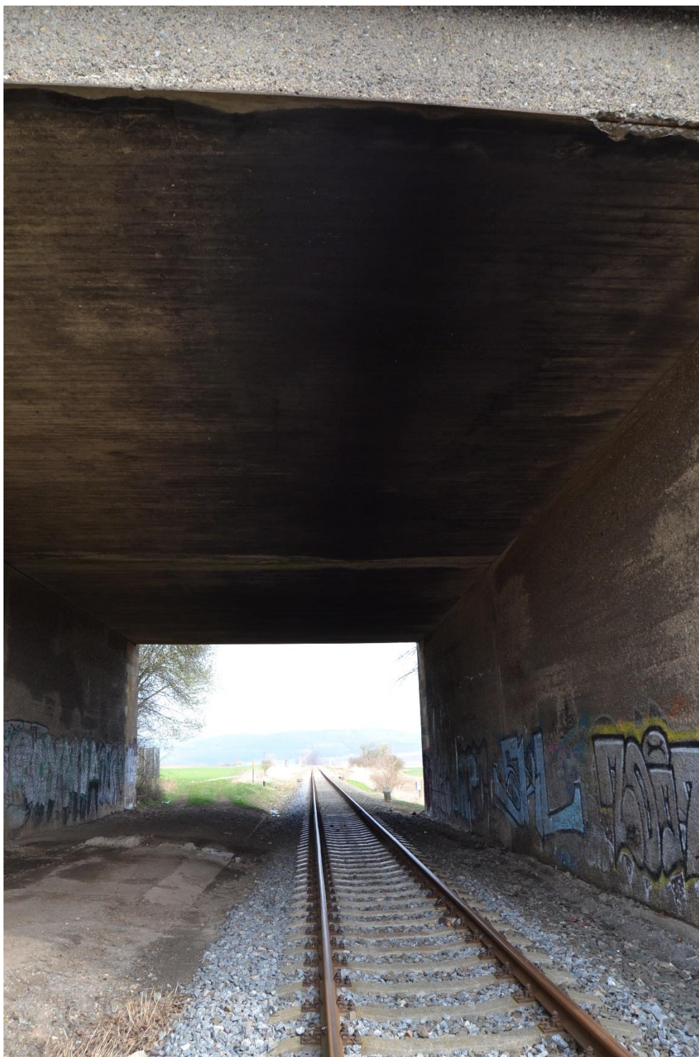
Obr. 18 Mostovka je zespodu stále ještě začerněna kouřem z parních lokomotiv (M. Sedlák, březen 2019)
