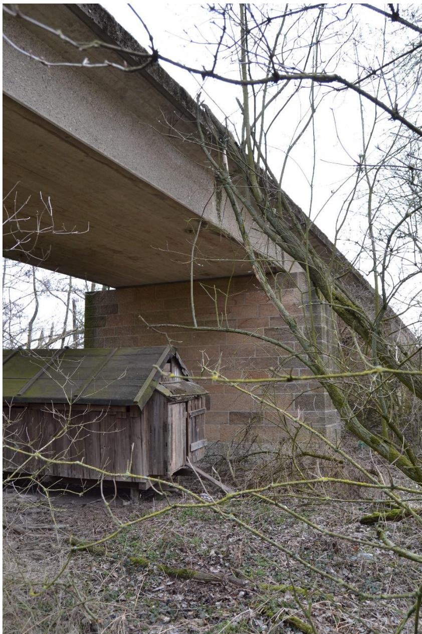
Obr. 33 Most (M. Sedlák, březen 2019)
