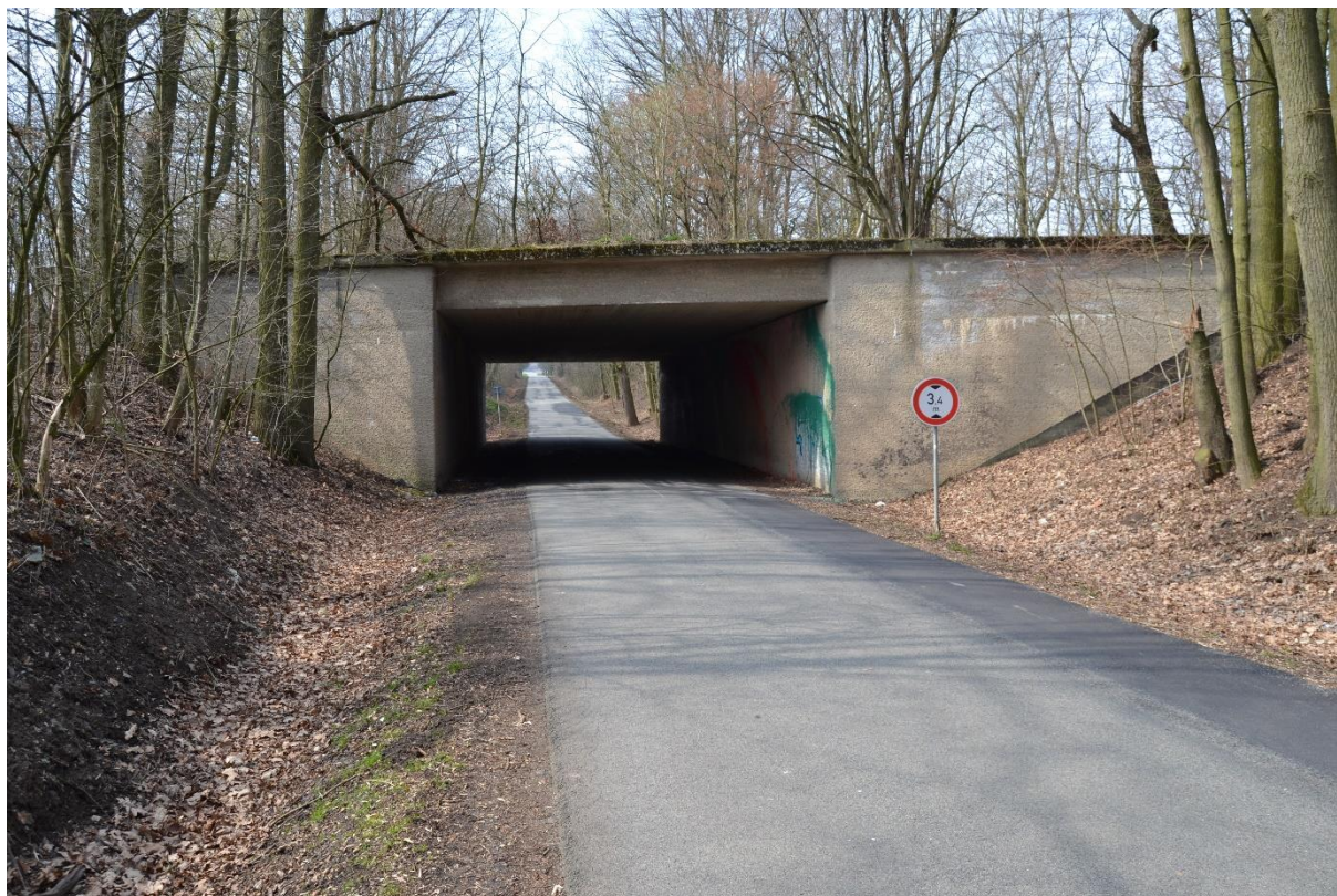
Obr. 25 Most (M. Sedlák, březen 2019)
