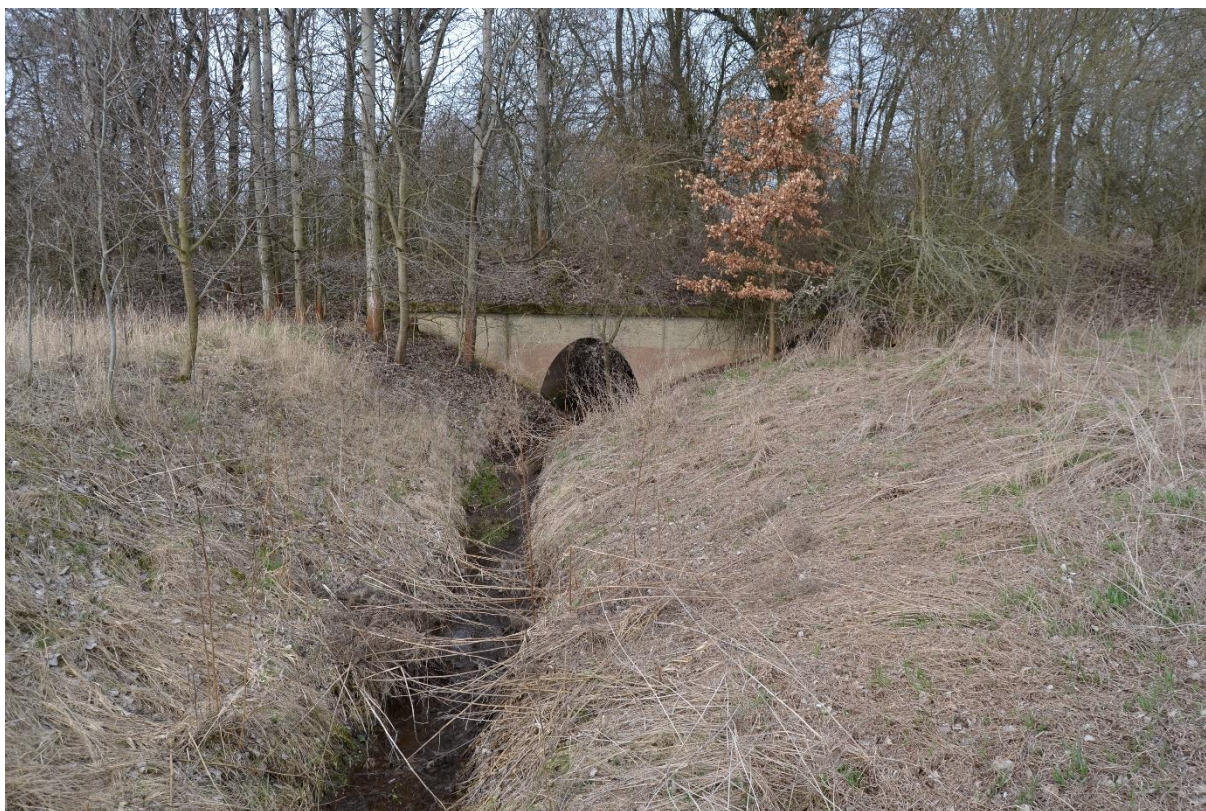
Obr. 36 Most (M. Sedlák, březen 2019)
