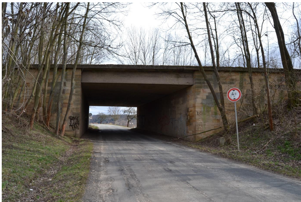
Obr. 51 Most (M. Sedlák, březen 2019)
