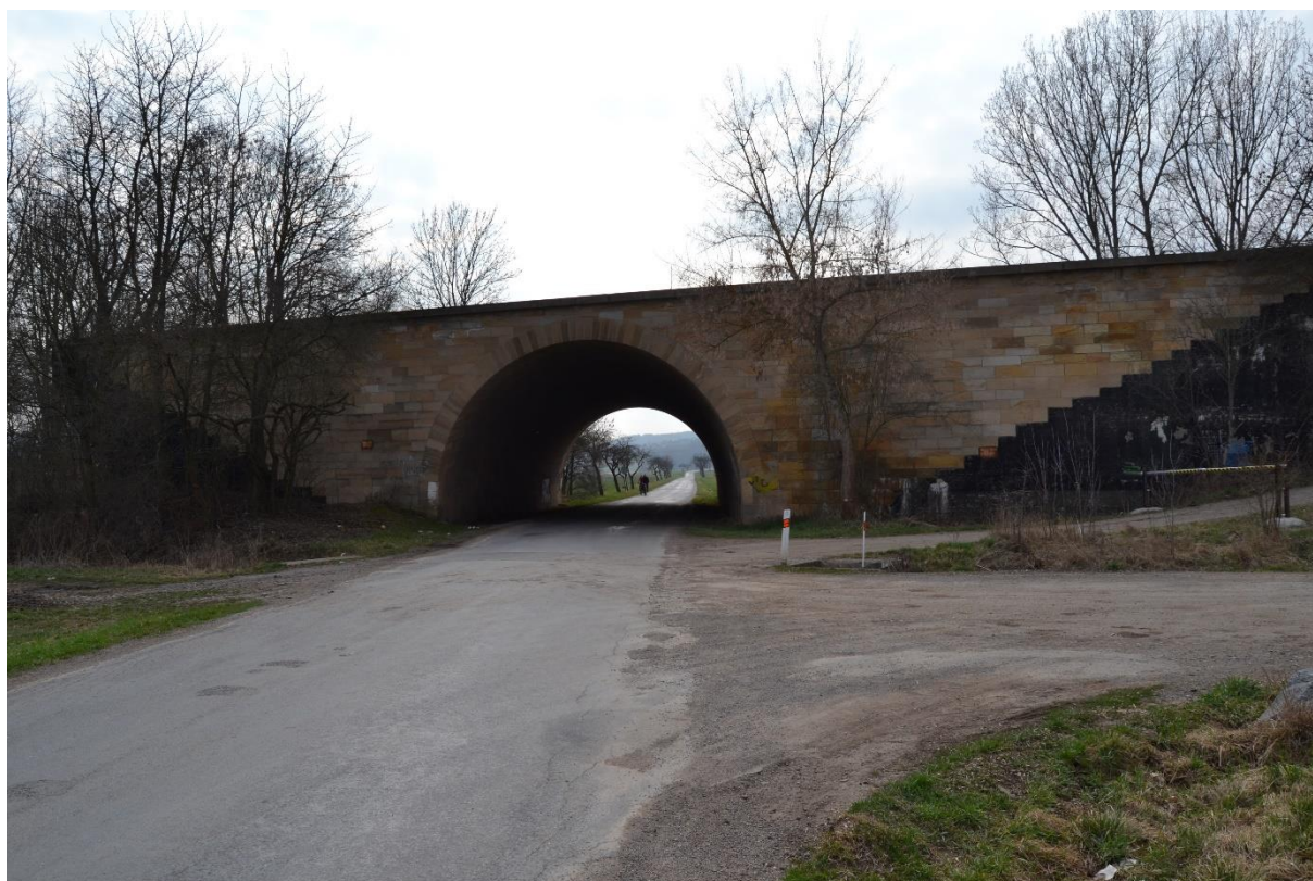
Obr. 12 Most (M. Sedlák, březen 2019)
