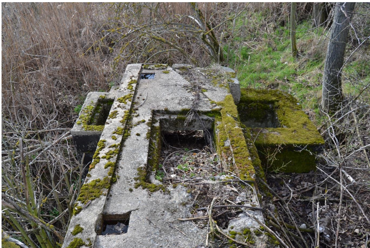
Obr. 111 Odvodňovací systém mostu (M. Sedlák, březen 2019)
