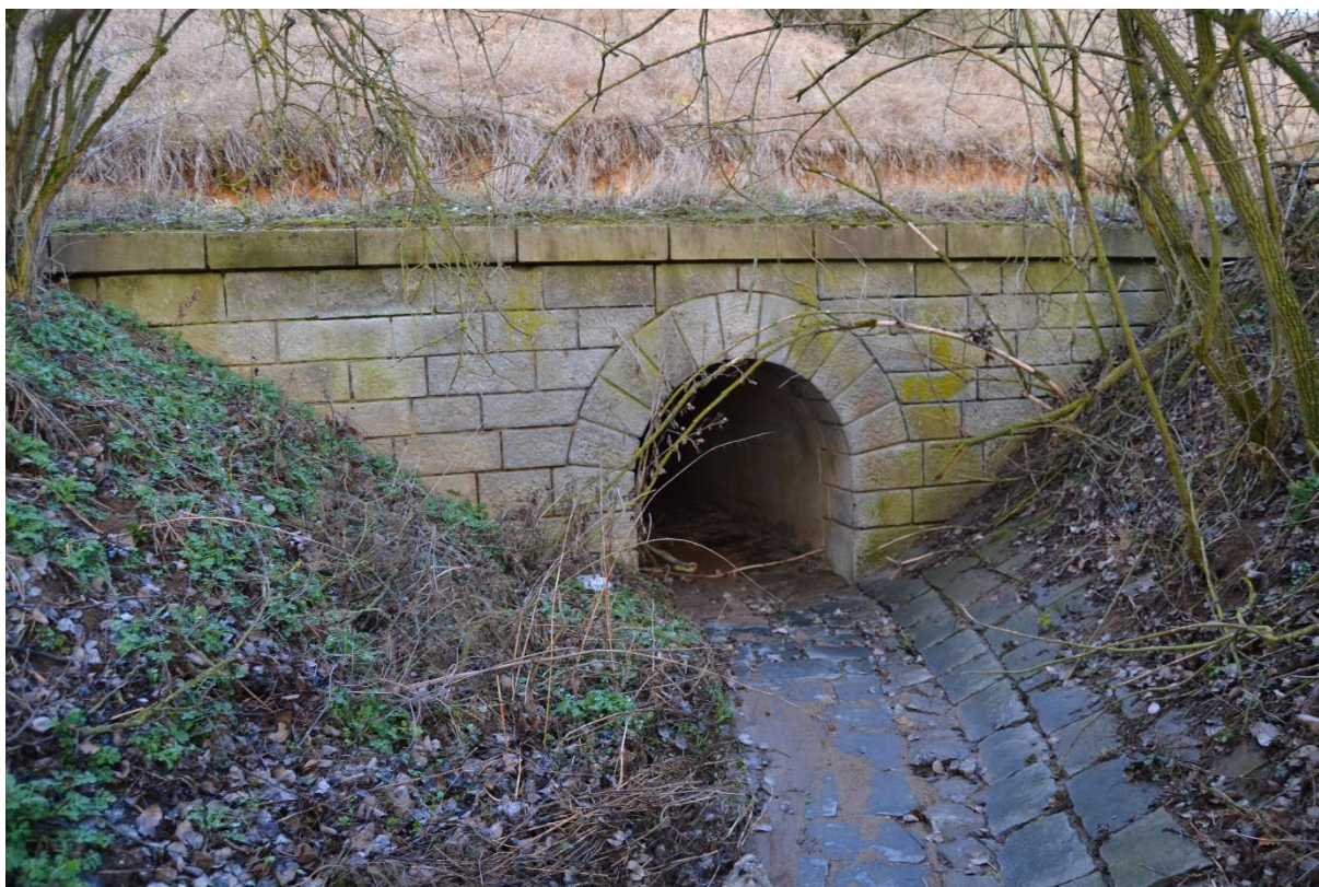
Obr. 87 Propustek (M. Sedlák, březen 2019)
