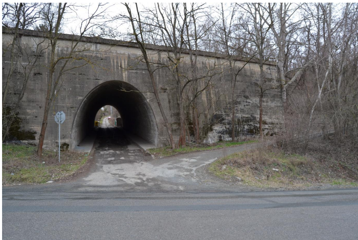
Obr. 104 Most (M. Sedlák, březen 2019)
