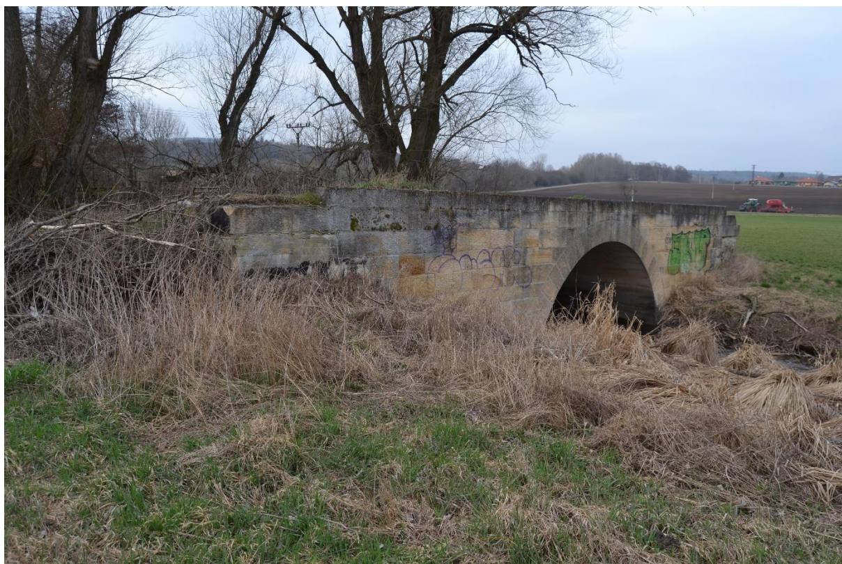
Obr. 14 Most (M. Sedlák, březen 2019)
