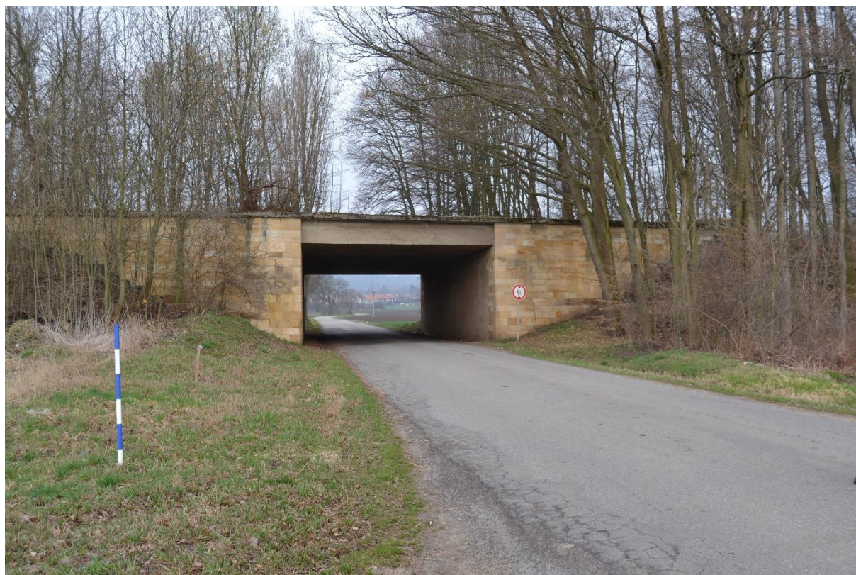
Obr. 34 Most (M. Sedlák, březen 2019)
