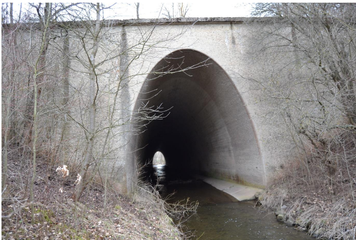
Obr. 45 Most (M. Sedlák, březen 2019)
