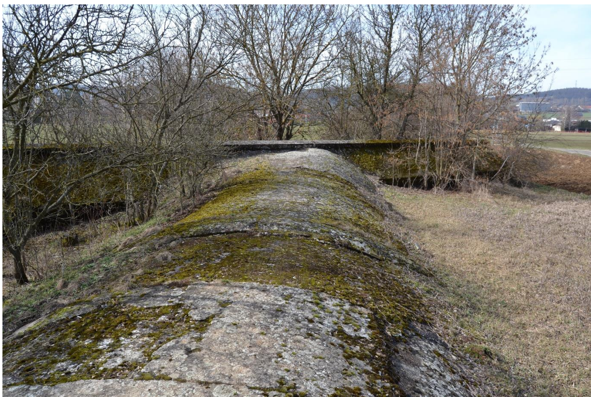
Obr. 75 Most (M. Sedlák, březen 2019)
