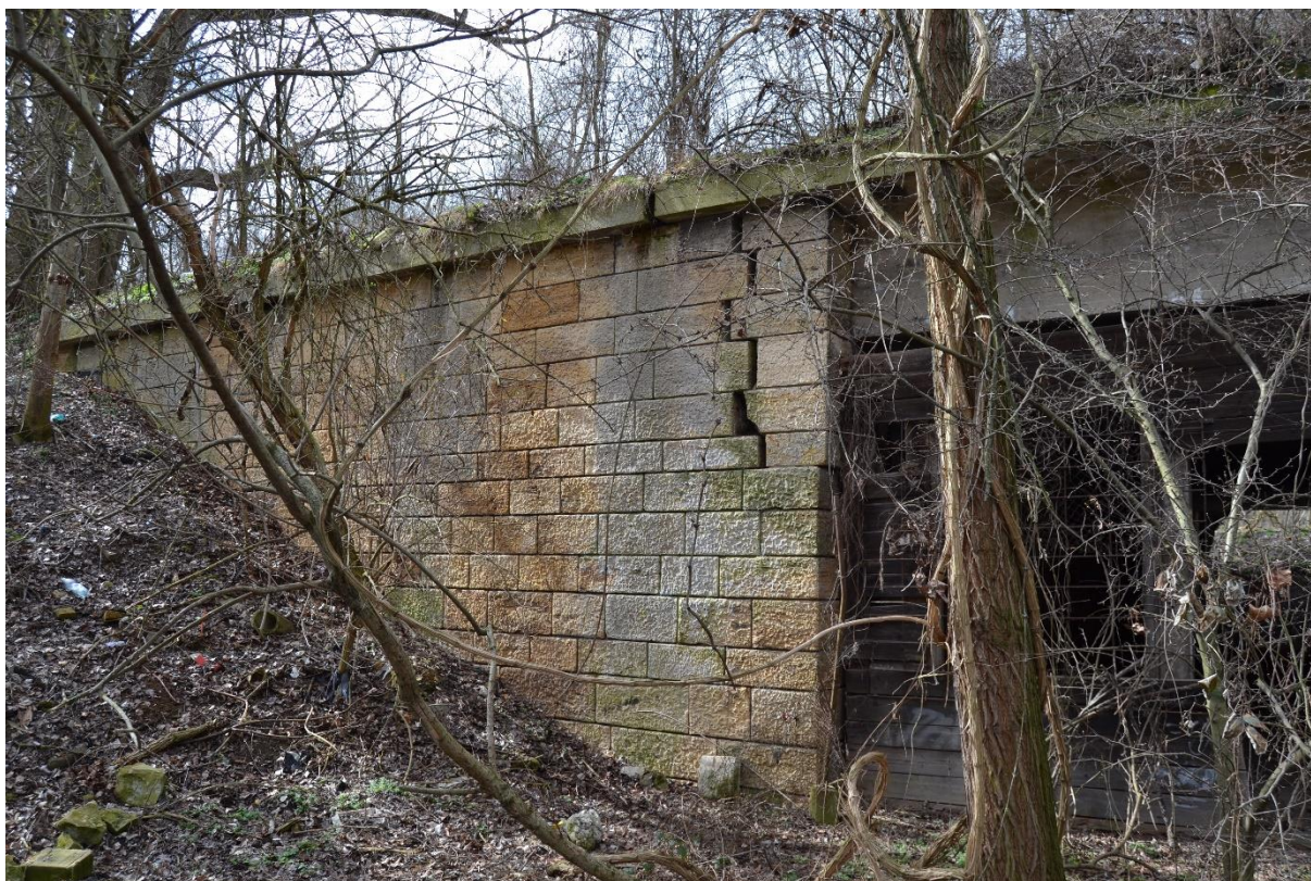
Obr. 105 Most (M. Sedlák, březen 2019)
