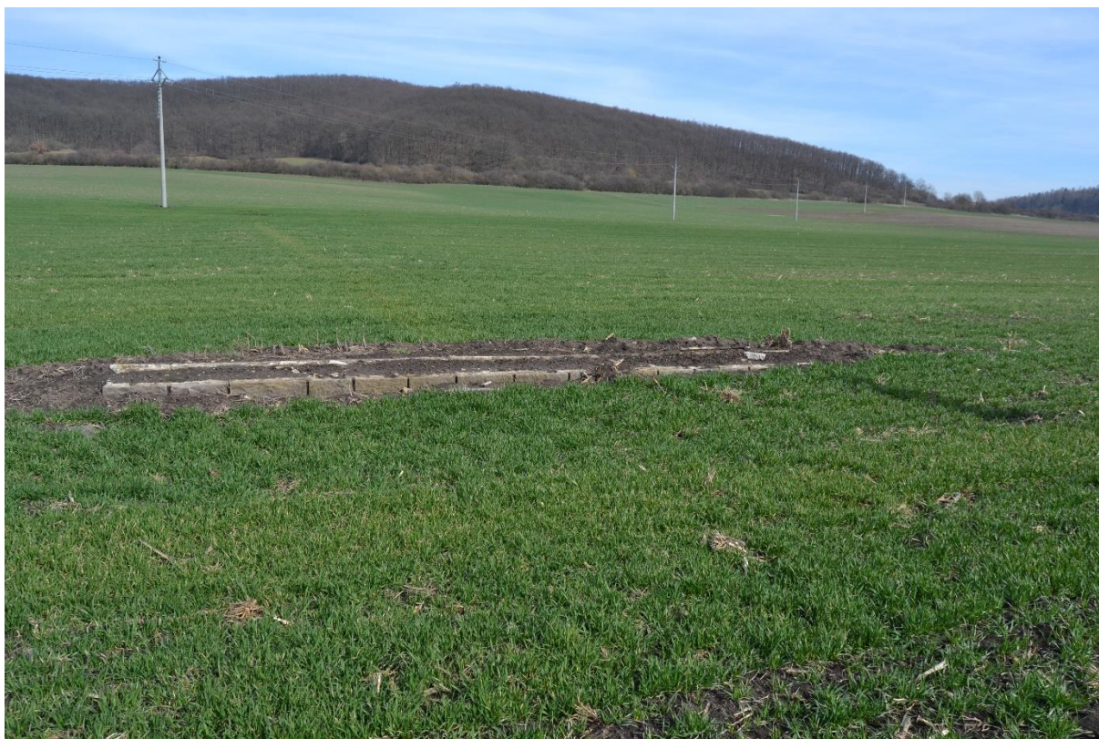
Obr. 71 Propustek (M. Sedlák, březen 2019)
