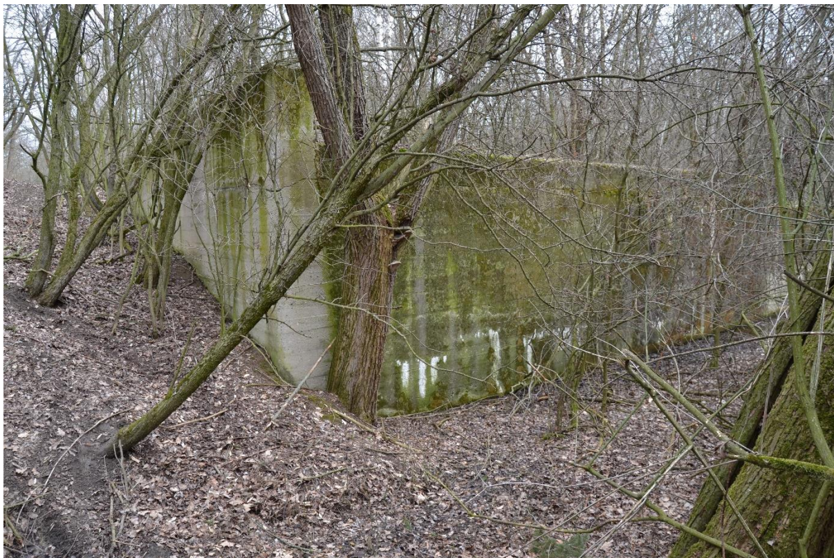
Obr. 31 Most (M. Sedlák, březen 2019)
