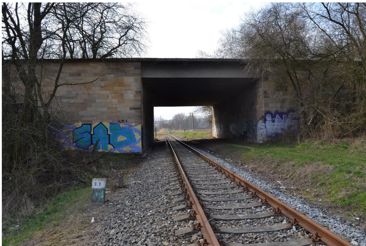
Obr. 17 Most (M. Sedlák, březen 2019)
