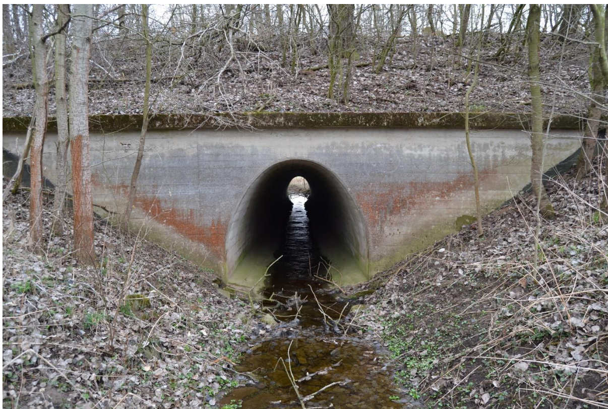
Obr. 37 Most (M. Sedlák, březen 2019)
