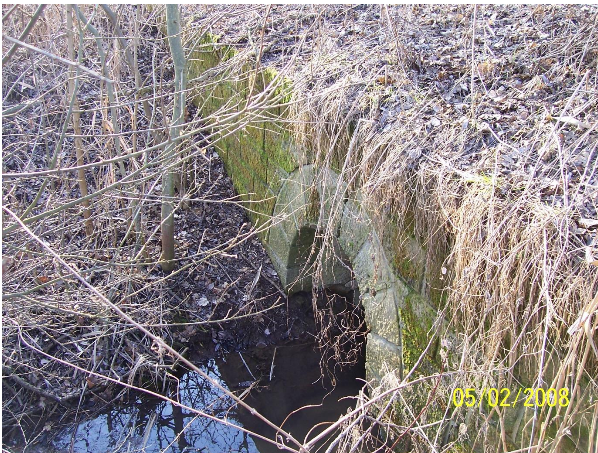
Obr. 41 Propustek v roce 2008 (R. Sural, únor 2008)
