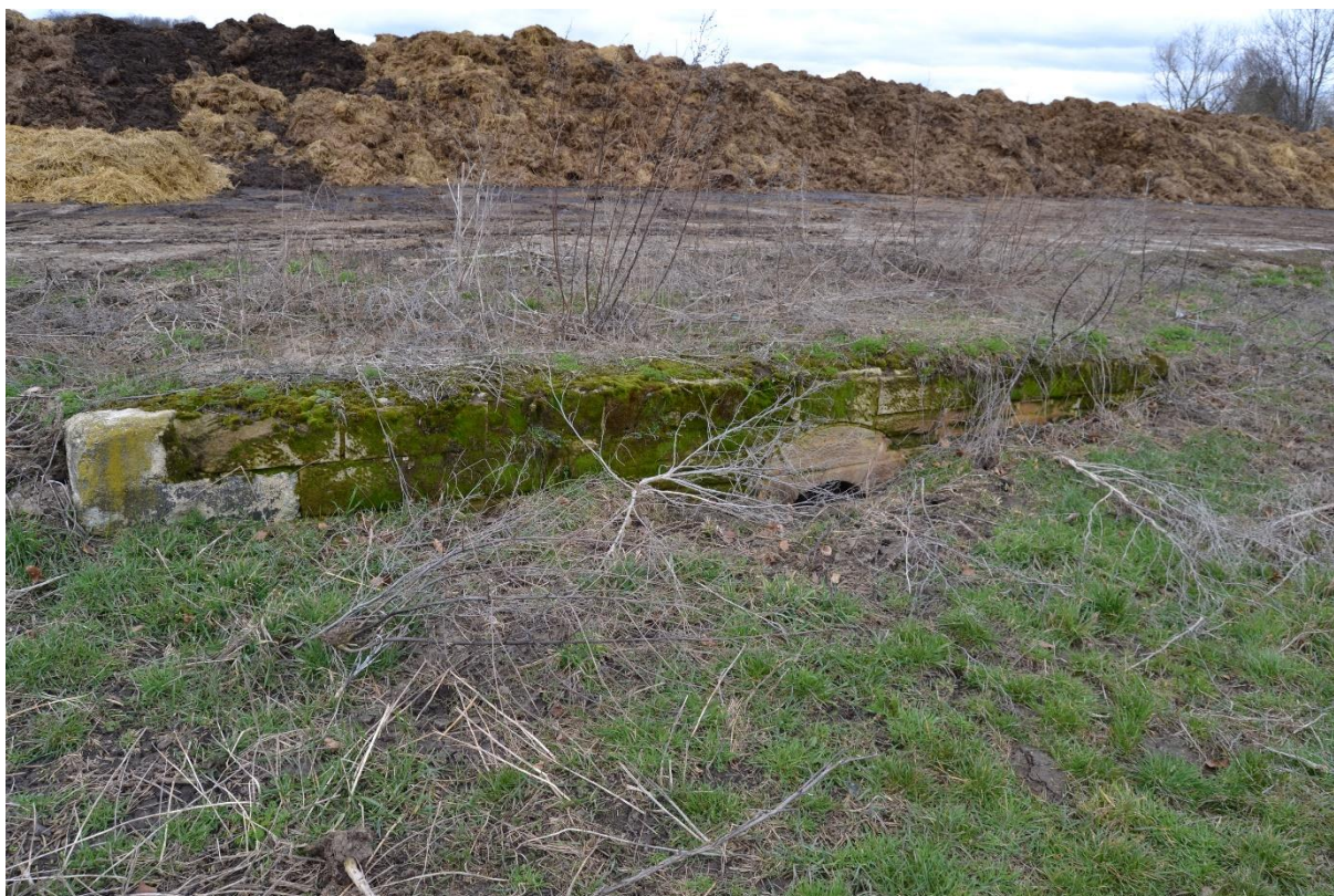
Obr. 54 Propustek (M. Sedlák, březen 2019)
