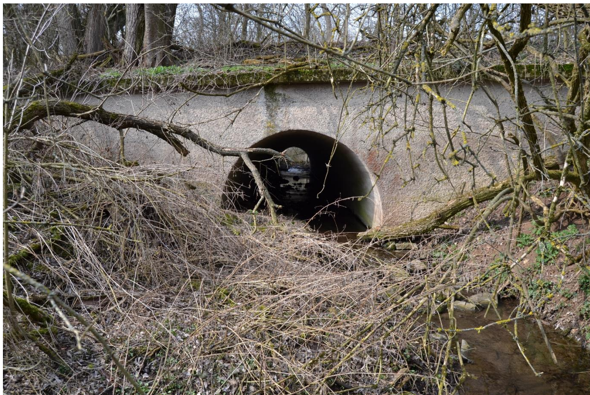
Obr. 29 Most (M. Sedlák, březen 2019)
