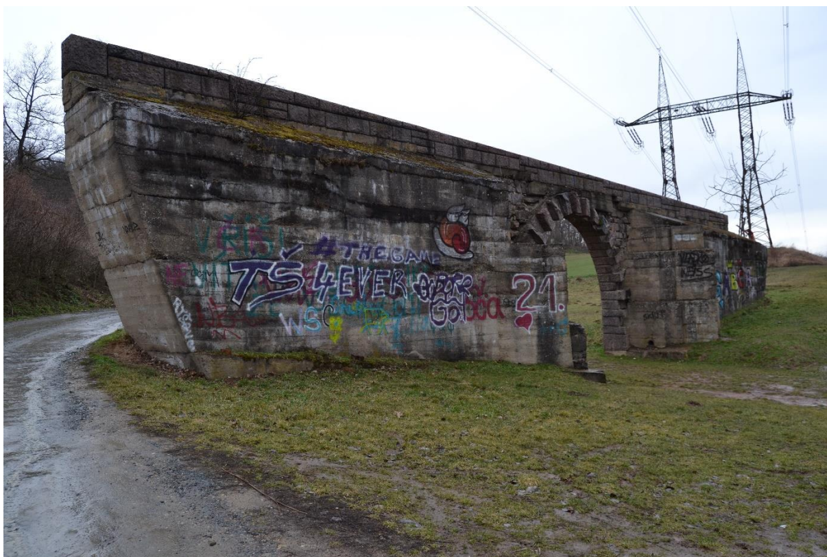
Obr. 100 Most (M. Sedlák, březen 2019)
