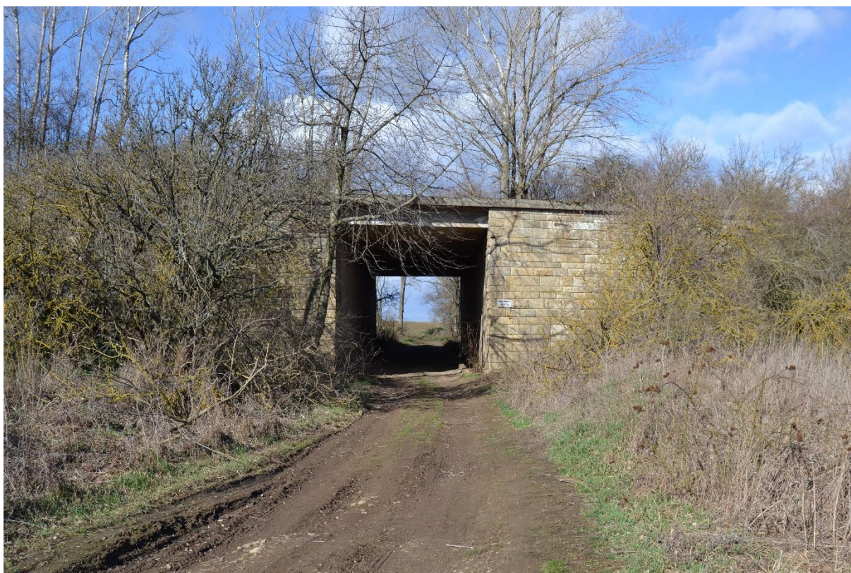
Obr. 110 Most (M. Sedlák, březen 2019)
