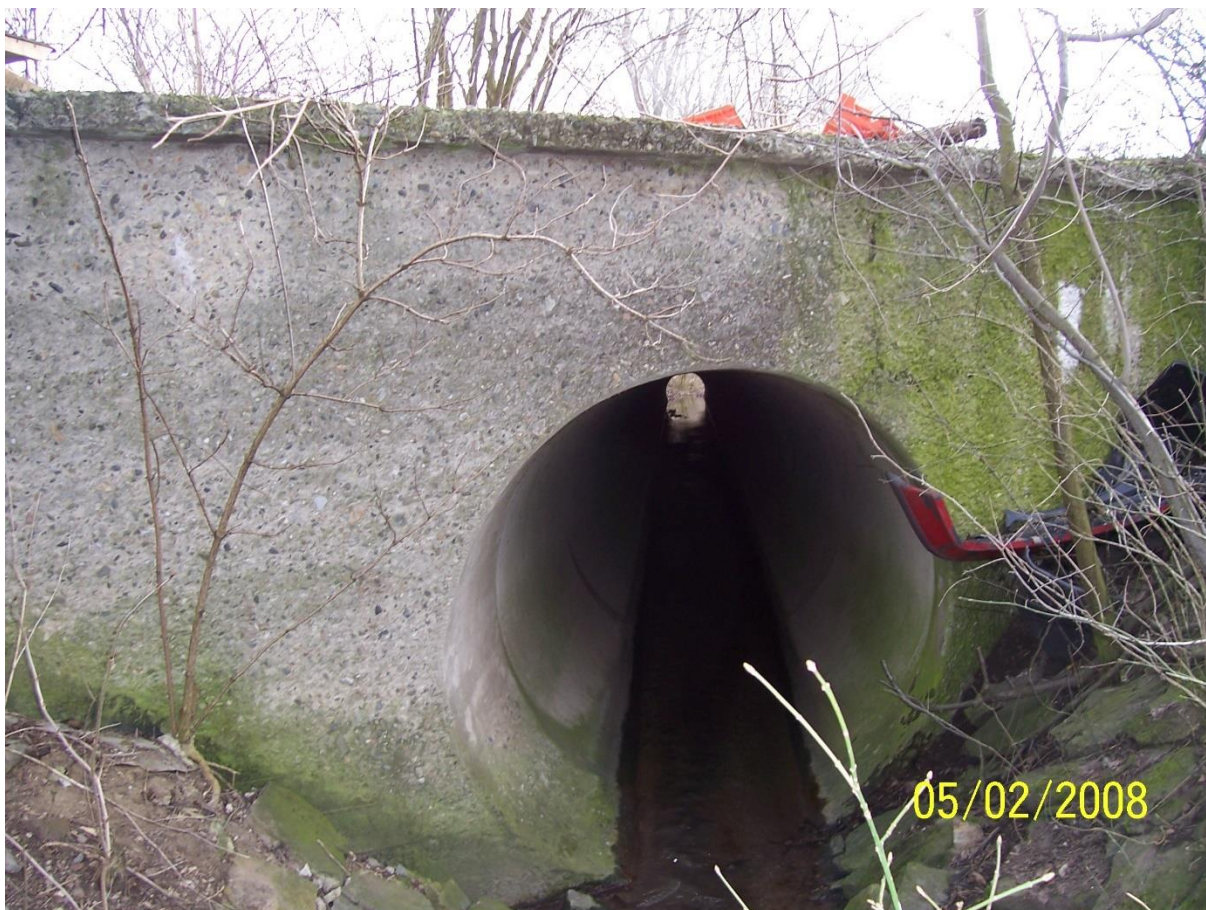
Obr. 58 Propustek v roce 2008 (R. Sural, únor 2008)
