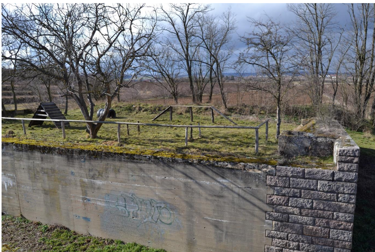
Obr. 99 Most (M. Sedlák, březen 2019)
