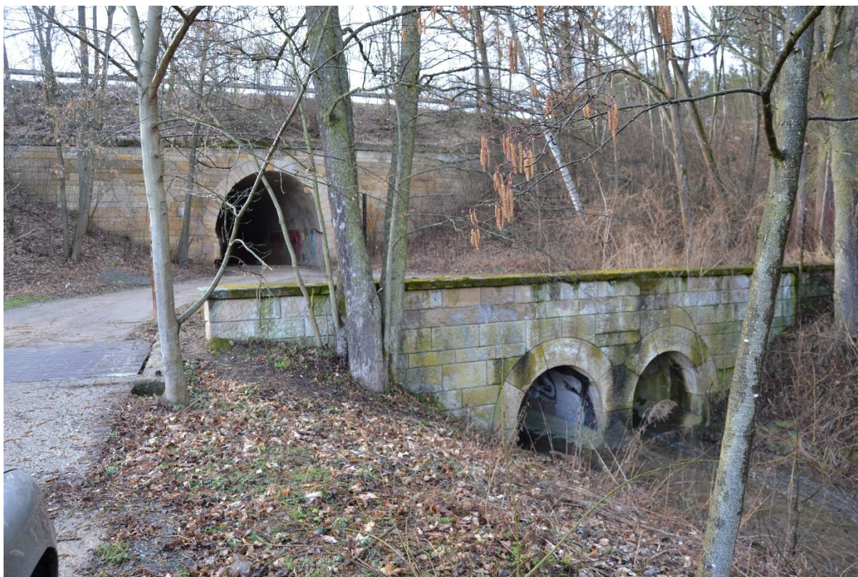
Obr. 93 Most i propustek (M. Sedlák, březen 2019)
