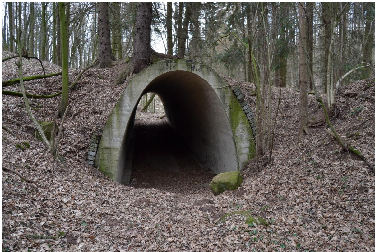
Obr. 64 Most (M. Sedlák, březen 2019)
