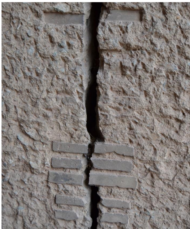
Obr. 44 Testy prováděné na mostě, jak most „pracuje“ (M. Sedlák, březen 2019)
