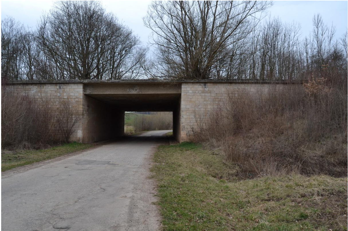
Obr. 39 Most (M. Sedlák, březen 2019)
