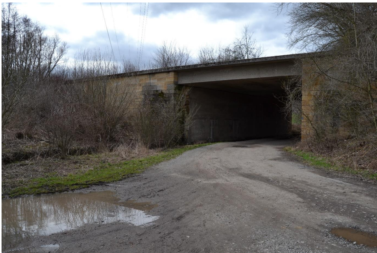
Obr. 55 Most (M. Sedlák, březen 2019)
