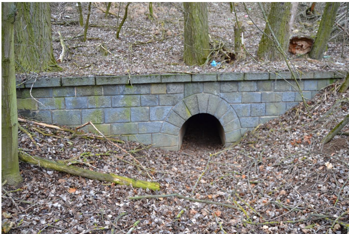
Obr. 95 Propustek (M. Sedlák, březen 2019)
