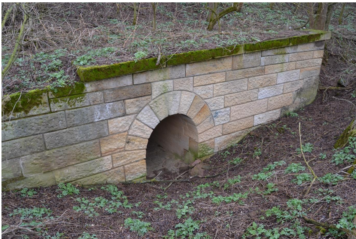
Obr. 108 Propustek (M. Sedlák, březen 2019)
