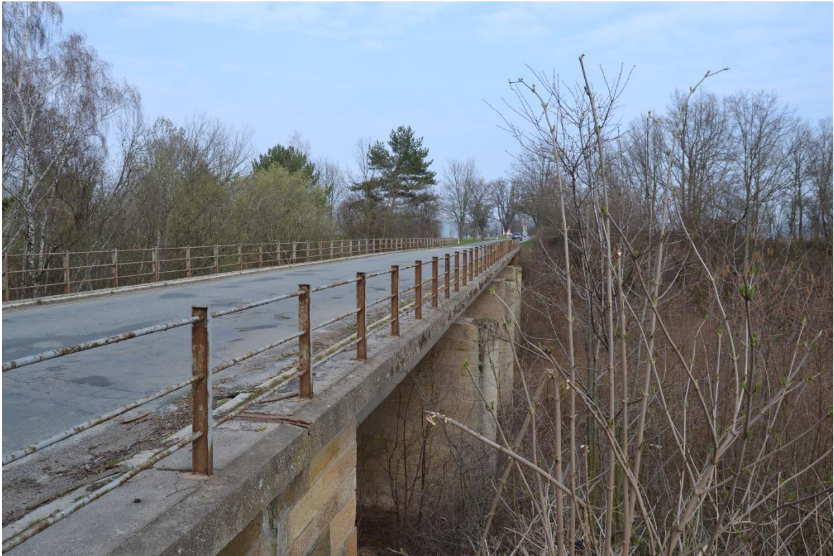
Obr. 16 Most (M. Sedlák, březen 2019)
