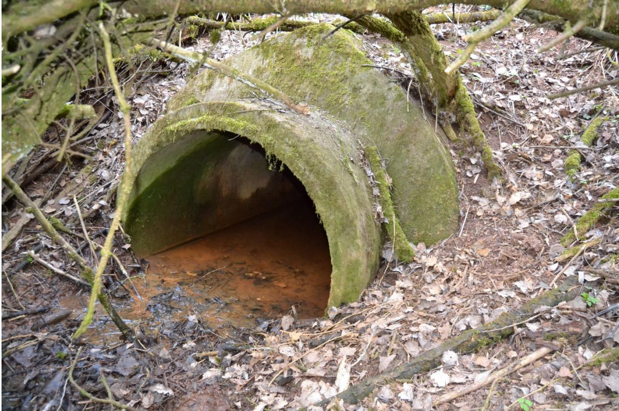
Obr. 5 Trubní propustek (M. Sedlák, březen 2019)
