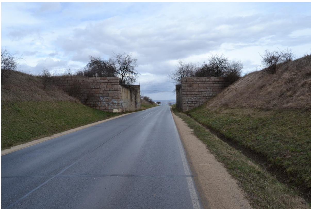
Obr. 102 Most (M. Sedlák, březen 2019)
