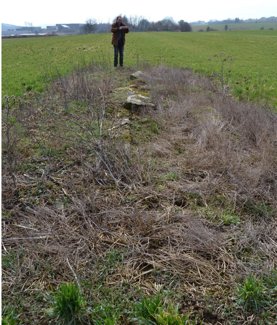
Obr. 81 Propustek (M. Sedlák, březen 2019)
