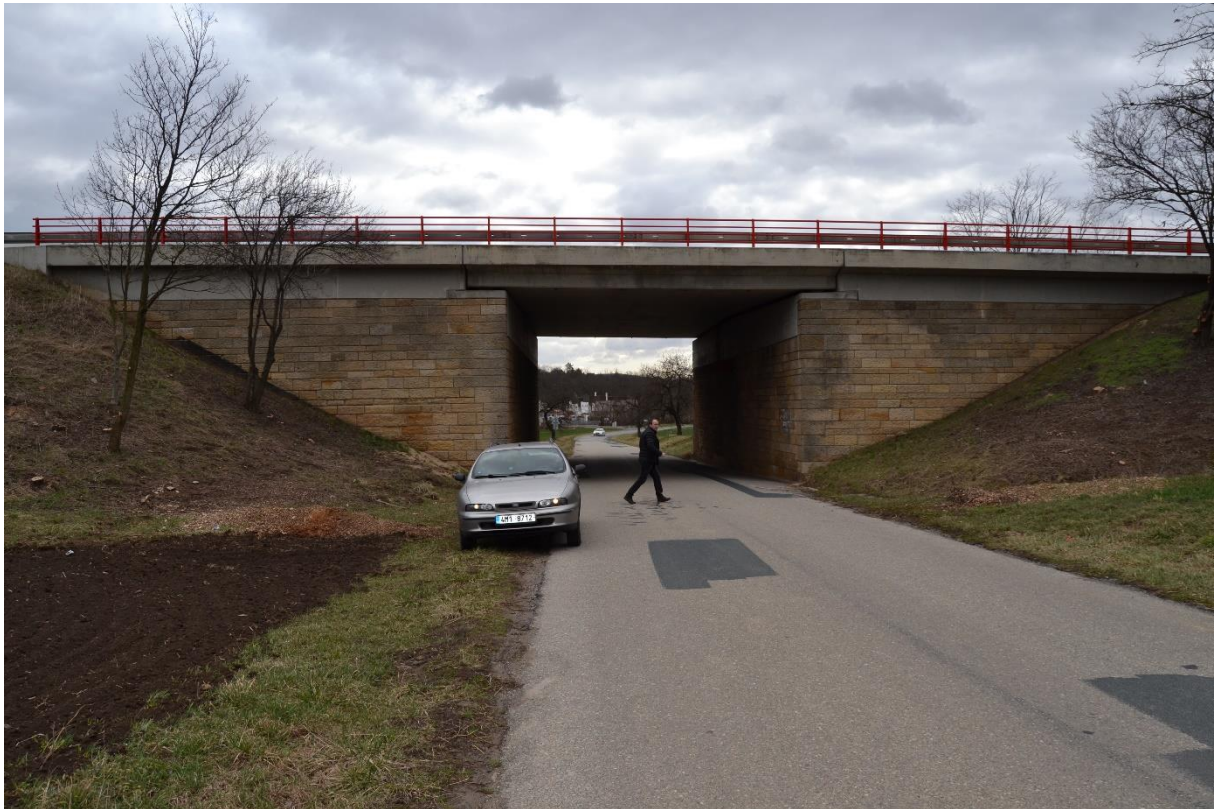
Obr. 116 Most (M. Sedlák, březen 2019)
