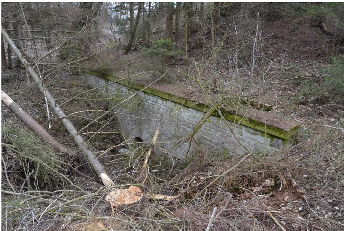
Obr. 63 Propustek (M. Sedlák, březen 2019)
