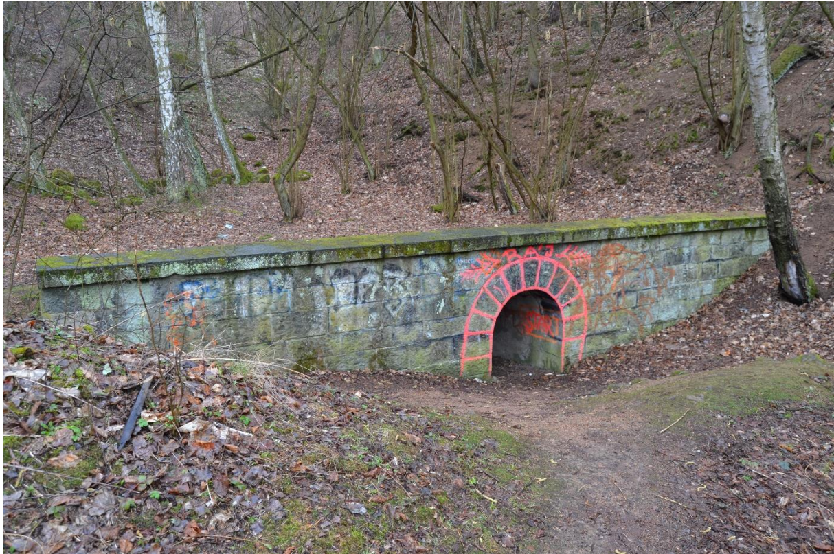
Obr. 101 Propustek (M. Sedlák, březen 2019)
