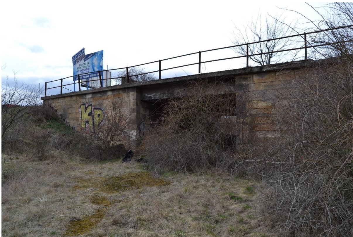
Obr. 48 Most (M. Sedlák, březen 2019)
