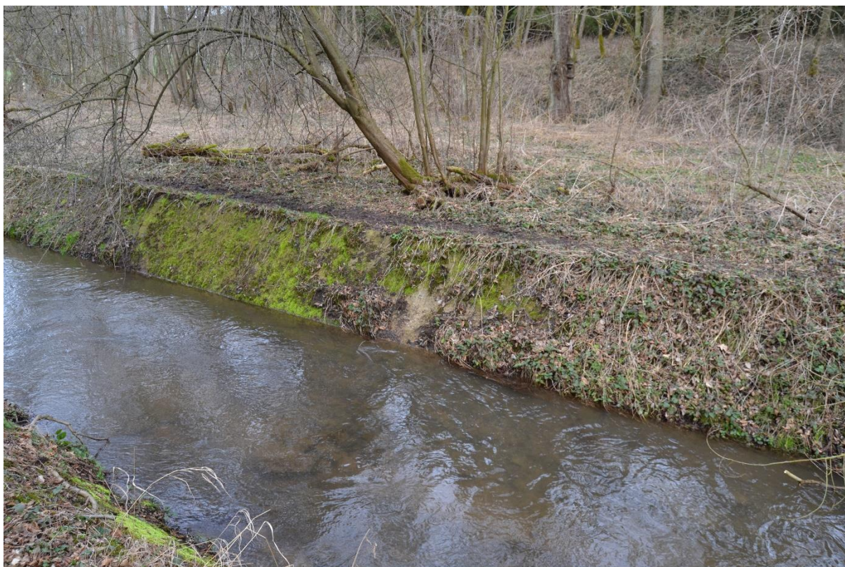
Obr. 62 Základy mostu (M. Sedlák, březen 2019)
