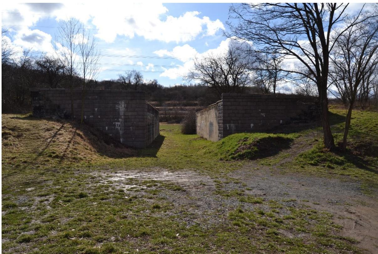
Obr. 98 Most (M. Sedlák, březen 2019)
