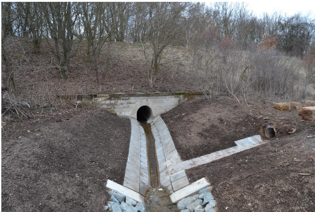
Obr. 40 Propustek (M. Sedlák, březen 2019)
