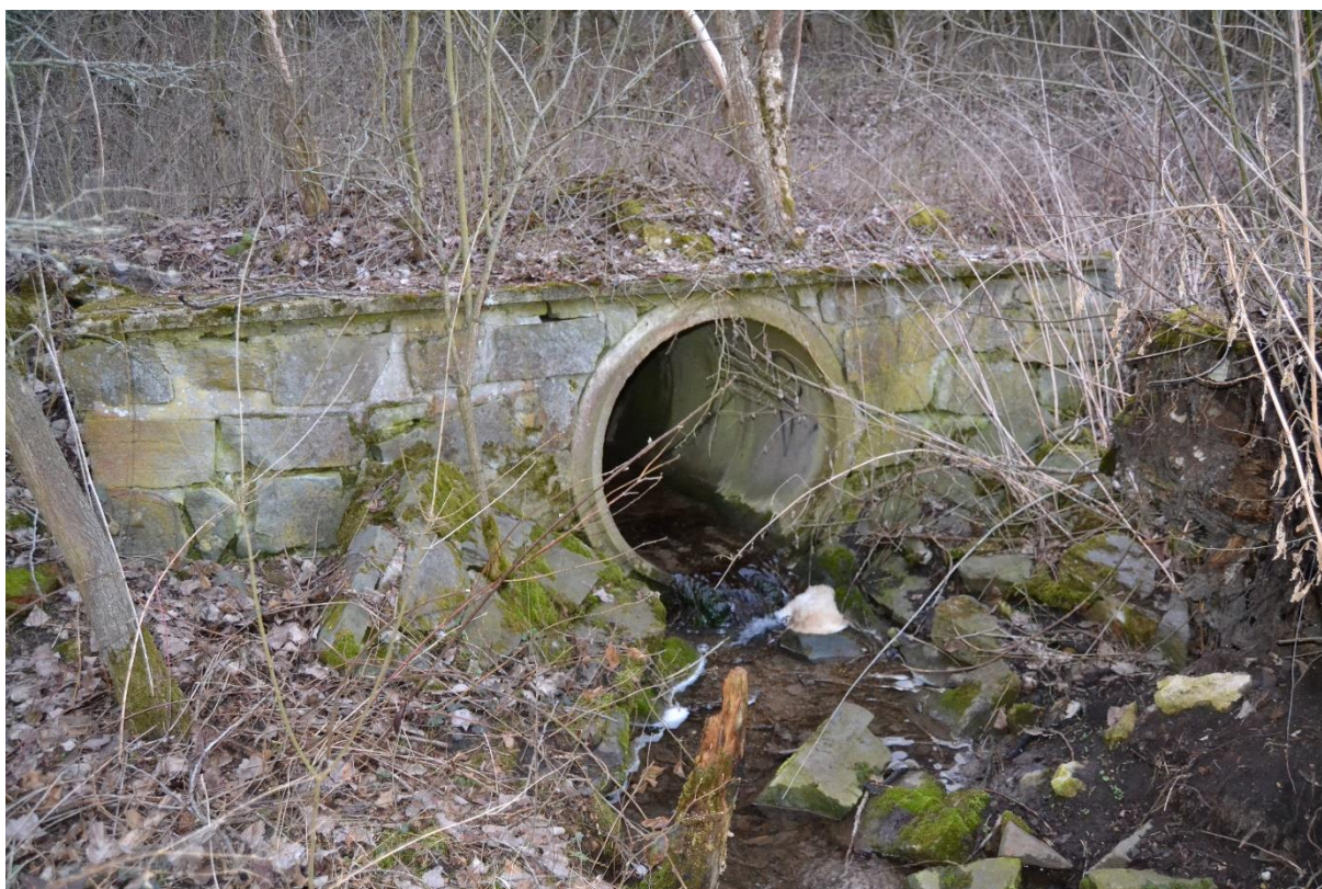
Obr. 38 Propustek (M. Sedlák, březen 2019)
