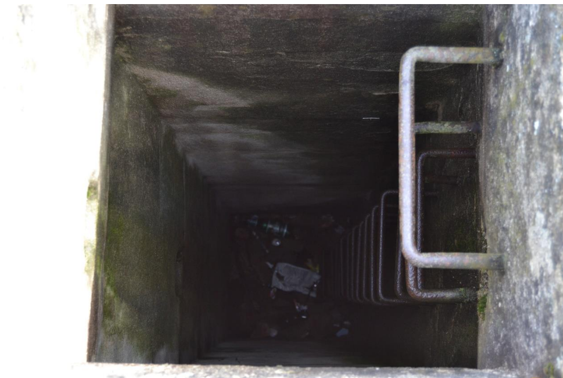
Obr. 80 Jímka pro odvodnění mostu (M. Sedlák, březen 2019)
