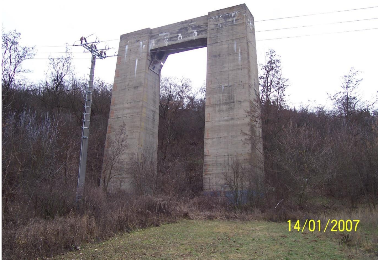
Obr. 91 Mostní pilíř v roce 2007 (R. Sural, leden 2007)
