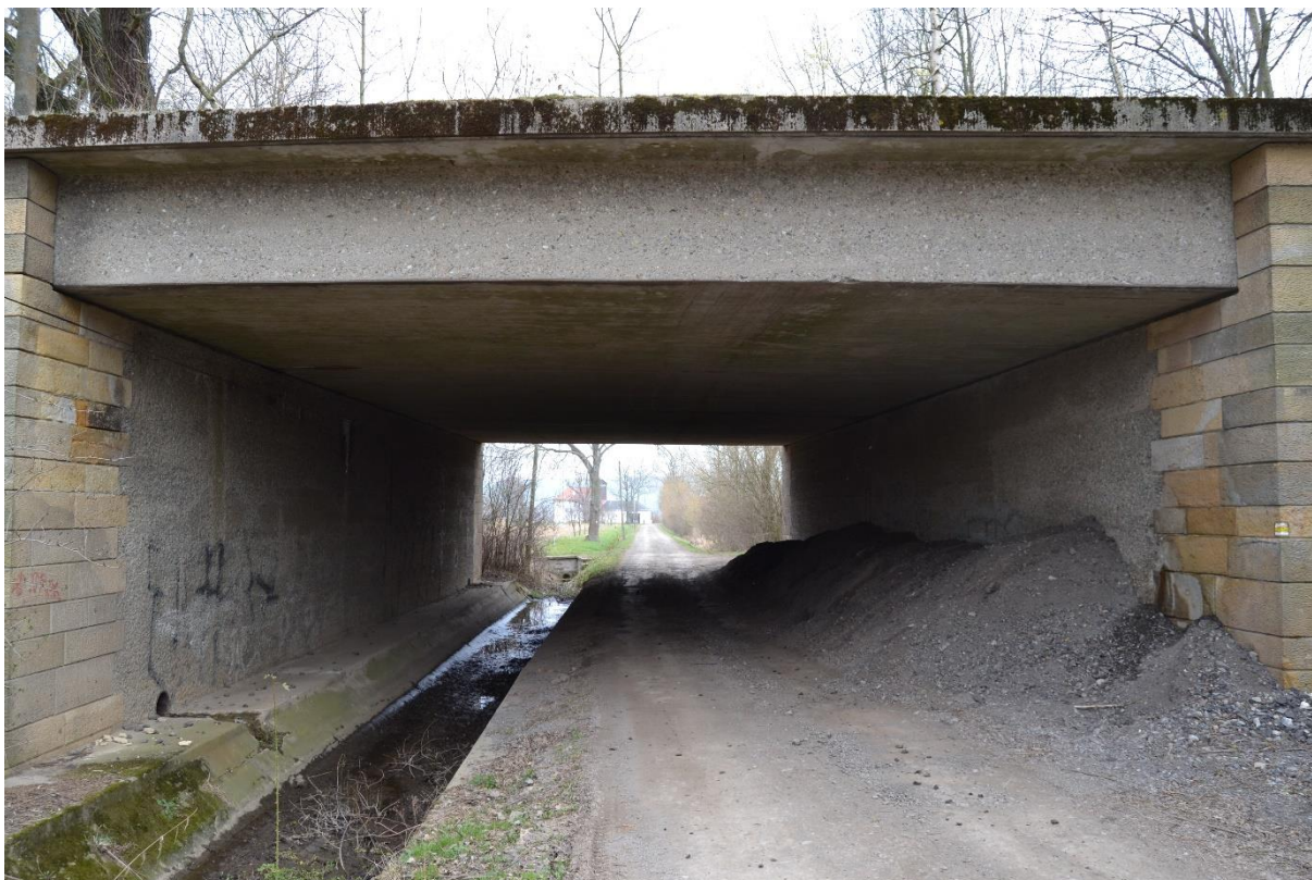
Obr. 20 Most (M. Sedlák, březen 2019)
