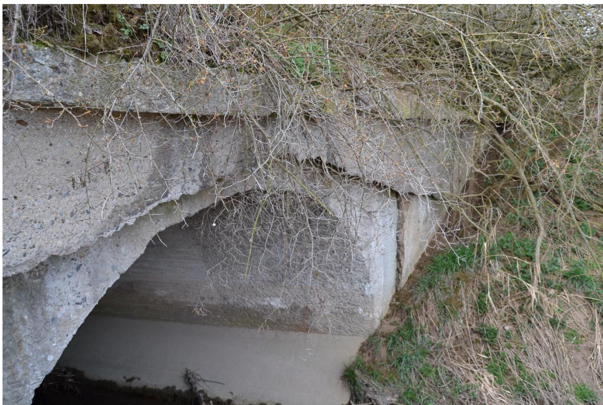
Obr. 19 Most (M. Sedlák, březen 2019)
