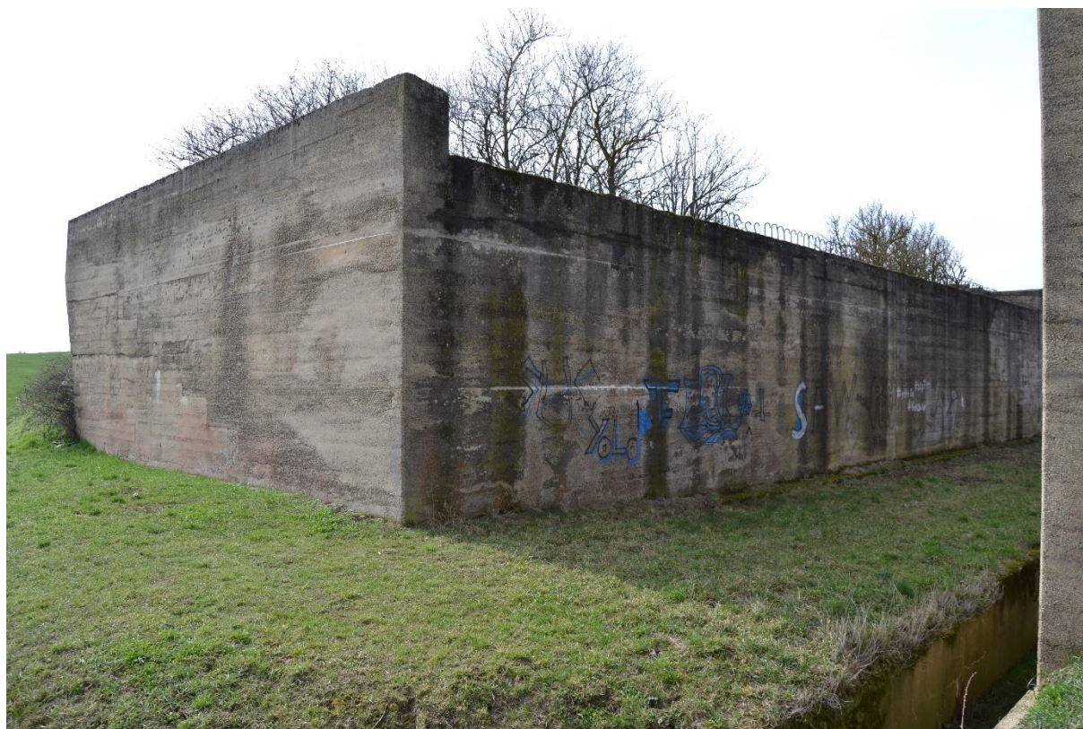
Obr. 78 Most (M. Sedlák, březen 2019)
