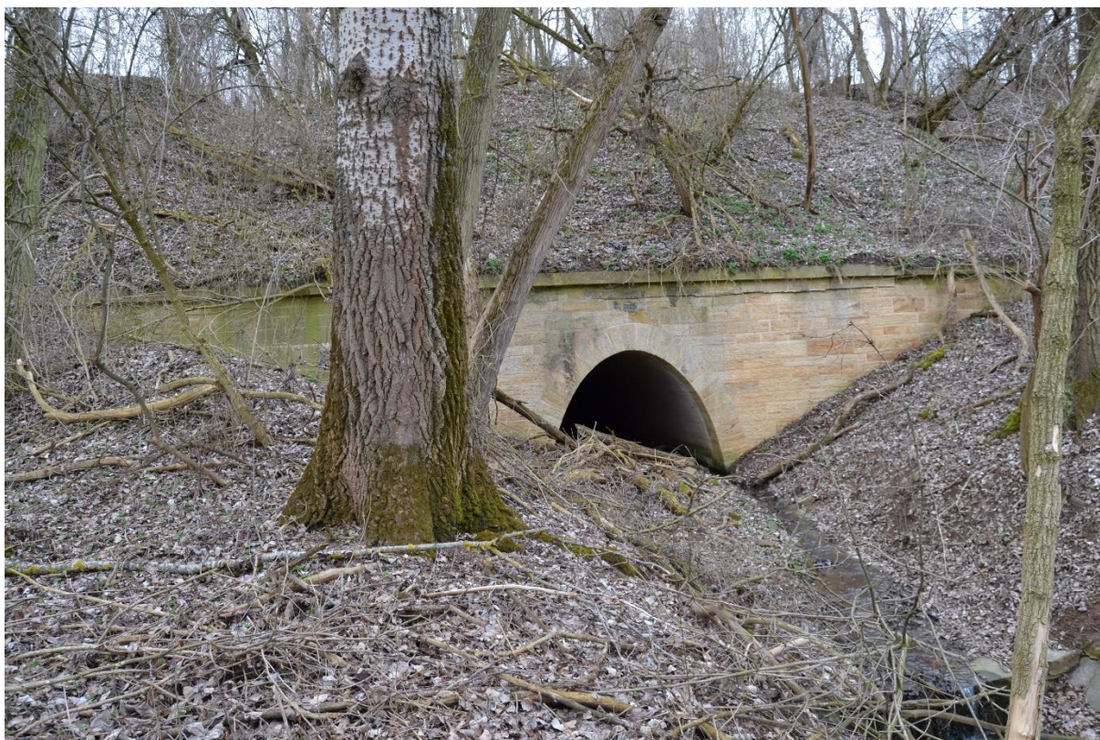
Obr. 106 Propustek (M. Sedlák, březen 2019)
