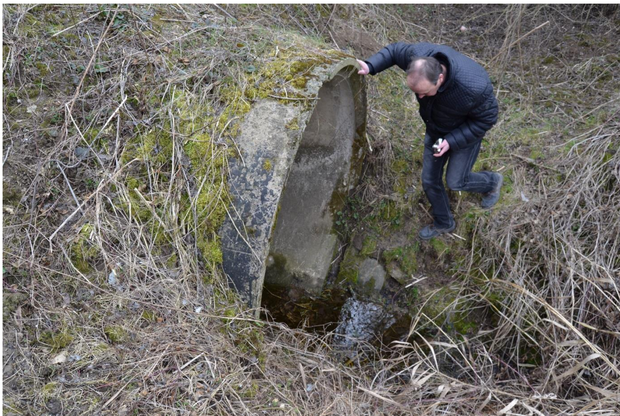
Obr. 49 Propustek (M. Sedlák, březen 2019)
