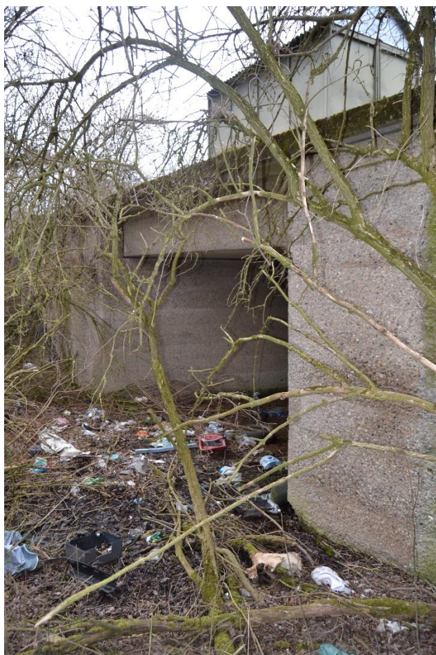
Obr. 7 Most (M. Sedlák, březen 2019)
