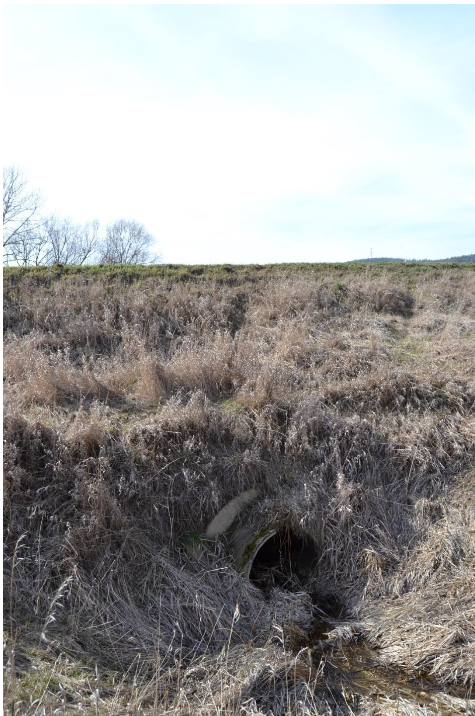
Obr. 74 Propustek (M. Sedlák, březen 2019)
