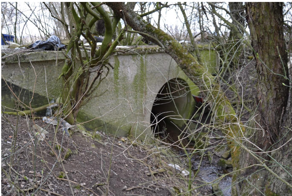
Obr. 57 Propustek (M. Sedlák, březen 2019)
