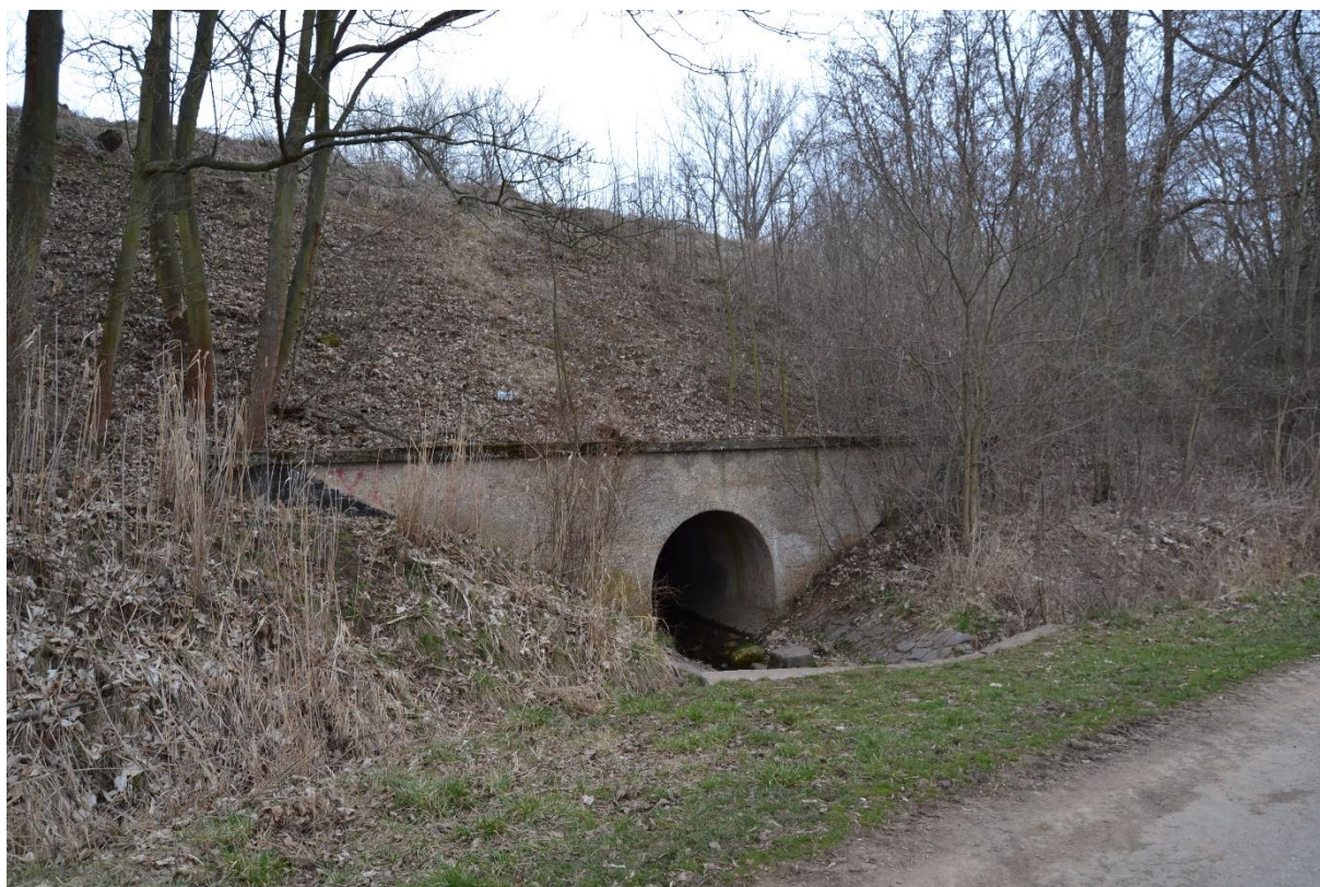
Obr. 8 Most (M. Sedlák, březen 2019)
