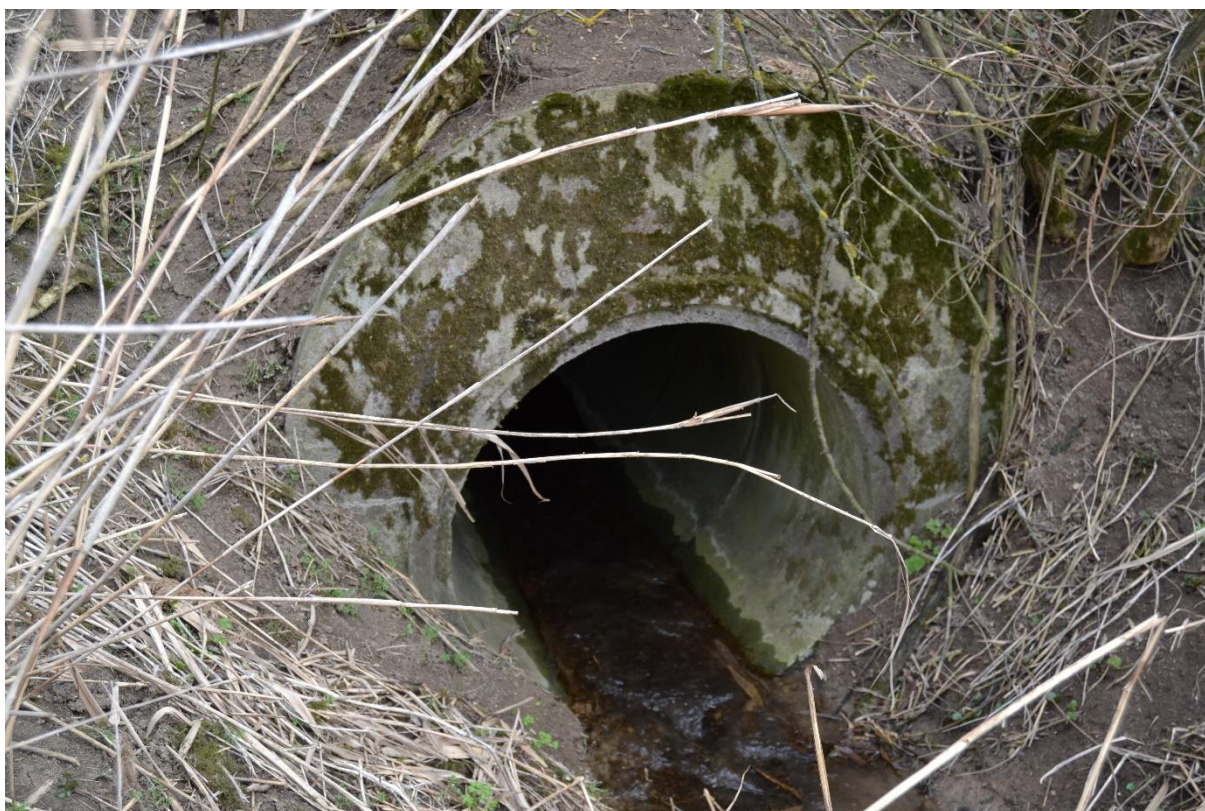
Obr. 59 Propustek (M. Sedlák, březen 2019)
