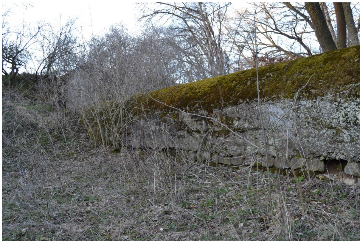
Obr. 67 1x lomený propustek (M. Sedlák, březen 2019)
