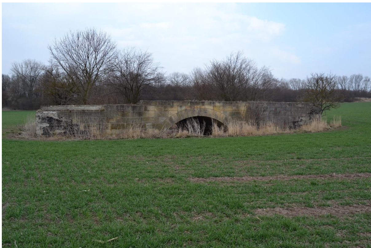
Obr. 13 Most (M. Sedlák, březen 2019)
