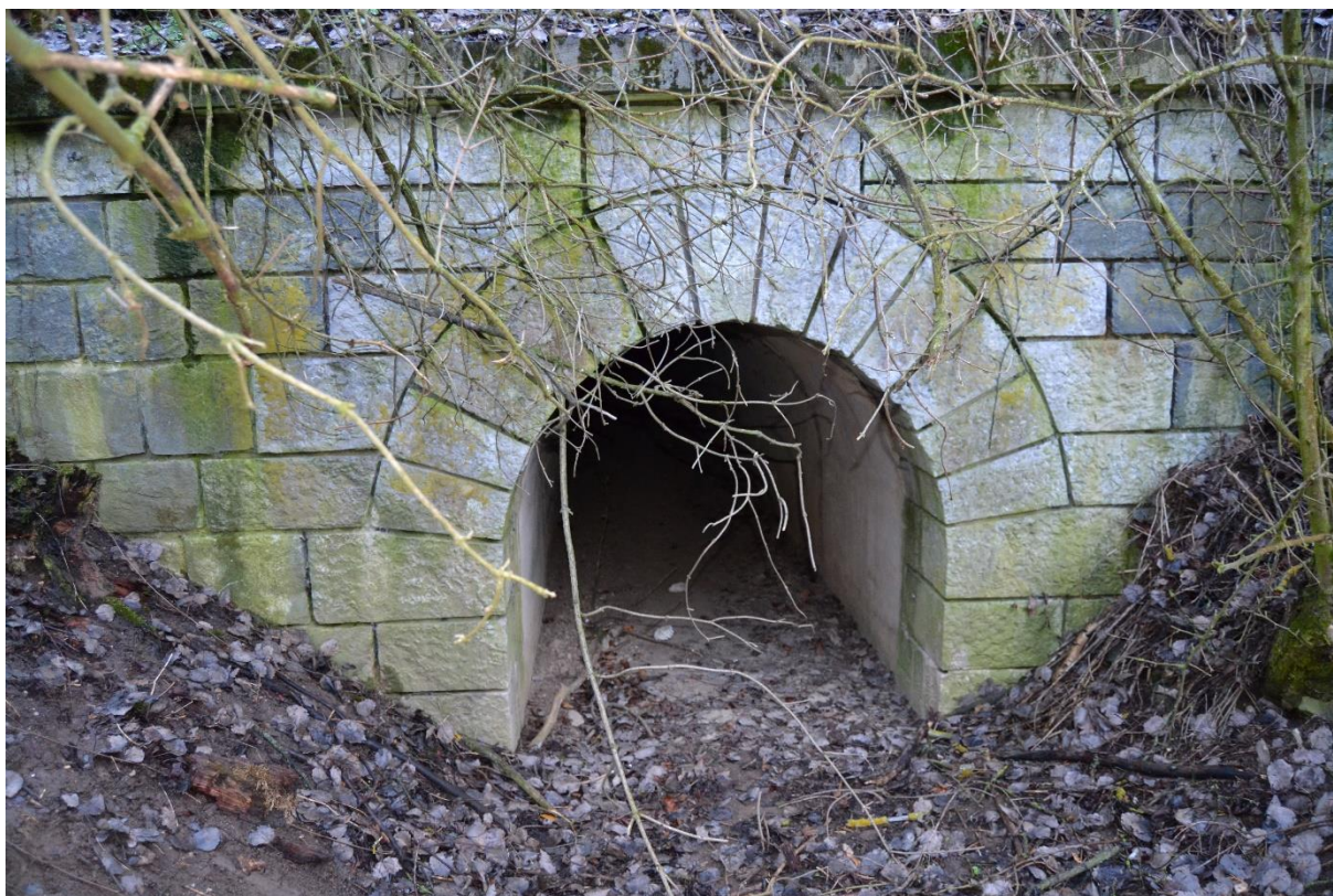
Obr. 89 Propustek (M. Sedlák, březen 2019)
