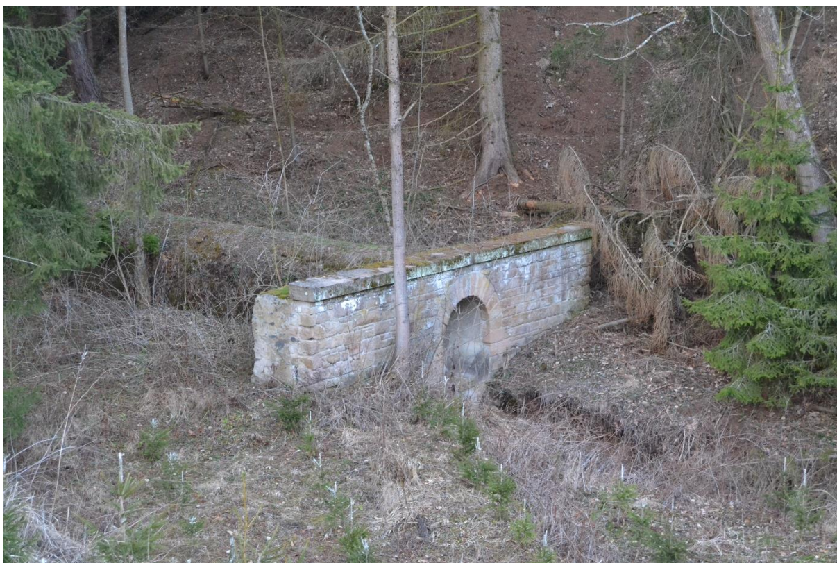
Obr. 65 Propustek (M. Sedlák, březen 2019)
