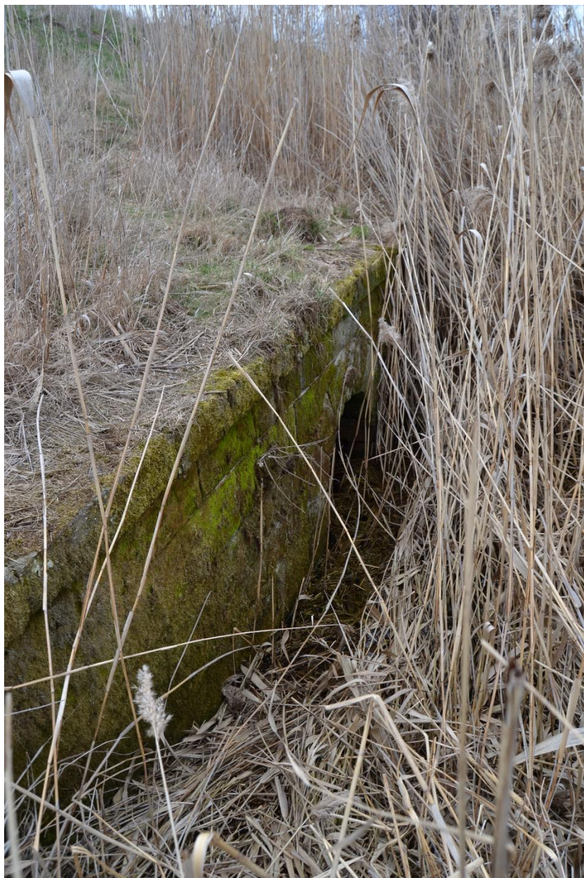
Obr. 47 Propustek (M. Sedlák, březen 2019)
