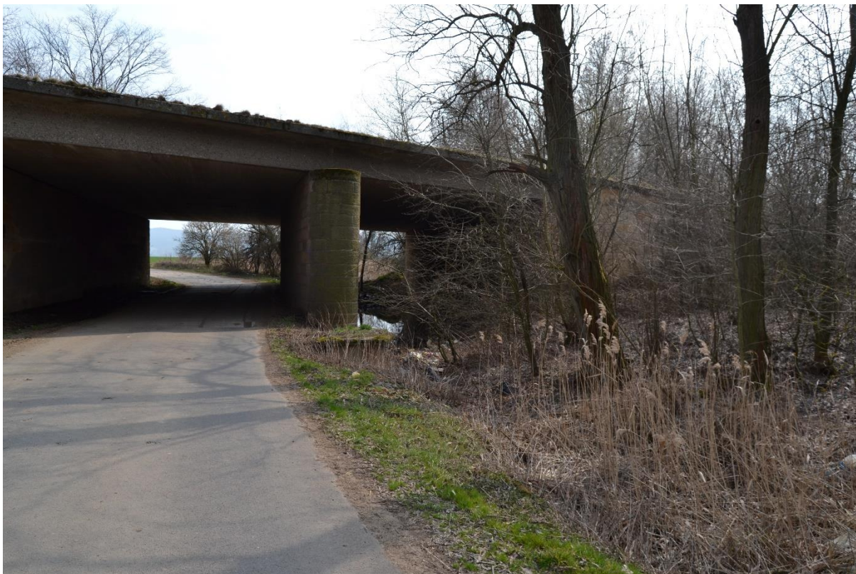
Obr. 21 Most (M. Sedlák, březen 2019)
