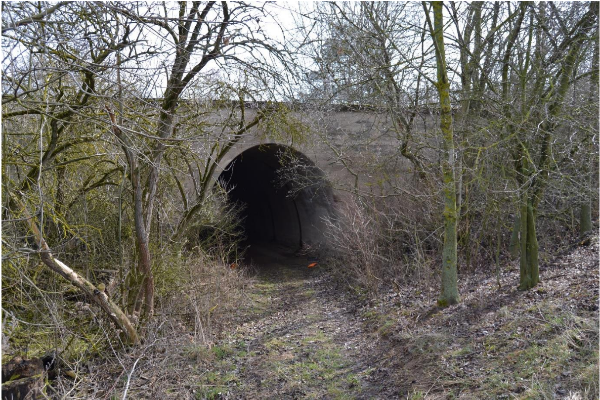
Obr. 83 Most (M. Sedlák, březen 2019)
