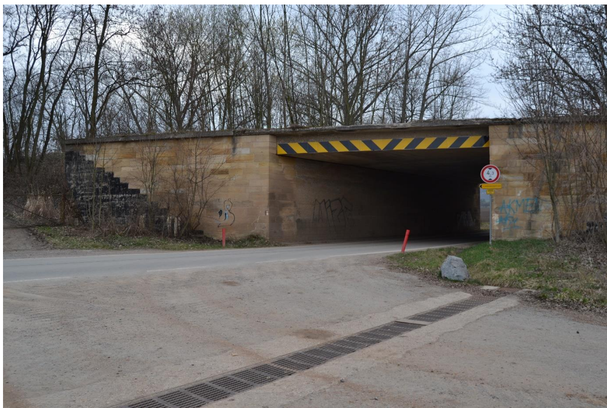
Obr. 10 Most (M. Sedlák, březen 2019)
