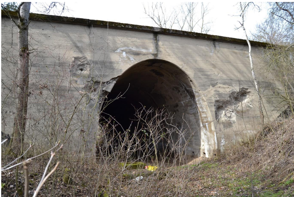
Obr. 84 Most (M. Sedlák, březen 2019)
