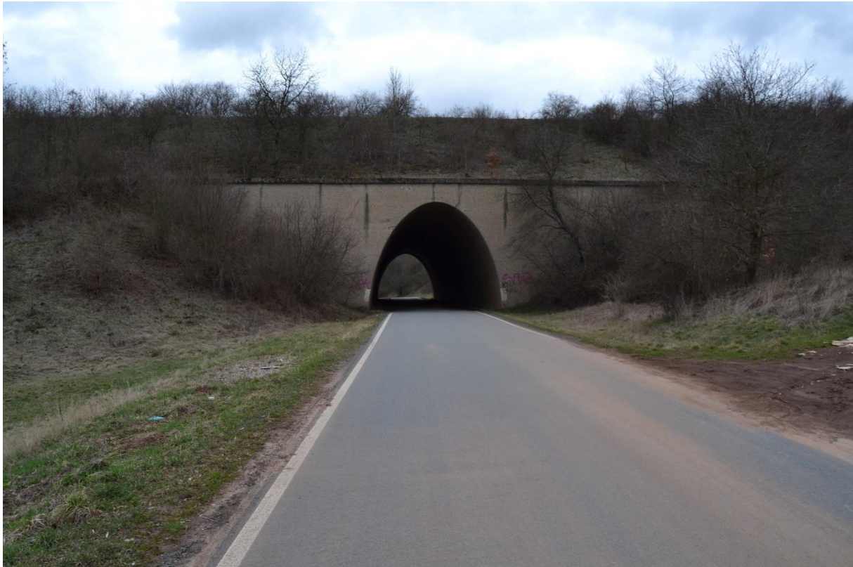
Obr. 42 Most (M. Sedlák, březen 2019)
