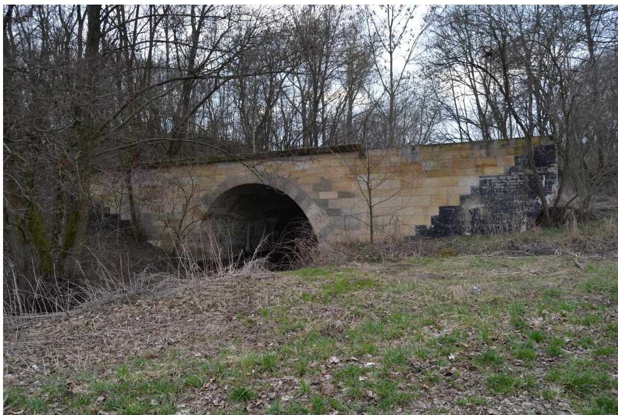
Obr. 15 Most (M. Sedlák, březen 2019)
