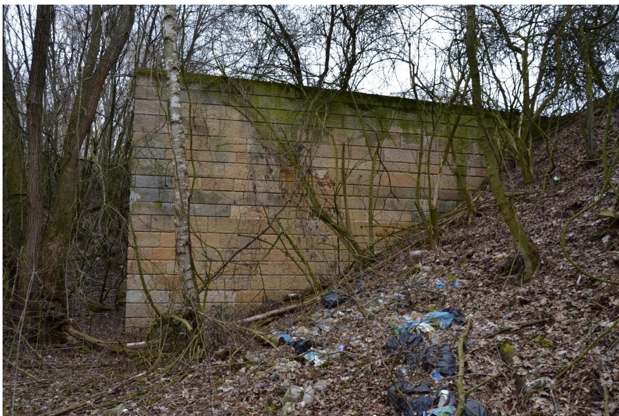
Obr. 53 Most (M. Sedlák, březen 2019)
