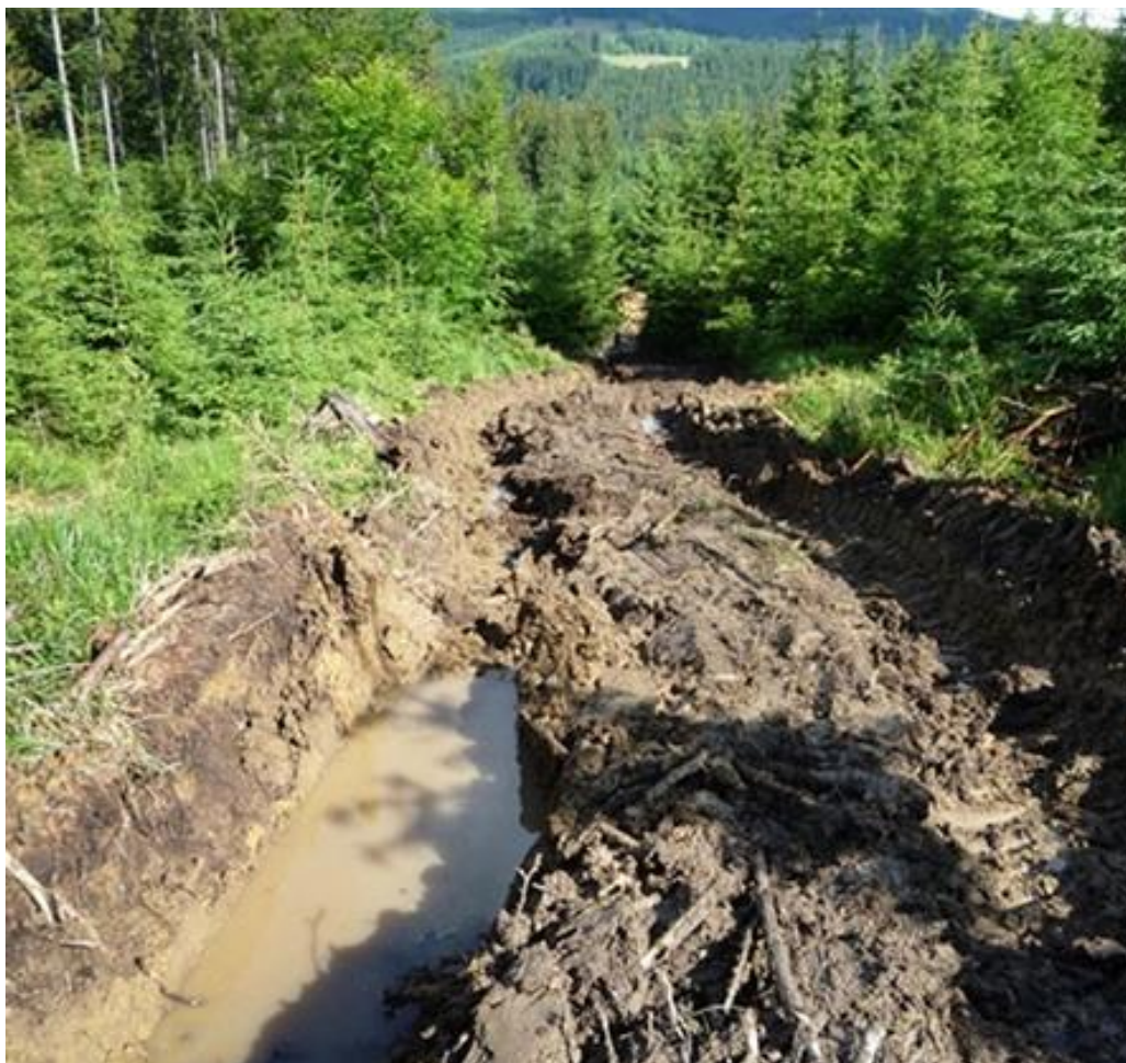
Obr. č. 8 Vyjeté koleje v Klanovickém lese po těžké těžební technice [23]
