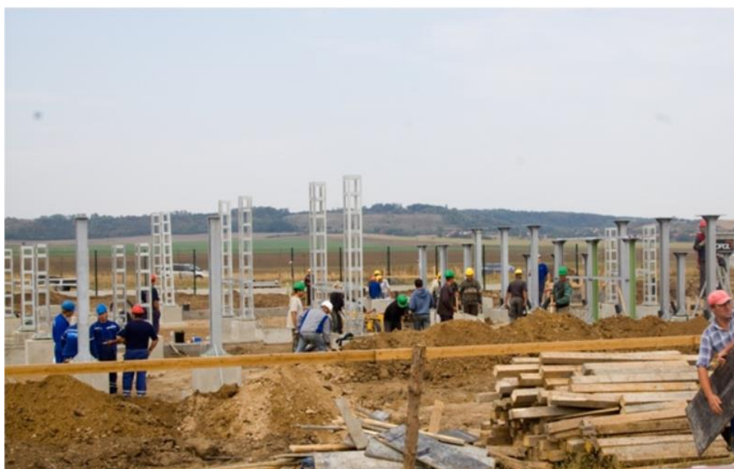
Obr. 10: Výstavba nosné konstrukce pro panely (Decci, ©2020)
