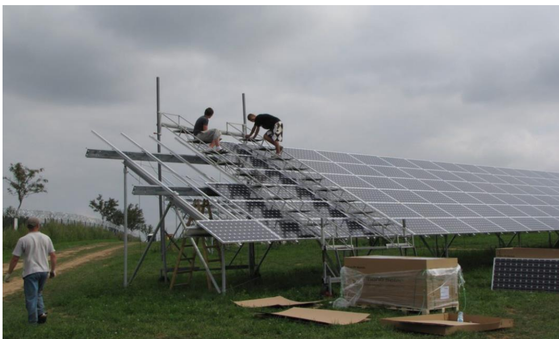
Obr. 11: Instalace panelů na nosnou konstrukci (Decci, ©2020)
