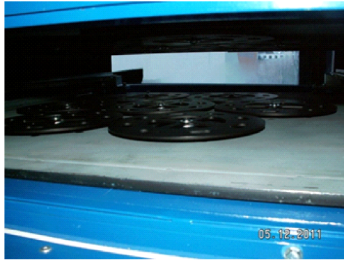
Obrázek 67: Pohled mezi tryskové komory osazené mechanickými oscilátory
