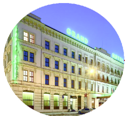
FOTO STÁVAJÍCÍHO STAVU
