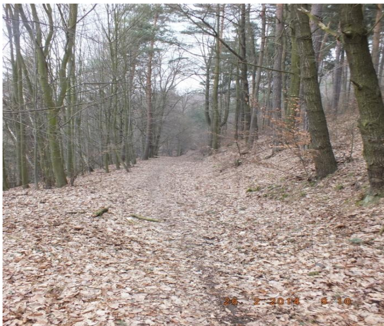
Obrázek 4 Lesní cesta 4L před rekonstrukcí
