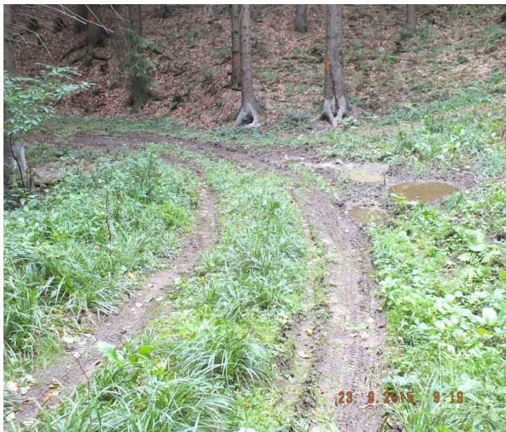
Obrázek 6 Lesní cesta 3L před rekonstrukcí
