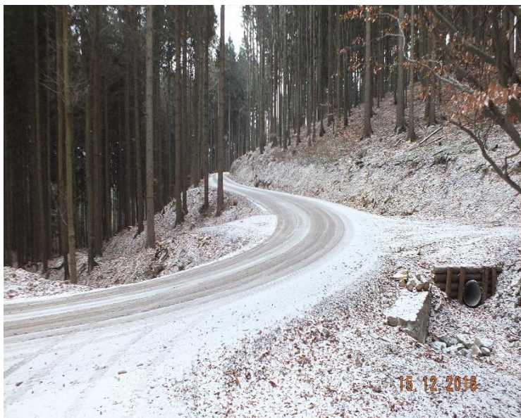
Obrázek 7 Lesní cesta 2L po rekonstrukci
