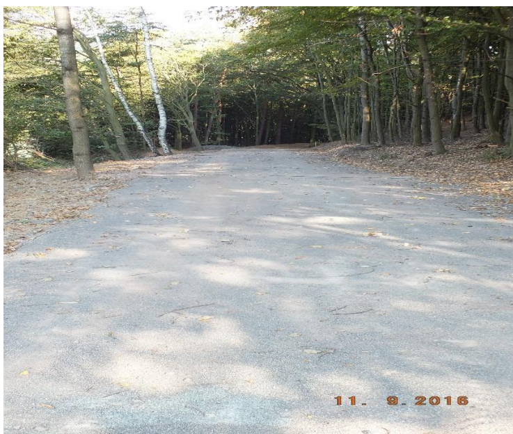
Obrázek 5 Lesní cesta 3L po rekonstrukci
