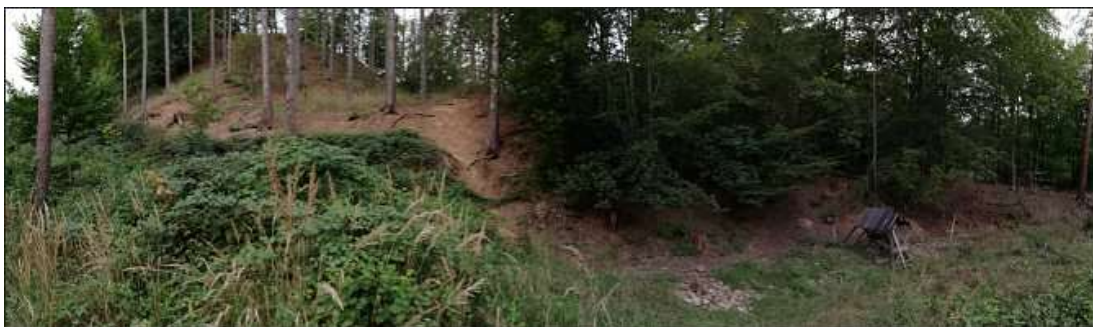
Obr. 8.10: Svah hlinišť, pohled z východu na západ (8.9.2019).
