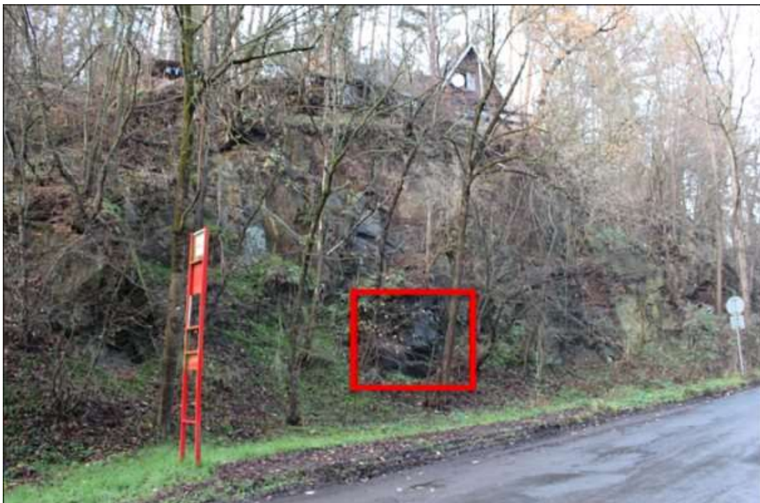
Obr. 8.27: Lomová stěna s vyznačeným místem odběru vzorku, pohled z jihovýchodu na severozápad (17.11.2019).
