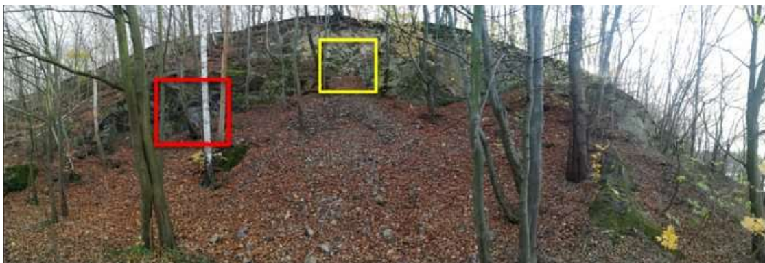
Obr. 8.32: Lomová stěna s vyznačenými místy odběru vzorků, pohled ze severozápadu na jihovýchod (4.11.2017).
