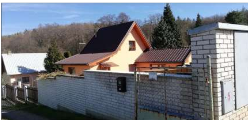
Obr. 8.25: Místo bývalého hlinišťe a cihelny, pohled ze severozápadu na jihovýchod (15.3.2020).
