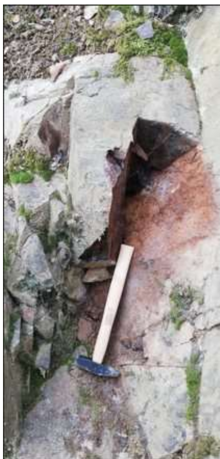
Obr. 8.35: Detail výše položeného místa odběru vzorku (značeno žlutě), (25.1.2020).
