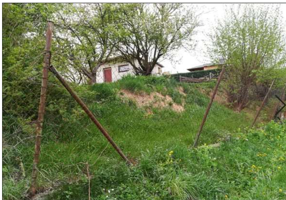
Obr. 8.4: Místo bývalého hlinišťe, pohled od východu na západ (24.4.2018).
