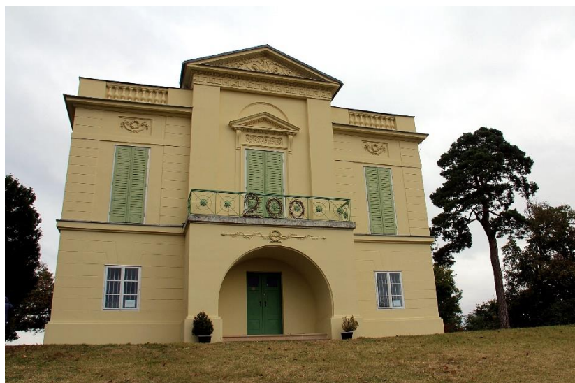
Obr. 78 Pohled na jižní průčelí Rybníčního zámku (Muchová, 2016)
