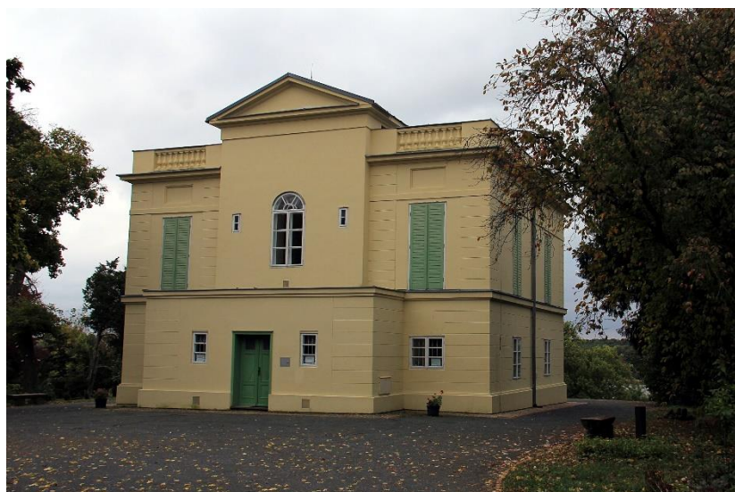
Obr. 79 Pohled na severní stranu Rybníčního zámku (Muchová, 2016)
