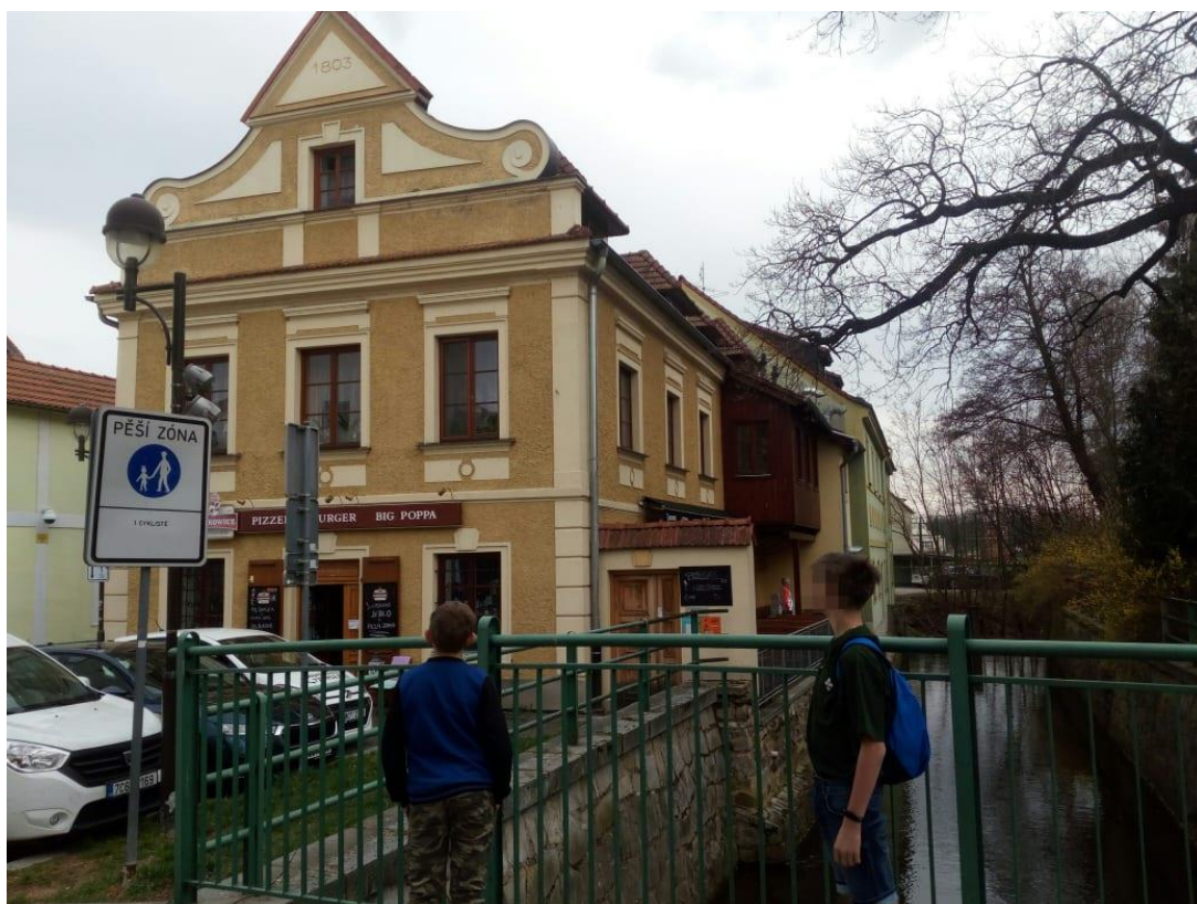
Obrázek č. 21 – Budova bývalého Zadního mlýna, zdroj: archiv autora
