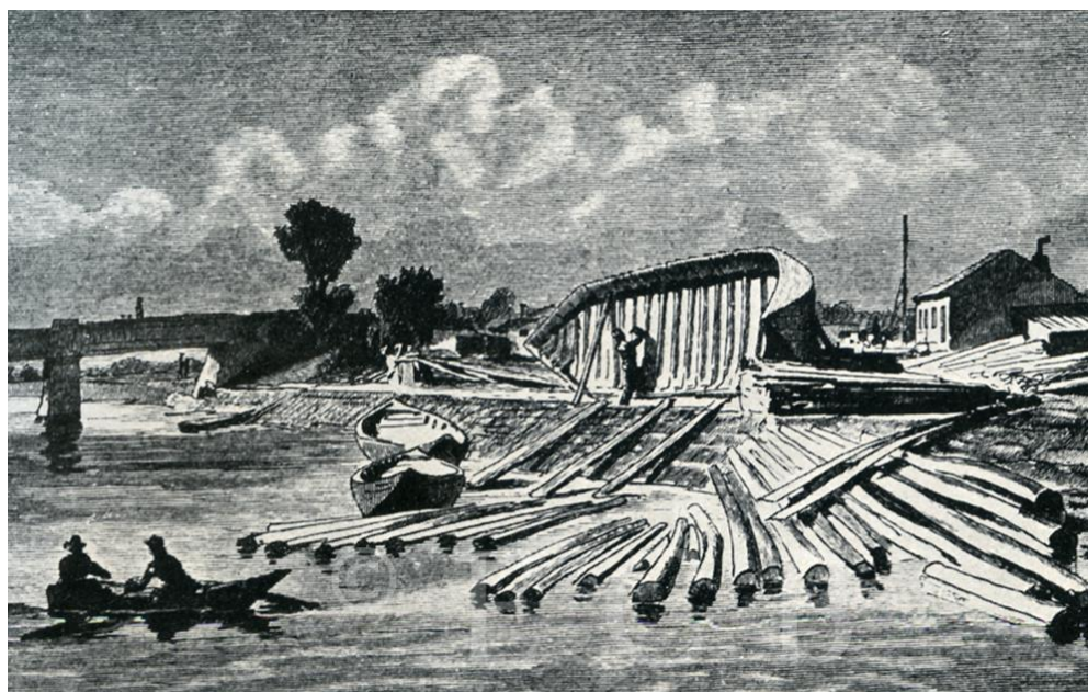
Obrázek č. 34 – Stavba lodi v Lannově loděnici, zdroj: ://encyklopedie.c-budejovice.cz
