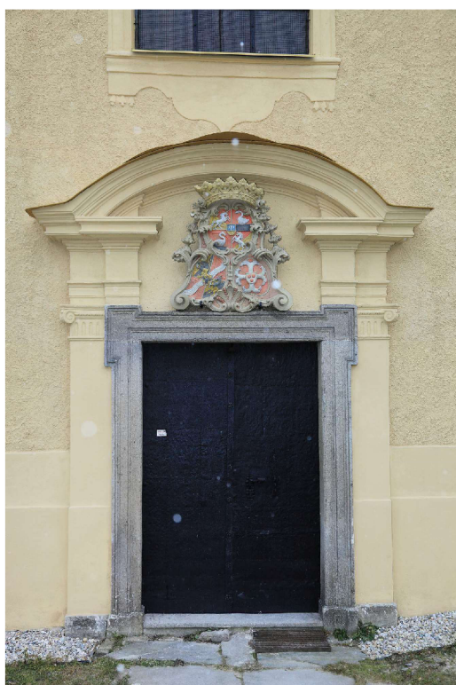
Obr č. 4. Portál západního průčelí, foto: Římskokatolická farnost Kaplice.
