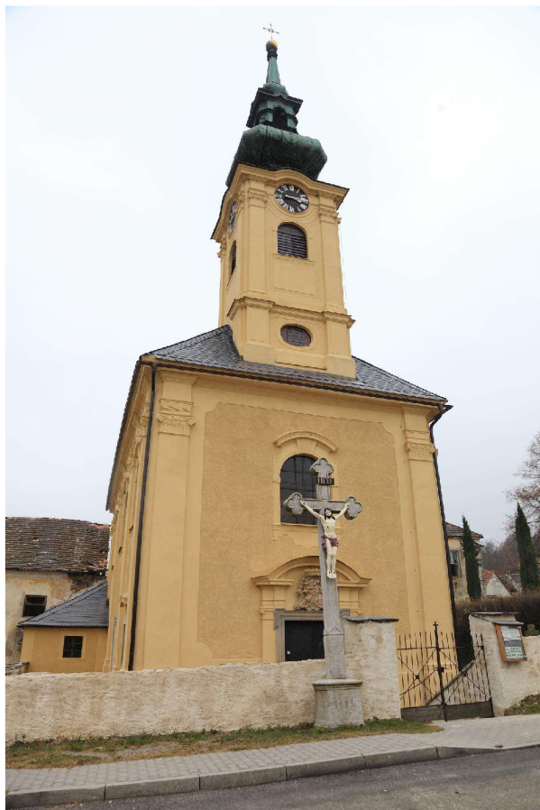
Obr. Č. 1., Západní průčelí, foto: Římskokatolická farnost Kaplice
