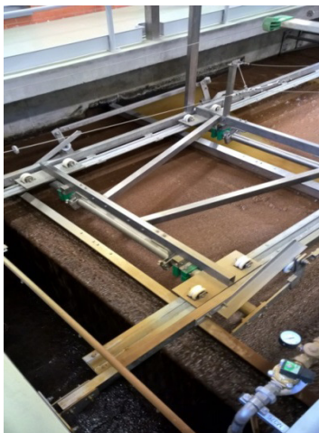
obr. 50 Zesílení dimenze tažného lanka shrabovacího zařízení vyfotovaného kalu (SČVK 2016)
