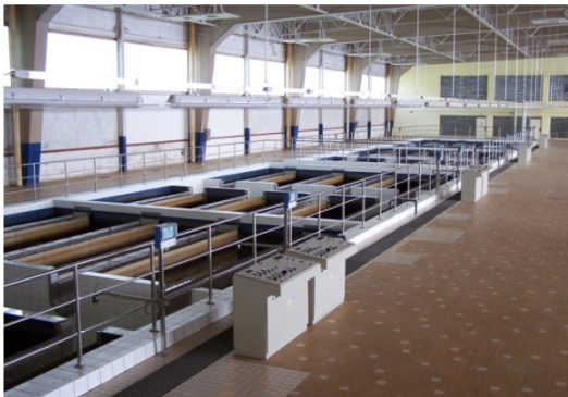
obr. 12 Filtrace po rekonstrukci – vlastní foto 2018
