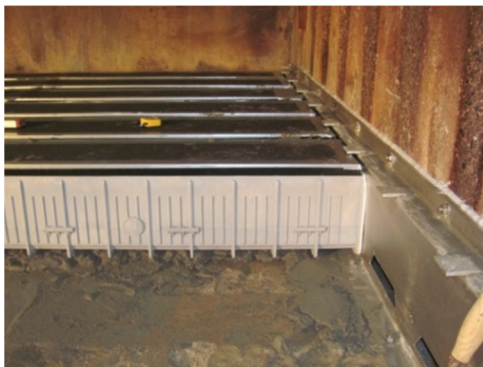
obr. 52 Instalace drenážního systému (SčVK 2011) obr. 53 Zlepšení odtoku prací plochy (SčVK 2015)
