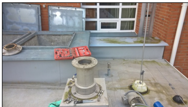
obr. 48 Doplnění protilehlého ložiska pro zpevnění osy míchadla (SčVK 2016)
