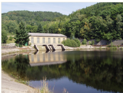
obr. 42 ÚV Meziboří – vyrovnávací nádrž - vlastní foto 2018
