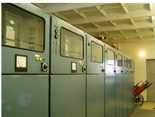
obr. 6 Rozvodna VN před rekonstrukcí (SČVK, 1999) obr. 7 Rozvodna VN nová - vlastní foto 2018
