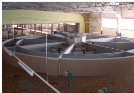
obr. 8 Reakční nádrž před rekonstrukcí (SČVK, 1999) obr. 9 Reakční nádrž nová - vlastní foto 2018
