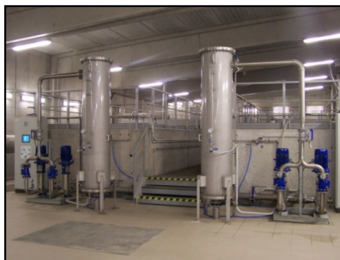
obr. 27 Sekce flotace – vlastní foto 2018
