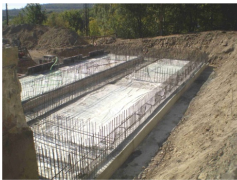
obr. 26 Výstavba haly flotace a filtrace (SčVK, 2011)
