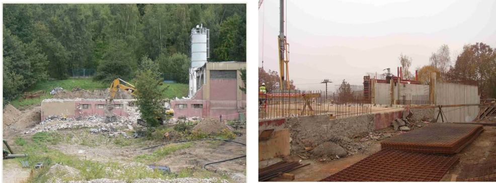
obr. 24 a obr. 25 Rekonstrukce ÚV Jirkov (SčVK 2011)
