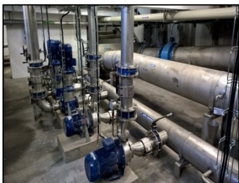
obr. 45 UV lampy – vlastní foto 2018
