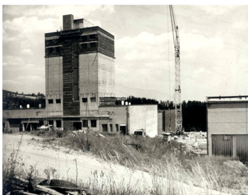
obr. 1 ÚV Hradiště – výstavba (SčVK, 1972)
