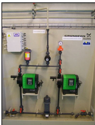
obr. 31 Dávkování polymerního flokulantu – vlastní foto 2018
