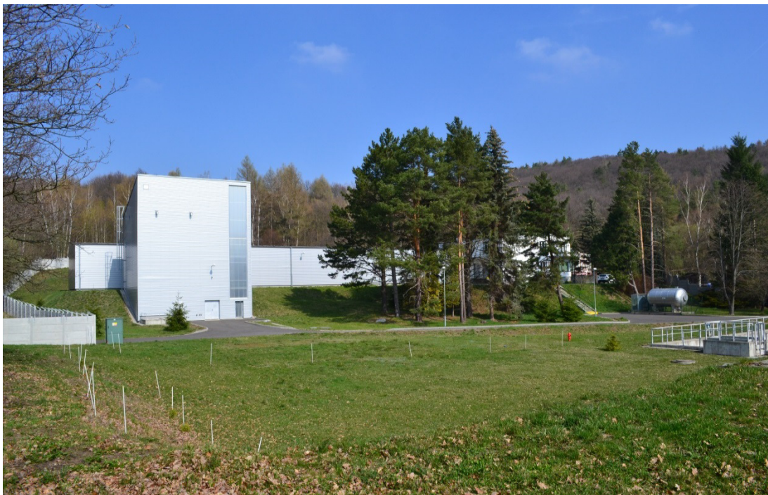
obr. 21 Úpravna vody Jirkov (vlastní foto 2019)
