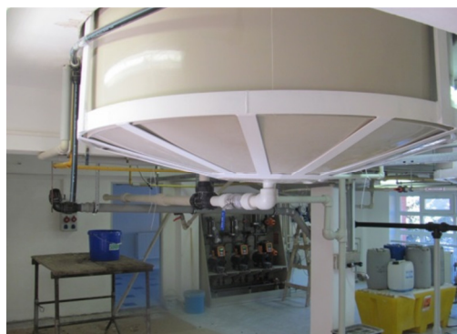
obr. 46 Dávkování chemikálií – vlastní foto 2018
