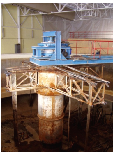
obr. 8 Reakční nádrž před rekonstrukcí (SČVK, 1999) obr. 9 Reakční nádrž nová - vlastní foto 2018
