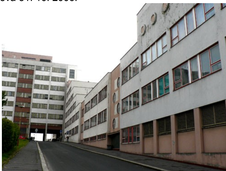
[97n] Vít Obrtel, Nemocnice s poliklinikou, Purkyňova 1849, Česká Lípa 1976-1985. Foto Jitka Kubištová 31. 10. 2006.
