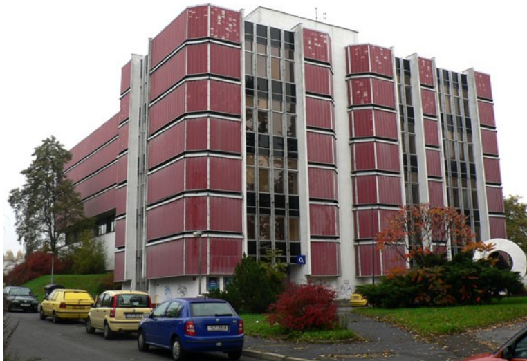
[99] Spojprojekt Praha, zodpovědná projektantka Lenka Vrbová, Telekomunikační budova, U Spojů 2675, Česká Lípa 1979-1984. Foto Jitka Kubištová 28. 10. 2006.
