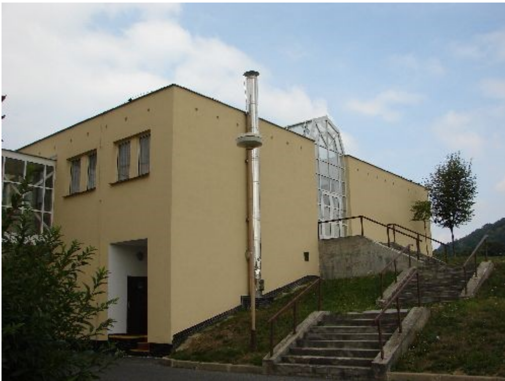
[125a] Ateliér 4, Jablonec nad Nisou, Gymnázium- stravovna, Žitavská 2969, Česká Lípa 1993. Foto Jitka Kubištová 28. 10. 2006.
