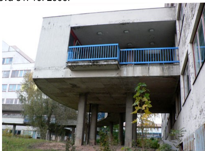
[97n] Vít Obrtel, Nemocnice s poliklinikou, Purkyňova 1849, Česká Lípa 1976-1985. Foto Jitka Kubištová 31. 10. 2006.
