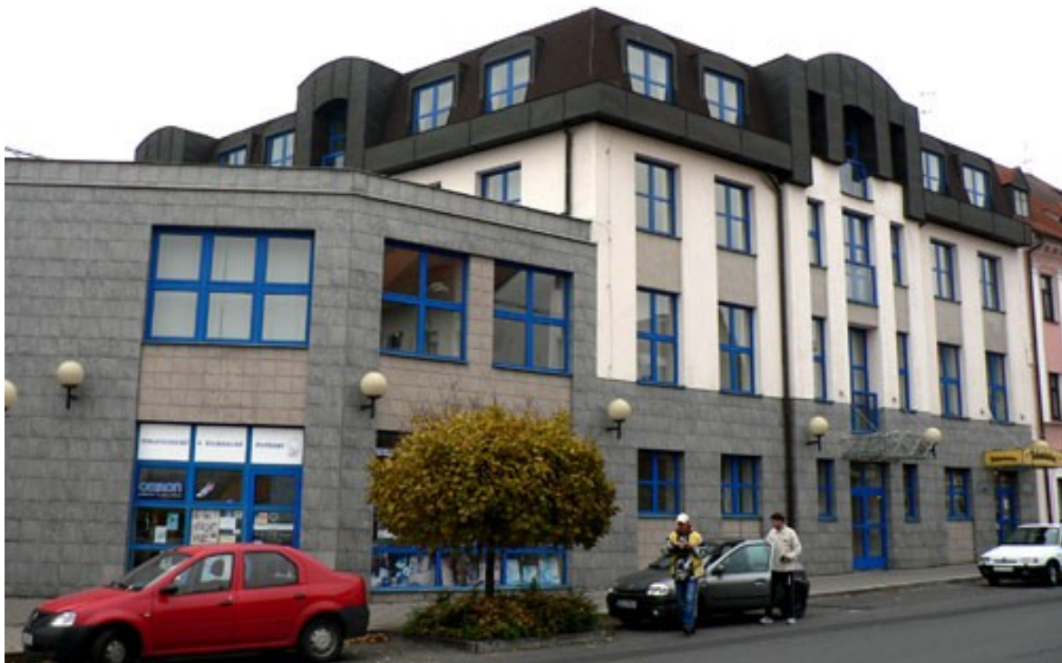
[124] Jiří Kňákal - Luboš Kotiš - Zdeněk Šťastný, Provozní budova České pojišťovny, U synagogy 2983, Česká Lípa 1993-1995. Foto Jitka Kubištová 28. 10. 2006.
