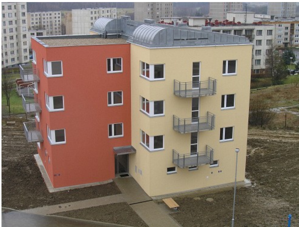
[122] Filip Řepka, S.P.A.D. spol. s r. o., Obytný dům typu VDF, Česká Lípa Lada 2000-2004. Obrázek použit z http://www.spad-architekti.cz/projekty017.htm .
