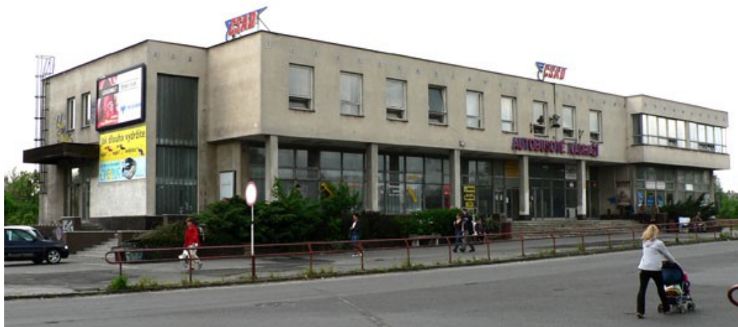
[100] Irena Šaumanová ČVUT Praha, Výpravní budova ČSAD, Konopeova 2723, Autobusové nádraží Česká Lípa 1983. Foto Jitka Kubištová 28. 10. 2006.
