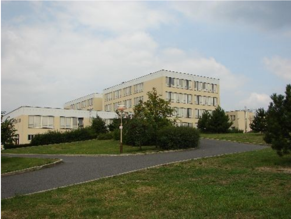
[125] Stavoprojekt Liberec, Gymnázium, Žitavská 2969, Česká Lípa 1990-1993. Foto Jitka Kubištová 28. 10. 2006.
