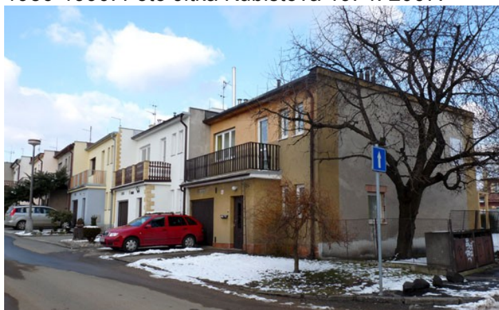
[71] Rodinné domy typu OKAL, Příčná ulice, Česká Lípa 1970-1971. Foto Jitka Kubištová 7. 3. 2010.
