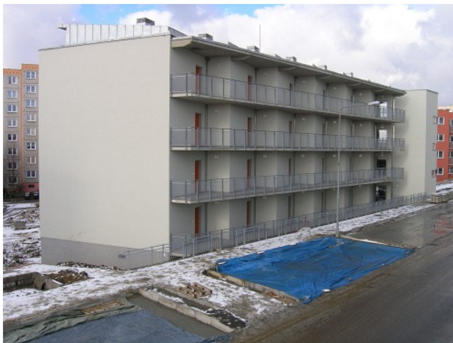
[120] Filip Řepka, S.P.A.D. spol. s r. o., Obytný dům typu VP, Česká Lípa Lada 2000-2007. Obrázek použit z http://www.spad-architekti.cz/projekty017.htm .
