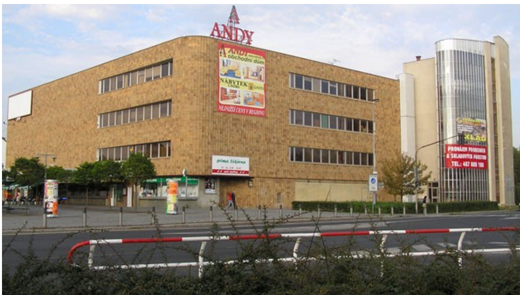
[102c] Zdeněk Řihák – Jana Emmerová a kolektiv Státního projektového ústavu obchodu v Brně, Obchodní dům PRIOR, Erbenova 2906, Česká Lípa 1984-1990. Foto Jitka Kubištová 30. 9. 2006.
