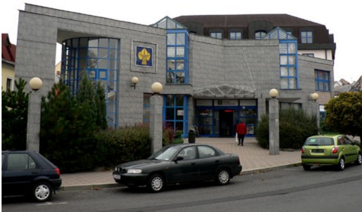
[124a] Jiří Kňákal - Luboš Kotiš - Zdeněk Šťastný, Provozní budova České pojišťovny, U synagogy 2983, Česká Lípa 1993-1995. Foto Jitka Kubištová 28. 10. 2006.
