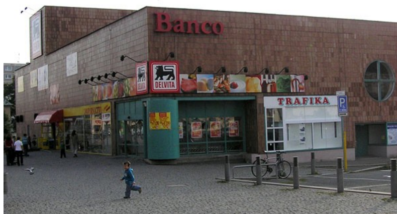
[91b] Emil Přikryl, Nákupní středisko Uran, Dr. Edvarda Beneše 2662, Česká Lípa 1975-1983. Foto Jitka Kubištová 5. 10. 2006.
