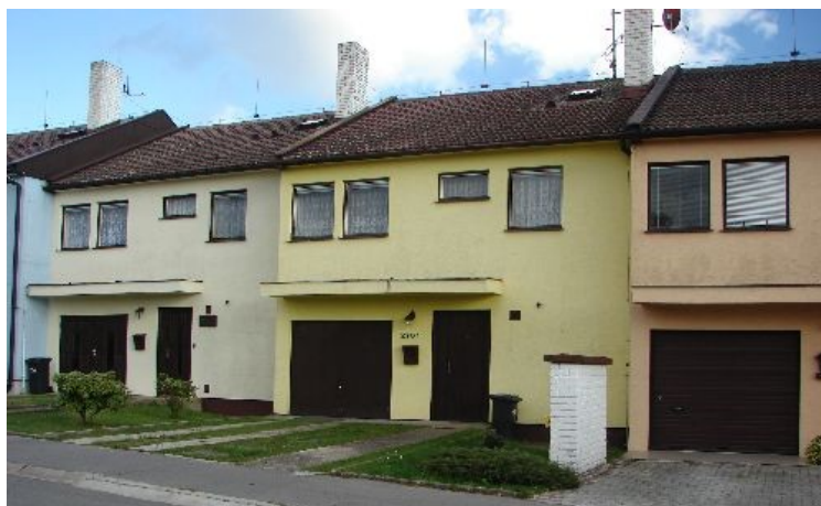
[72] Rodinné domy typu OKAL pod Hůrkou, Jasmínová ulice, Česká Lípa 1982-1988. Foto Jitka Kubištová 7. 3. 2010.
