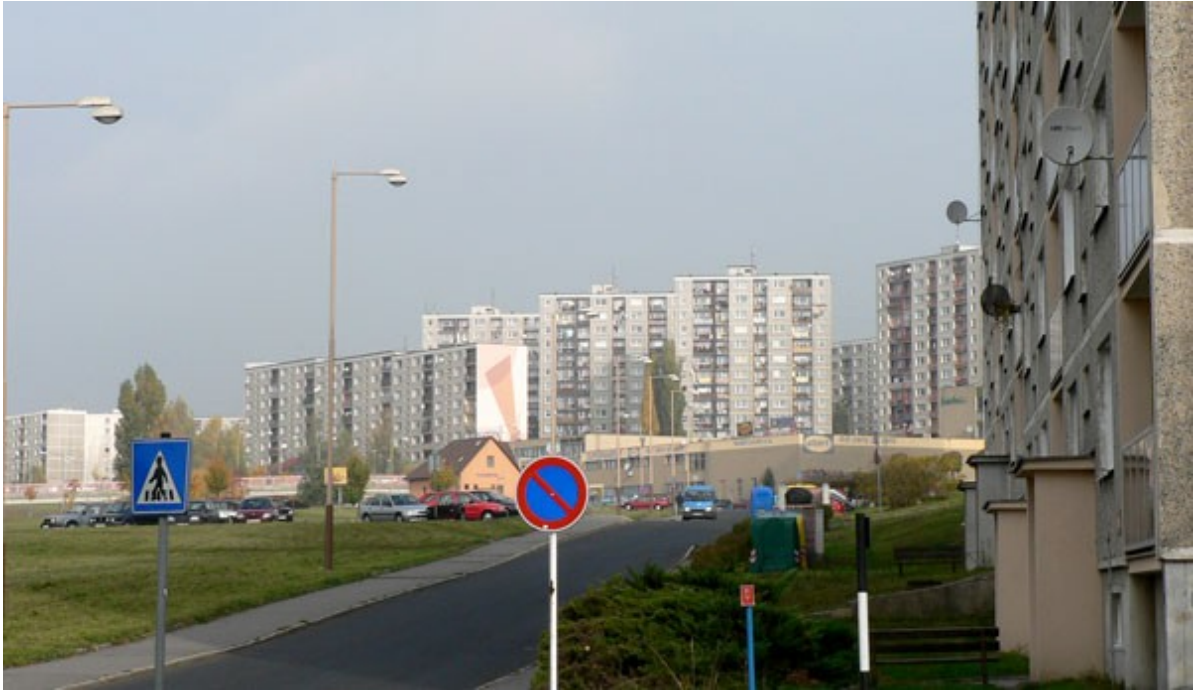
[82] Zdeněk Brynda, Panelové sídliště Špičák, Česká Lípa 1976-1987. Foto Jitka Kubištová 28. 10. 2006.
