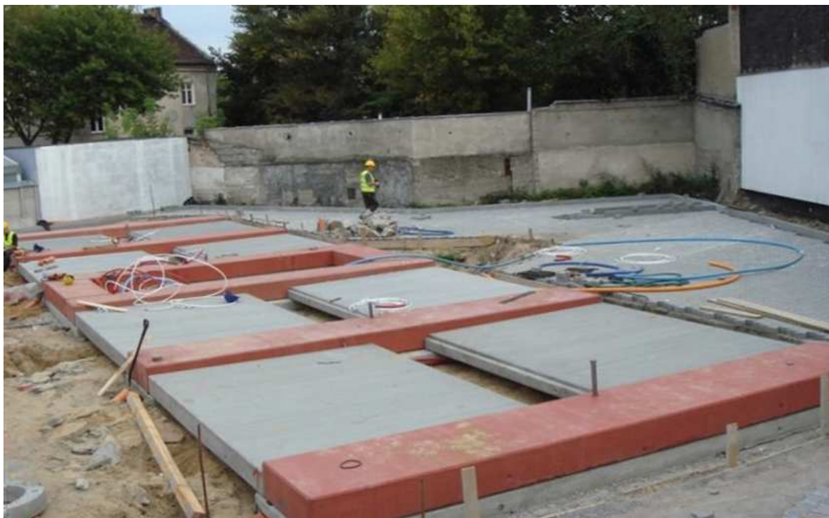
OBRÁZEK 16 - VÝSTAVBA MYČKY - PREFABRIKOVANÁ DESKA, KONSTRUKCE STŘECHY
