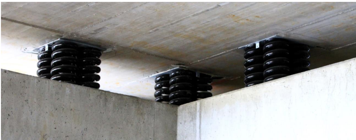
Obr. 3.3 - Pružinový izolátor [20]
