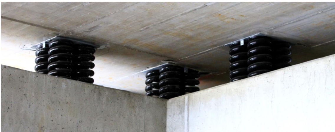
Obr. 3.3 - Pružinový izolátor [20]
