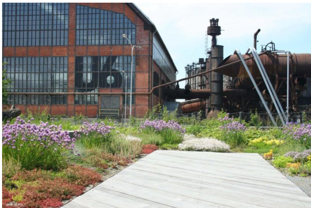
Obr. 28: Střešní zahrada v rámci experimentální výstavy Svět techniky v ostravských Vítkovicích (Zdroj: Autorka, 2015)
