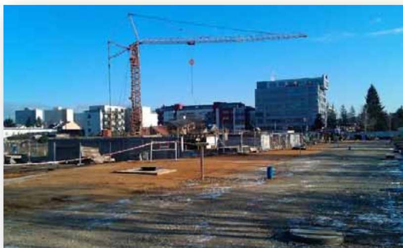
obr. č. 134: Průběh výstavby, [36]
