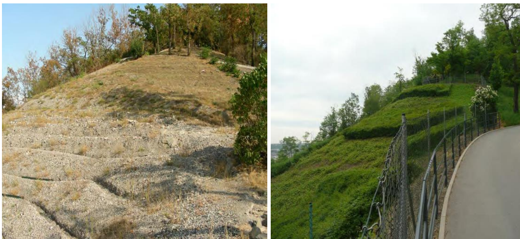
Obrázek 15a, b. Zajištění svahů nového železničního spojení v Praze. Vlevo původní svah, vpravo zajištěný svah po aplikaci PEO (Zlatuška 2013).
