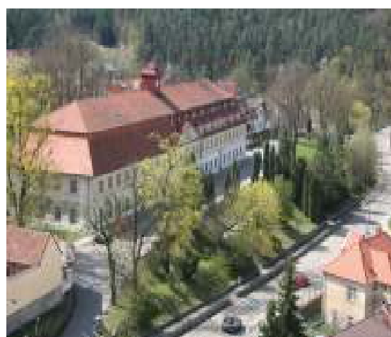
bývalá továrna na kameninu(dnes kulturní dům)
