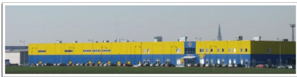
Obr.7: Logistické centrum p.k.Solvent s.r.o. Olomouc 40
