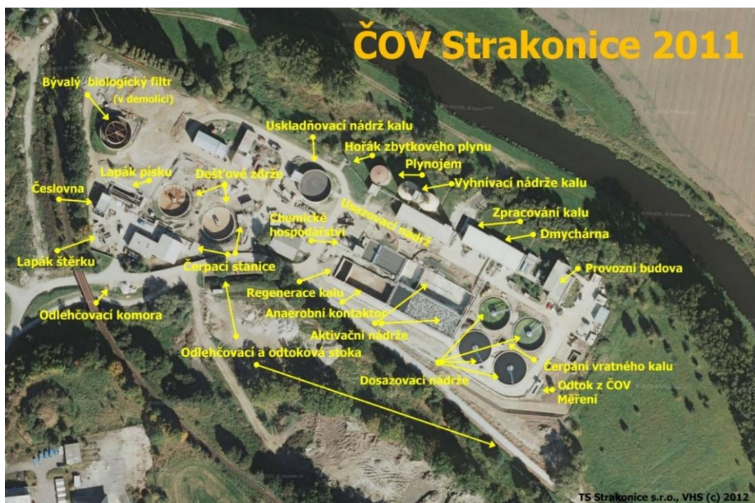
Obrázek 5.2 – ČOV (ČOV Strakonice)
