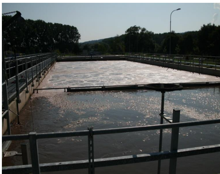
Obrázek 5.3 – Nitrifikační zóna (ČOV Strakonice, 2016)
