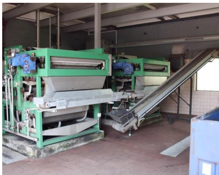
Obrázek 4.6 – Sítopásové lisy kalu (ČOV Strakonice, 2013)
