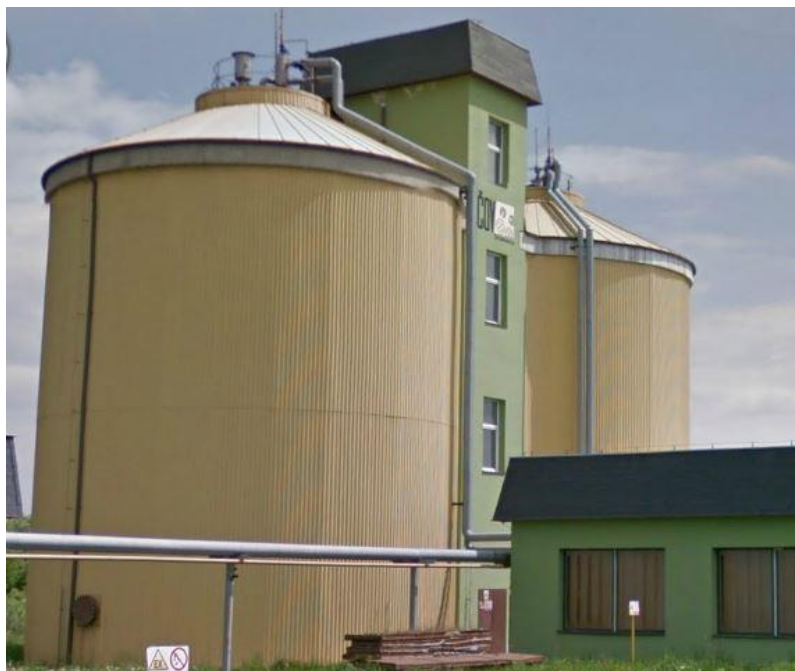
Obrázek 5.5 – Vyhnívací nádrže (ČOV Strakonice, 2016)
