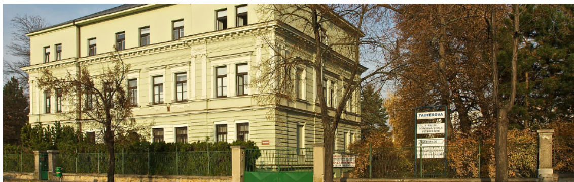
Obr. 2 Budova školy Zdroj: vetkm.cz (2015)
