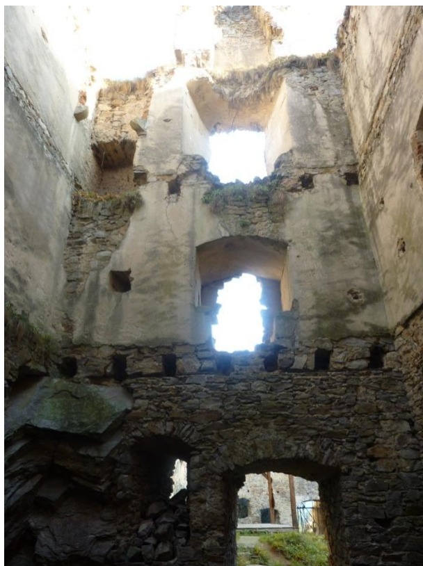
19. Stěna západního paláce s pozůstatky po kamenném krbu
