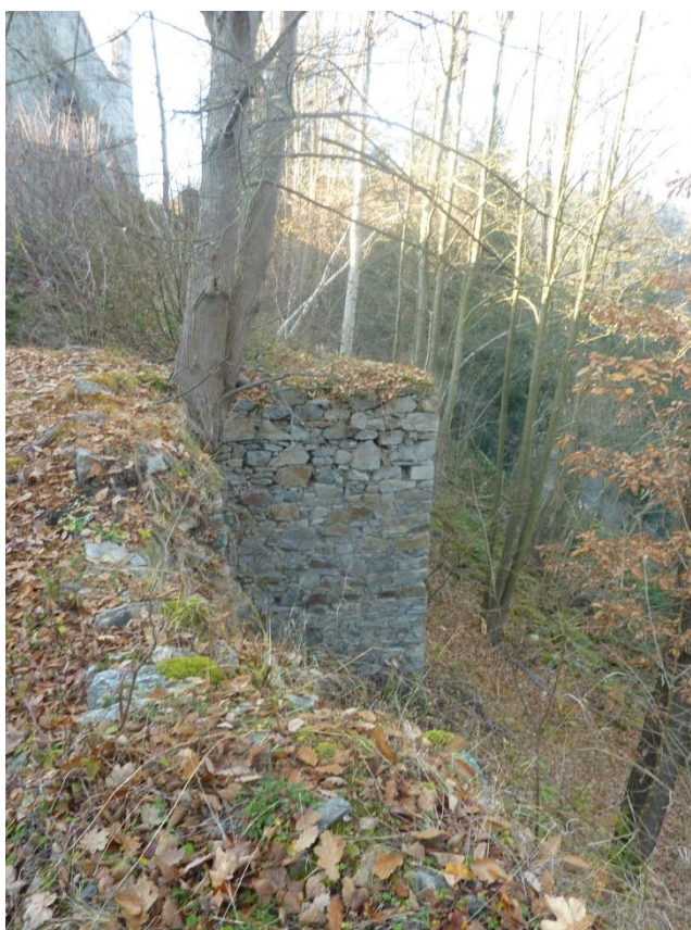
24. Střední obranná bašta
