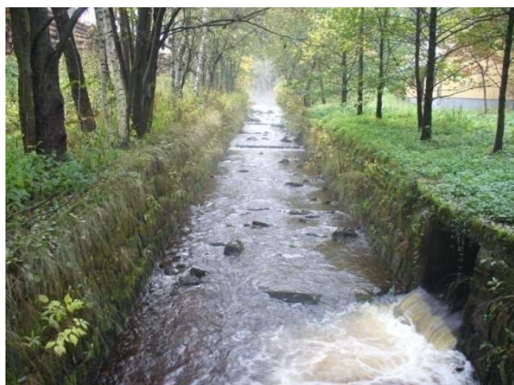
Obr. 5: Uměle upravované koryto za areálem pily Katr a.s.
