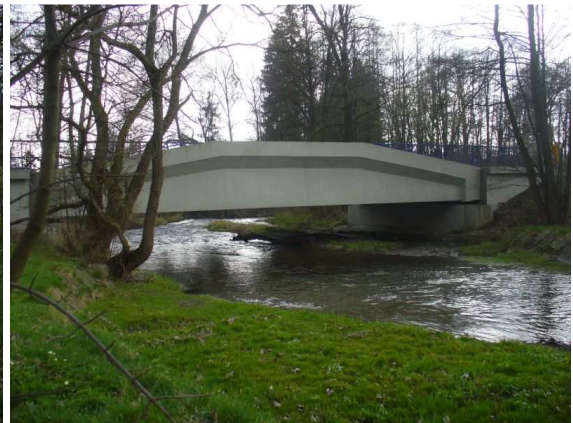
Obr. 4: Tentýž pohled vlevo na nový most v Malé Štáhlí
