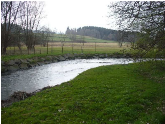
Obr. 3: Zpevněný pravý břeh a niva v intravilánu obce Malá Štáhlé
