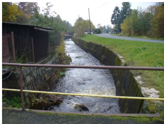
Obr. 8: Upravené kamenné koryto mezi zástavbou Staré Vsi
