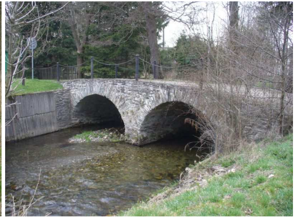
Obr. 2: Barokní most a opěrná zeď pravého břehu v Dolní Moravici
