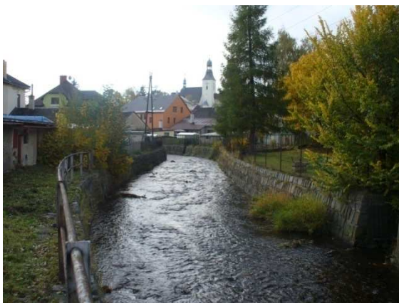
Obr. 15: Upravené koryto z lomového kamene v Rýmařově před ulicí Revoluční
