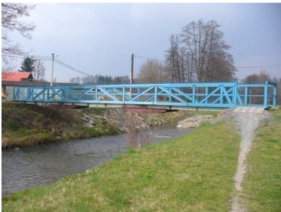
Obr. 11: Lávka přes řeku vedoucí ke skladu aluminiových plechů
