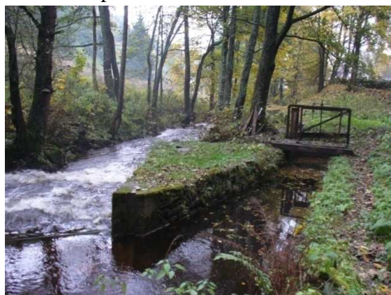
Obr. 6: Náhon k vodní elektrárně ve Staré Vsi
