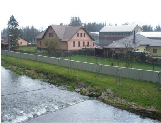
Obr. 7: Pravý břeh s protipovodňovou zdí ve Velké Štáhli
