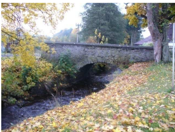
Obr. 9: Pohled na 1. kamenný most ve Staré Vsi
