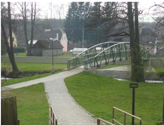
Obr. 9: Nová lávka přes řeku naproti Obecnímu úřadu ve Velké Štáhli
