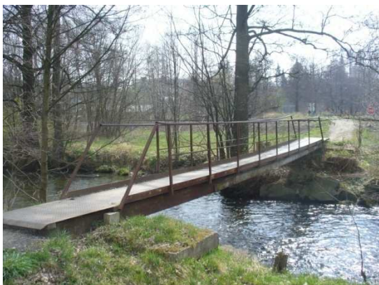
Obr. 13: Lávka přes řeku mezi Břidličným rybníkem a areálem firmy ZEMSPOL s.r.o.
