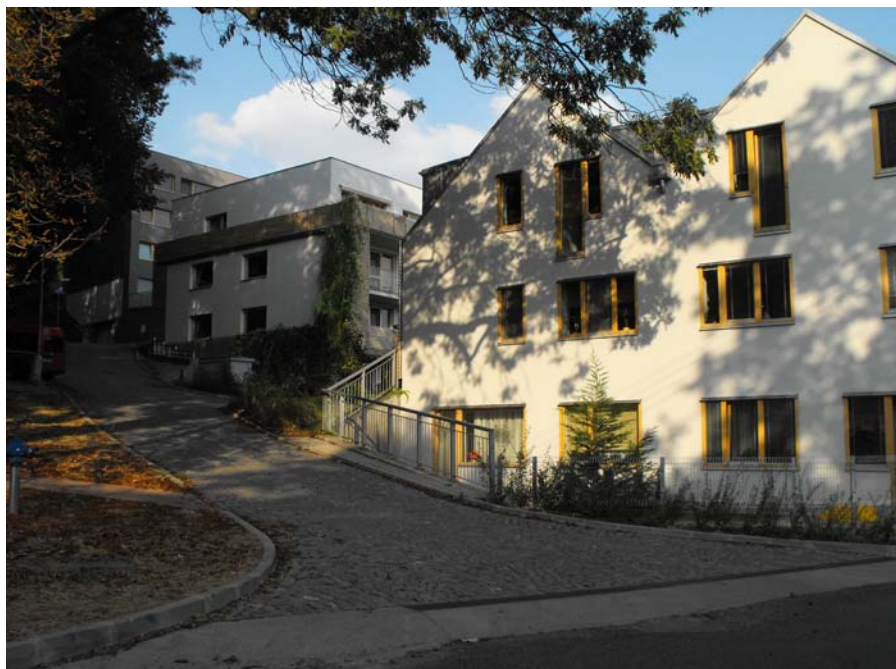
Obr. č. 11 Bytová zástavba v Klecanech
