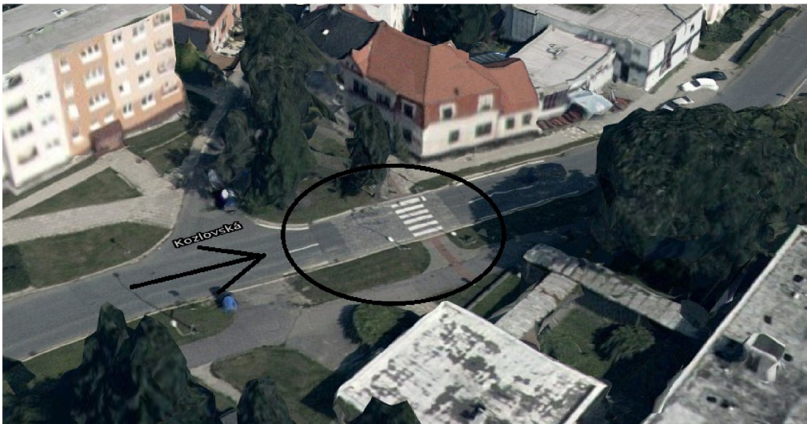
Obr. 3.2 Zpomalovací retardér na ulici Kozlovská
