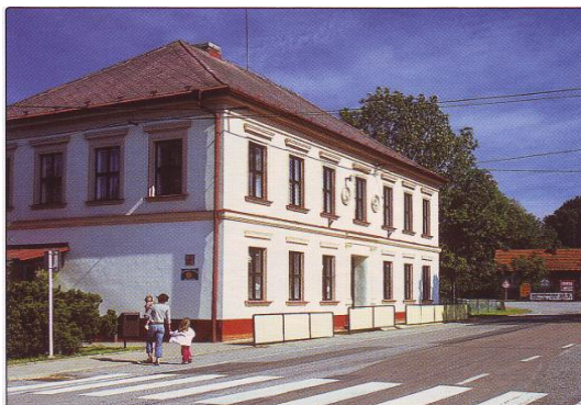
Bačetín – budova školy
