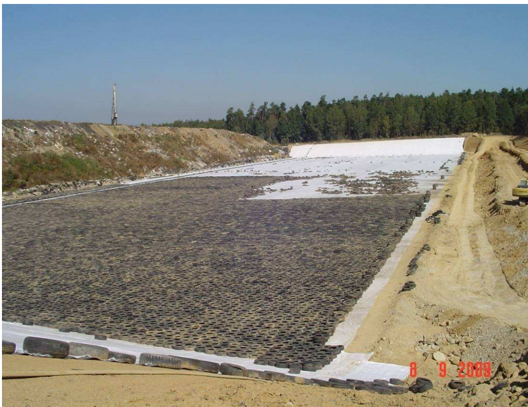
Příloha č. 8: Pohled na nově vznikající kazetu skládky č. VI, 8. 9. 2009
