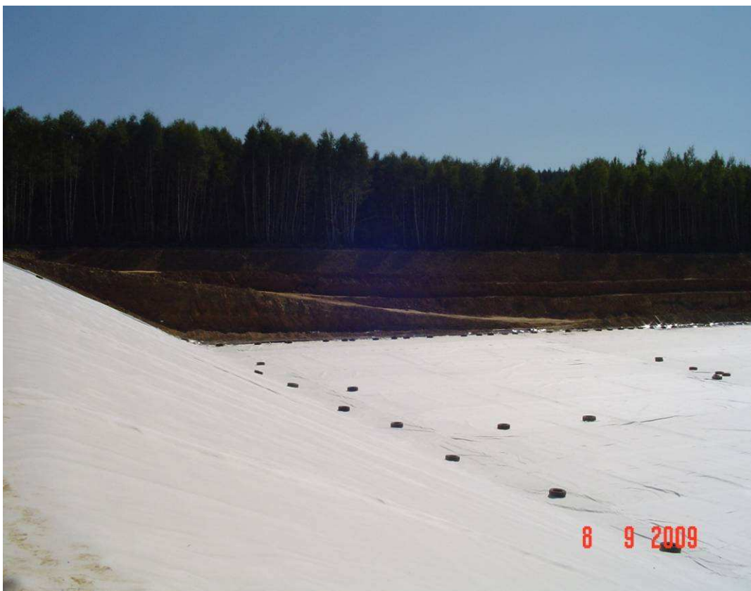
Příloha č. 10: Izolační těsnění svahu skládky, 8. 9. 2009
