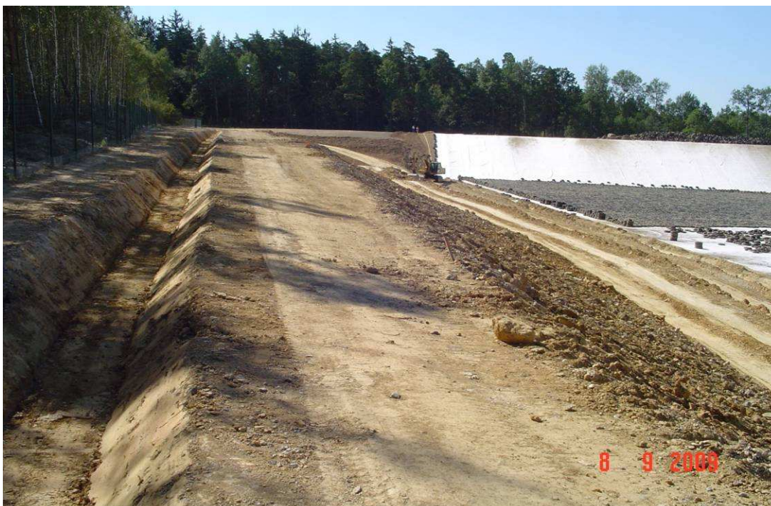
Příloha č. 9: Obvodový záchytný příkop pro odvádění vnějších vod, 8. 9. 2009
