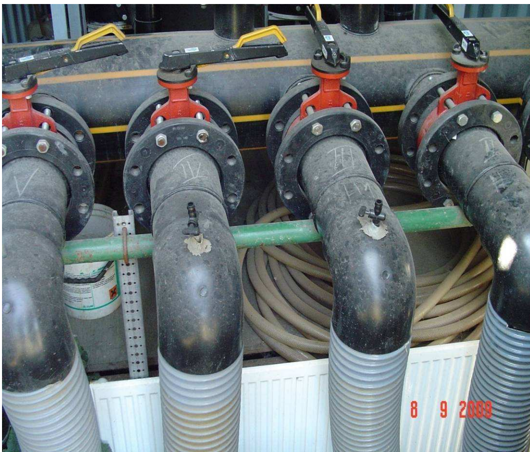
Příloha č. 12: Tok skládkového plynu směrem ke KGJ, 8. 9. 2009
