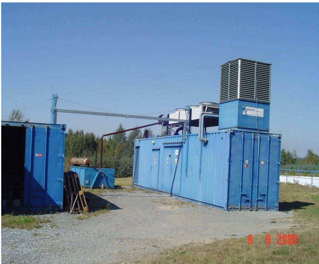
Příloha č. 15: Výroba elektrické energie prostřednictvím KGJ do veřejné sítě, 8. 9. 2009
