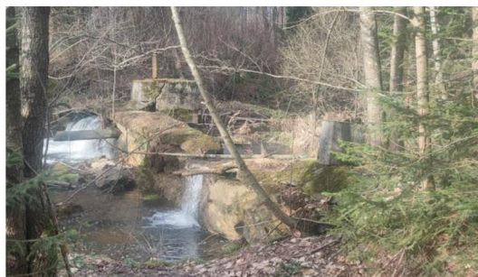
Obr. 7: Skládaná hráz, severní pohled
