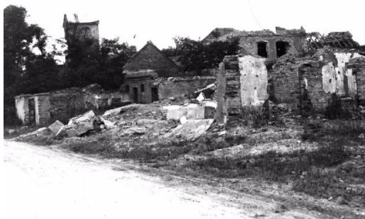
Obr. č. 16: Pohled na poničené Jiřice v roce 1945, zdroj: Šonská (2017)
