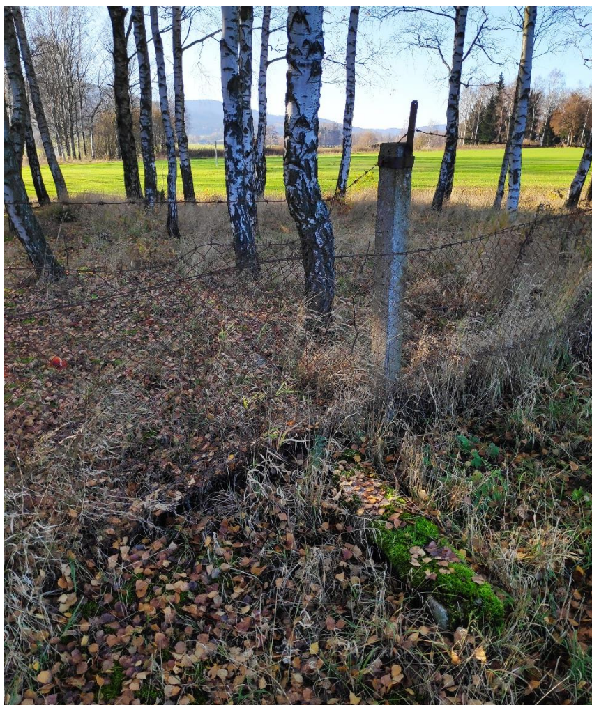
Obr. 46: Pozůstatek protitankového příkopu mezi K-S 17 a K-S 18, překryt hřištěm.
