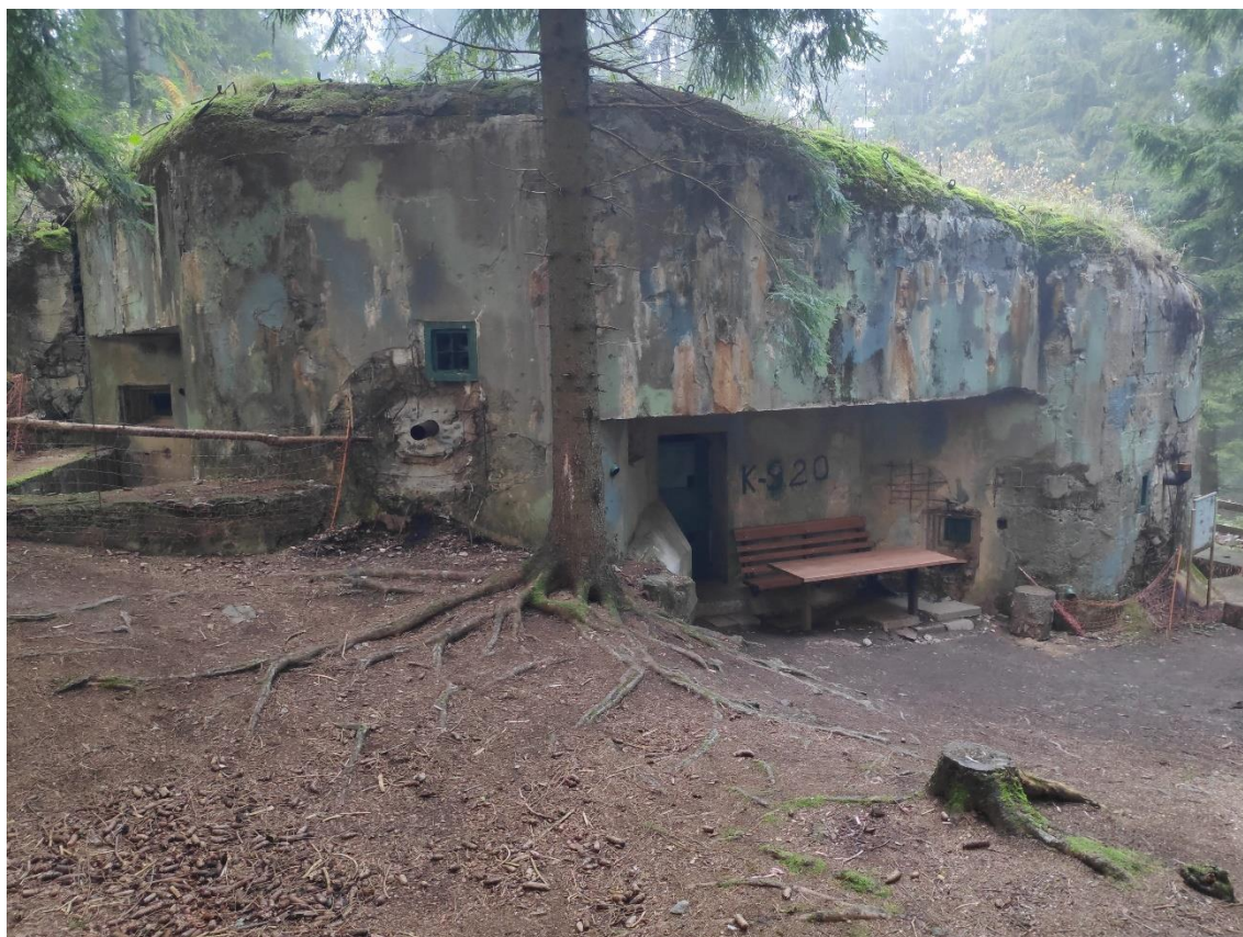
Obr. 29: Pozůstatky maskovacího nátěru a oplocené diamantové příkopy u K-S 20.
