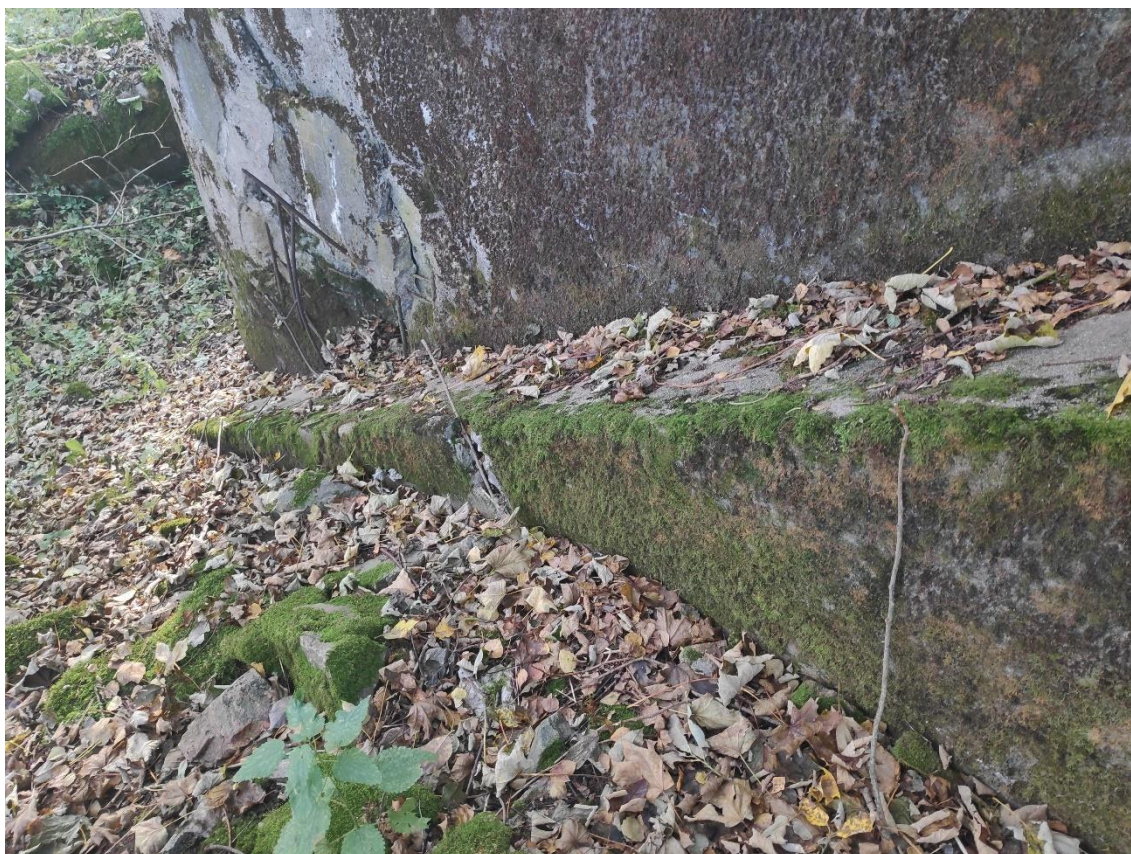
Obr. 13: Betonová rampa vedoucí na střechu objektu K-S 9.
