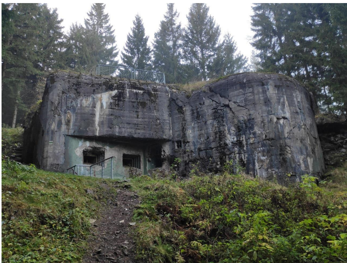
Obr. 30: K-Ba-S 21 se nachází v prudkém svahu. Na snímku je viditelné oplocení diamantového příkopu i stropnice.
