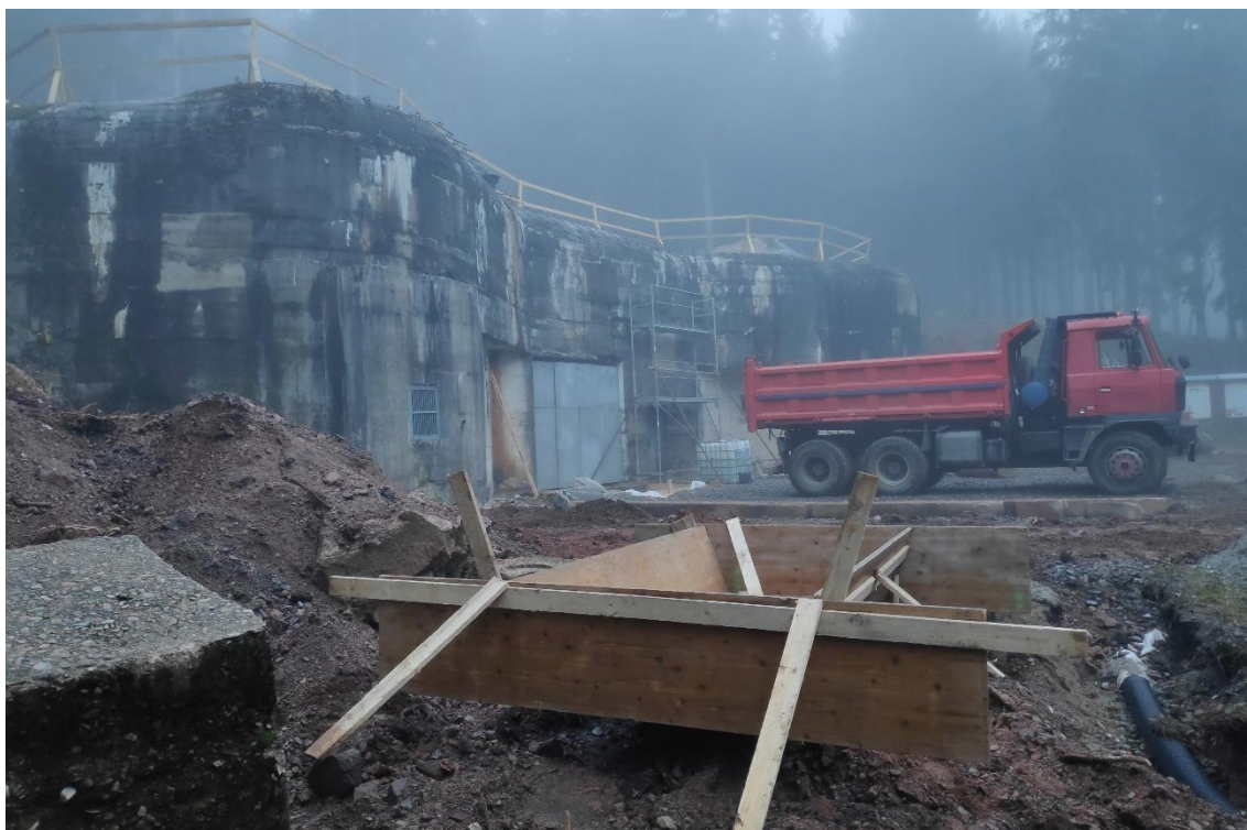
Obr. 32: Rozsáhlá rekonstrukce vchodového objektu K-Ba-S 22a v době pandemie.
