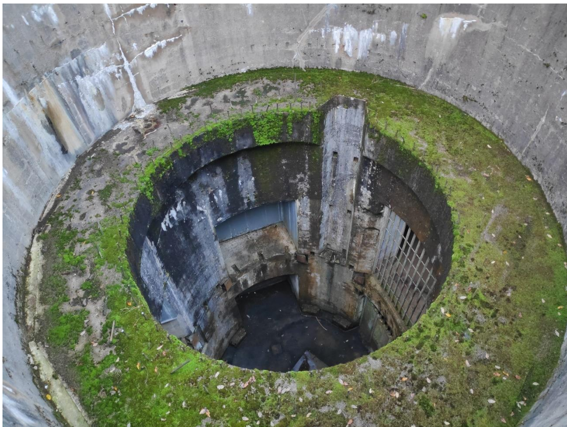
Obr. 31: Pohled do prohlubně, ve které měla být instalována otočná výsuvná věž.
