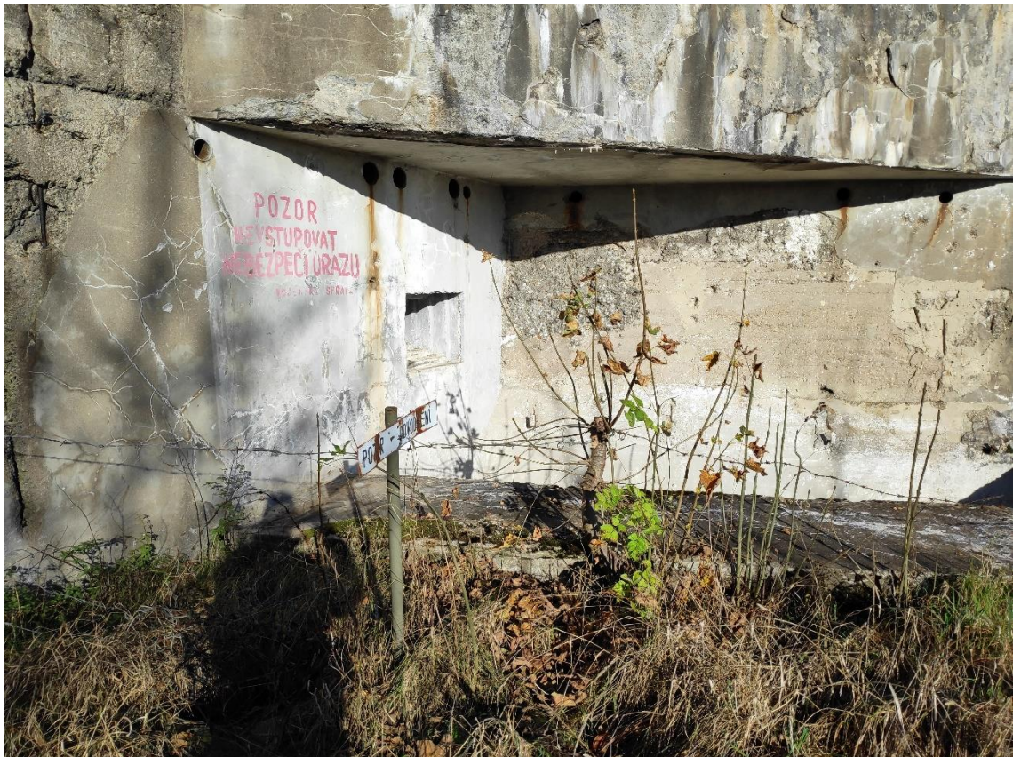
Obr. 23: Ostnatým drátem oplocený diamantový příkop u K-S 15, zabetonované střílny.
