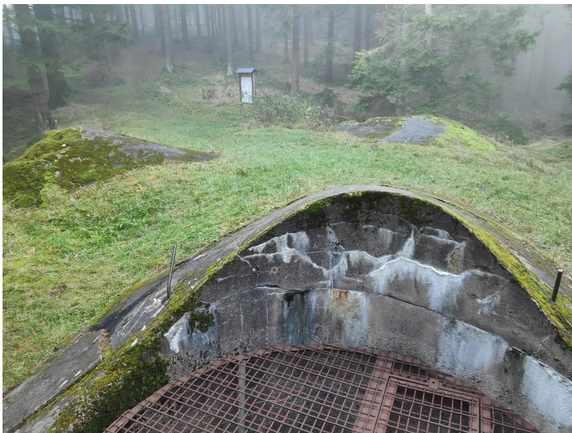
Obr. 34: Dle hladkého, nepoškozeného betonu je zřejmé, že stropní pancéřové prvky nebyly na K-Ba-S 23 nikdy osazený.
