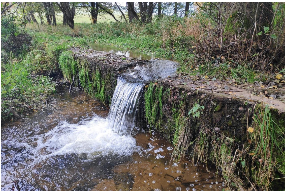
Obr. 38: Železobetonový práh mezi K-S 4 a K-S 5 protíná potok.
