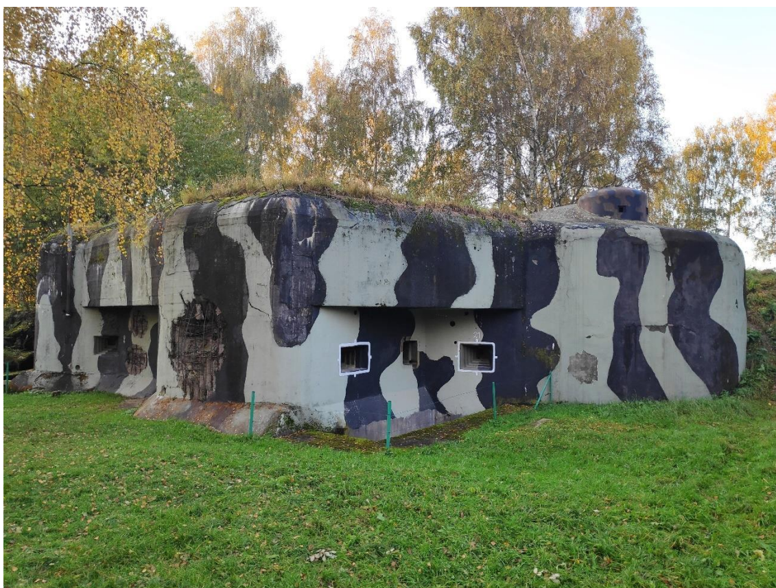
Obr. 11: K-S 8 s atrapami pancéřových zvonů a obnoveným kamuflážním nátěrem.
