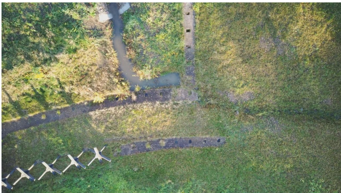
Obr. 43: Rozsocháče a zdvojený železobetonový práh u K-S 14, záběr z nízkoletícího dronu.
